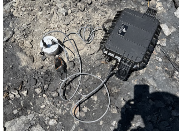
(b) Sismógrafo DAQ y su registrador.
