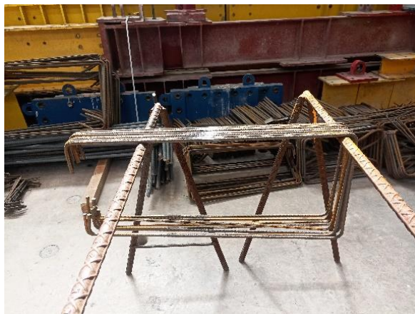
Figura 2.5 Habilitado de acero.
