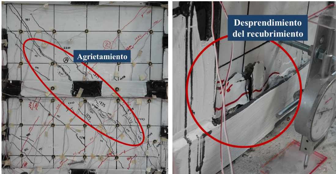
Figura 3.8 A la izquierda: grieta de control A. A la derecha: desprendimiento del recubrimiento de la cara Este (ciclo 7, distorsión +2%).
