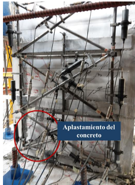
Figura 3.26 Aplastamiento del concreto en la cara Sur (ciclo 14, distorsión -3.5\% ).
