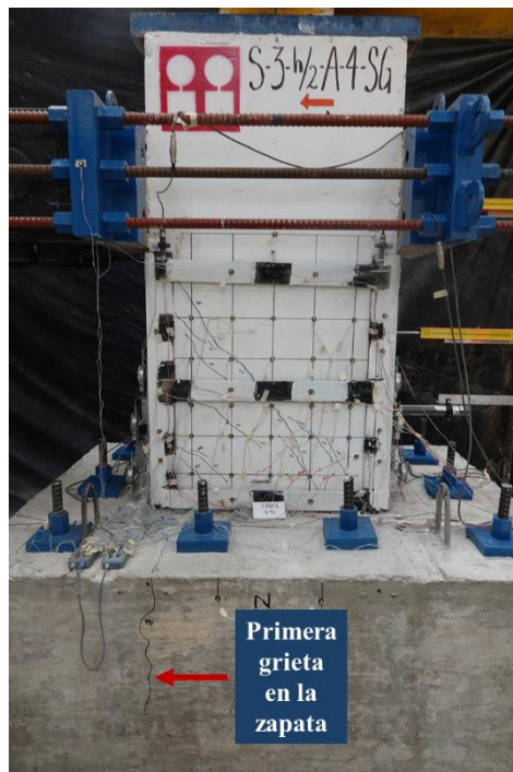
Figura 3.5 Aparición de la primera grieta en la zapata en la cara Norte (ciclo 3, distorsión +1%).
