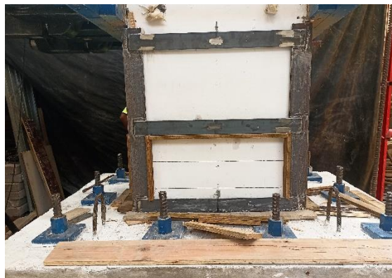
Figura 2.13 Cimbra para colocar el grout.
