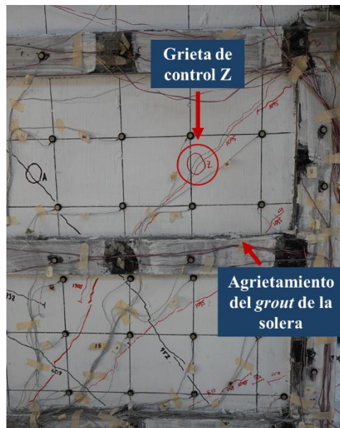
Figura 3.19 Grieta de control Z y agrietamiento del grout en la cara Norte (ciclo 3, distorsión -1%).
