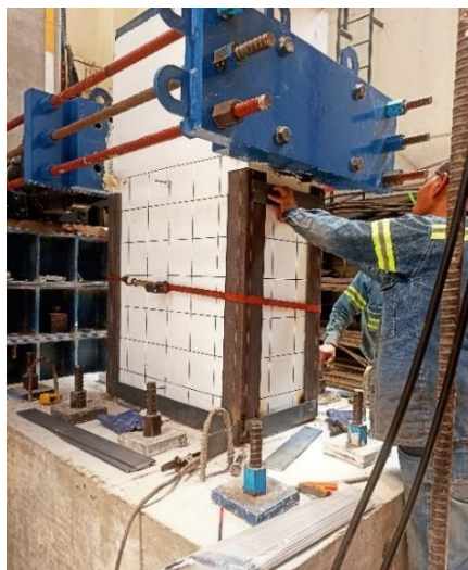
Figura 2.11 Elaboración del encamisado que no lleva grout como medio de contacto.
