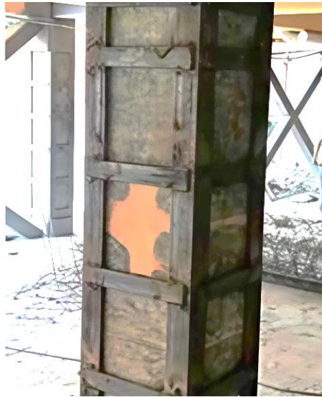
Figura 1.7 Columna encamisada con acero (Alcocer et al., 2019).
