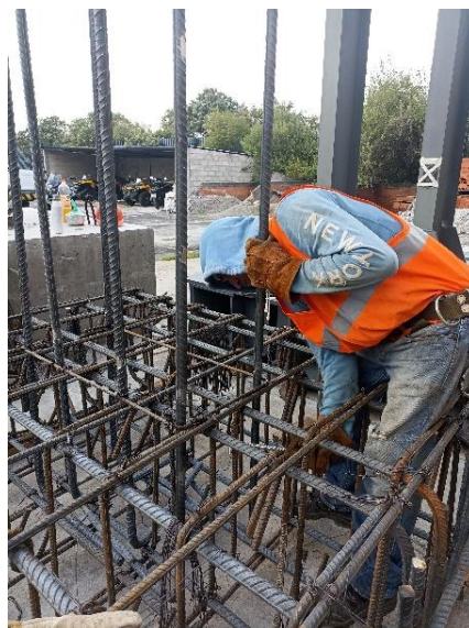
Figura 2.6 Realización del armado de acero.
