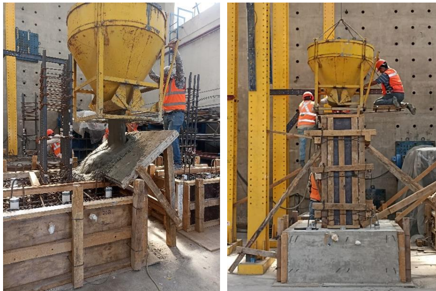
Figura 2.10 Colocación del concreto. A la izquierda de la zapata, a la derecha de la columna.
