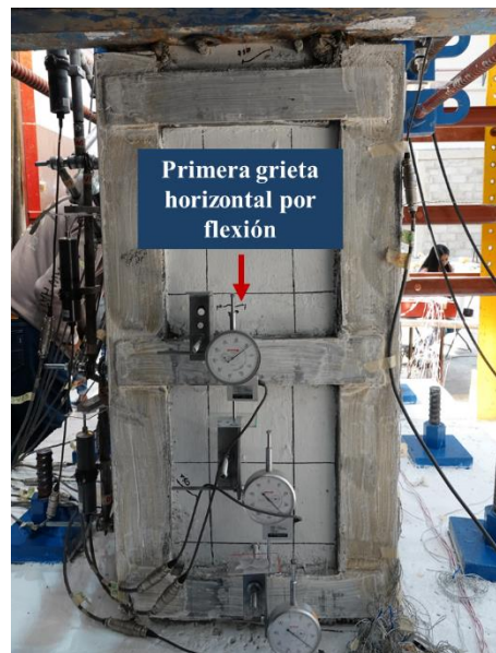
Figura 3.17 Aparición de la primera grieta horizontal por flexión en la cara Este (ciclo 2, distorsión ++0.5\% ).
