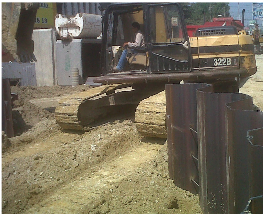
Figura 7. Tablestaca colocada sobre el perímetro de la excavación e inicio de la excavación. Autoría propia.
