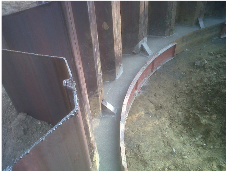
Figura 8. Troquelado con anillo de concreto reforzado. Autoría propia.
