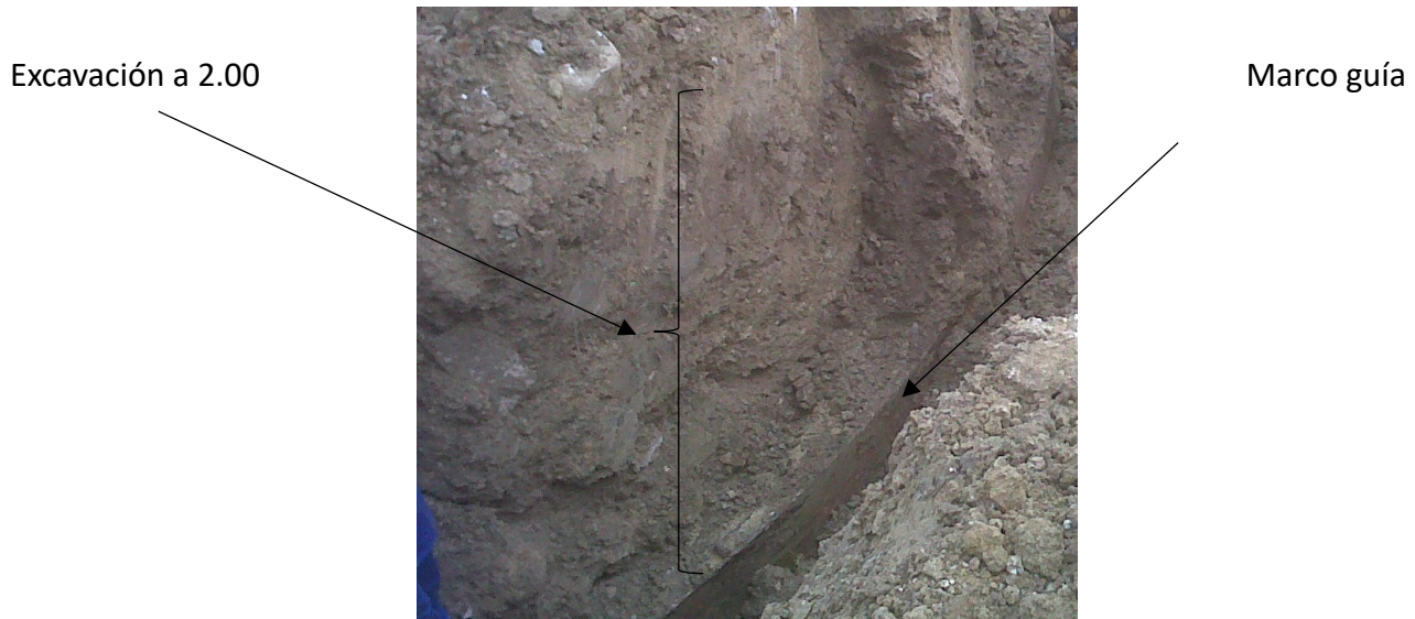
Figura 6. Excavación y colocación de anillo guía. Autoría propia.
