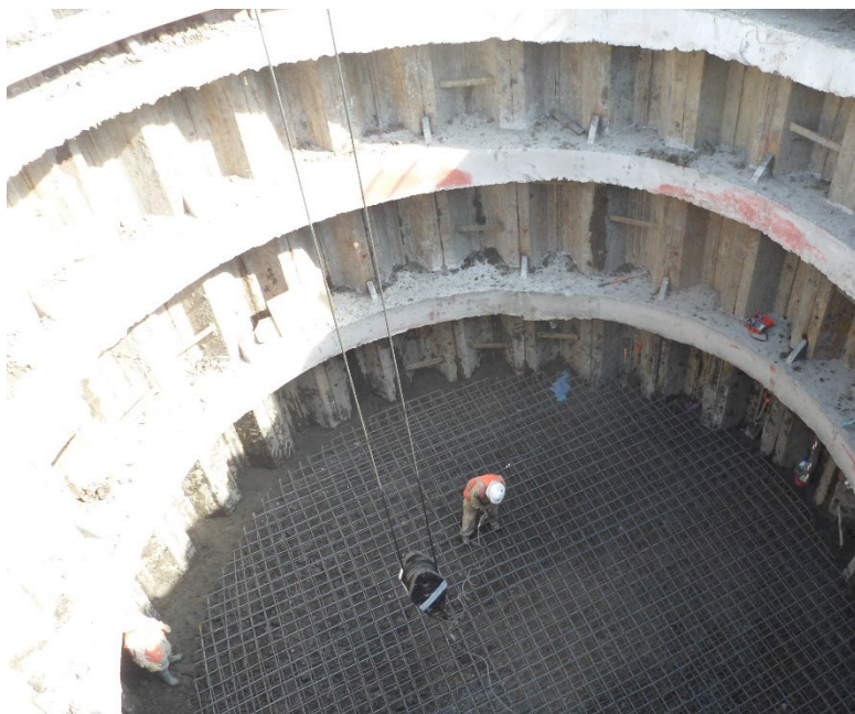
Figura 10. Construcción de losa de fondo. Autoría propia.
