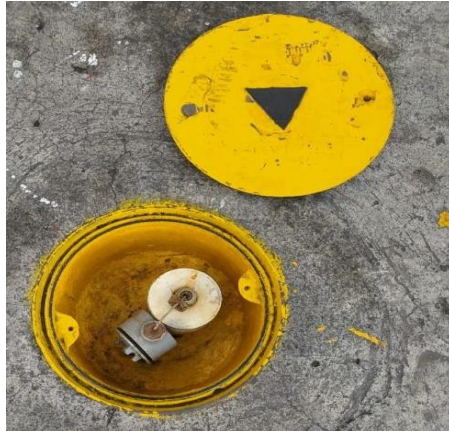
Imagen 21. Pozo de monitoreo. Tomada en sitio.
