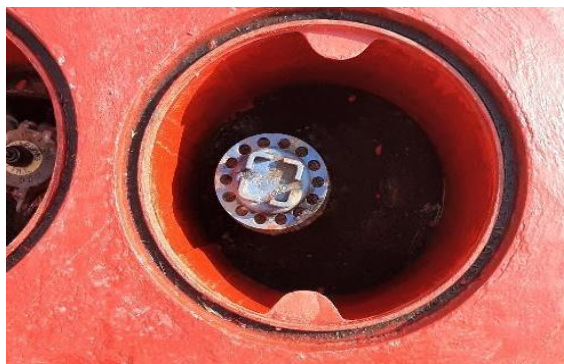
Imagen 14. Registro de purga de tanque Premium. Tomada en sitio.
