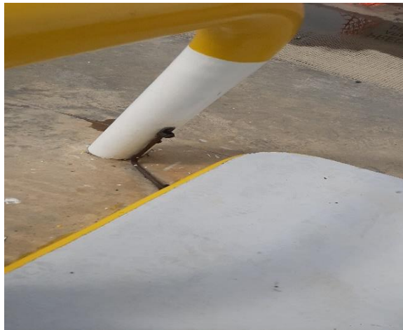
Imagen 24. Portería aterrizada. Tomada en sitio.
