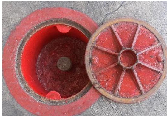
Imagen 13. Registro de purga de tanque Premium con tapa. Tomada en sitio.
