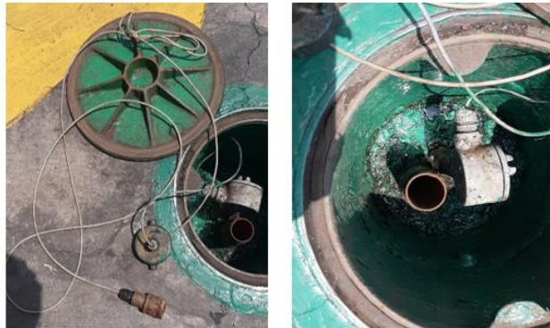
Imagen 12. Registros de espacio anular de tanque regular. Tomada en sitio.
