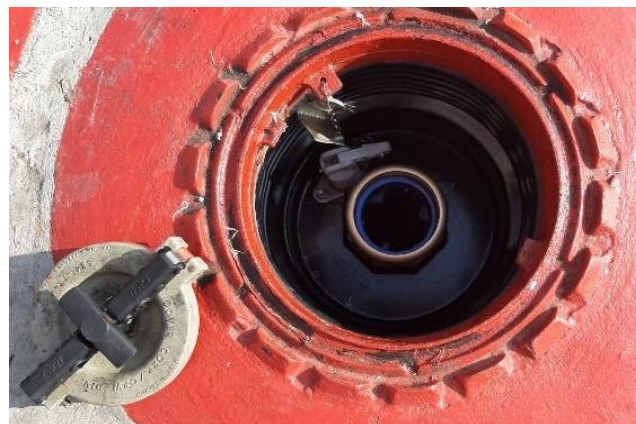
Imagen 18. Registro de llenado de tanque Premium. Tomada en sitio.
