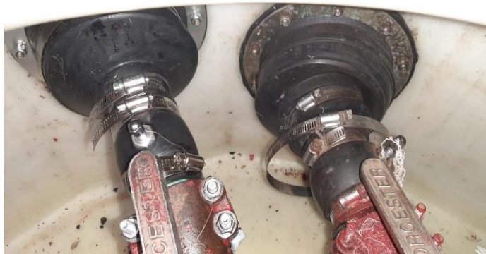
Imagen 5. Sellos mecánicos (botas) con abrazadera suelta. Tomada en sitio.
