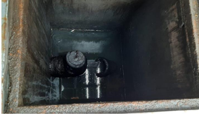
Imagen 39. Fase menos densa de la trampa de grasas. Tomada en sitio.
