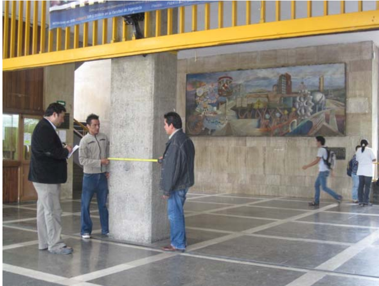
Imagen 12 Levantamiento en sitio (Columnas rectangulares)
