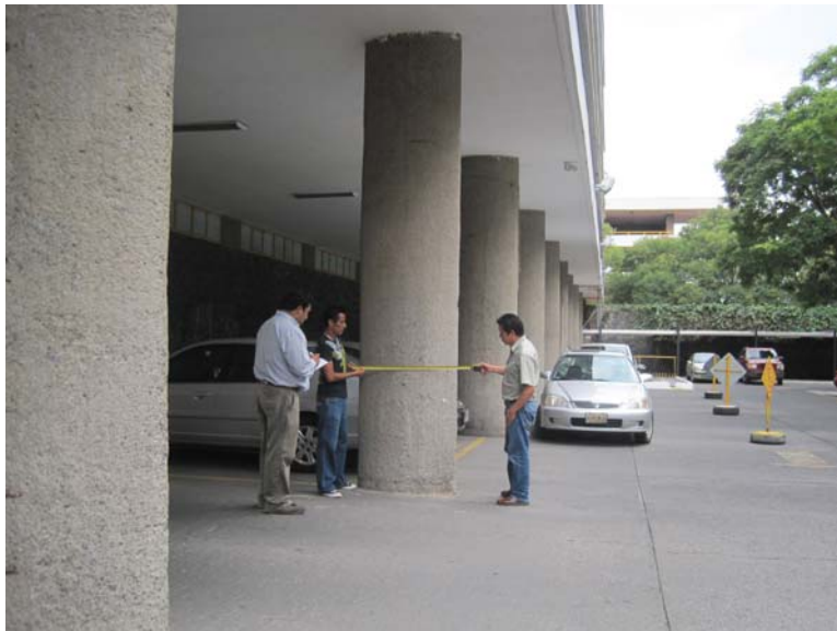
Imagen 13 Levantamiento en sitio (Columnas elípticas)
