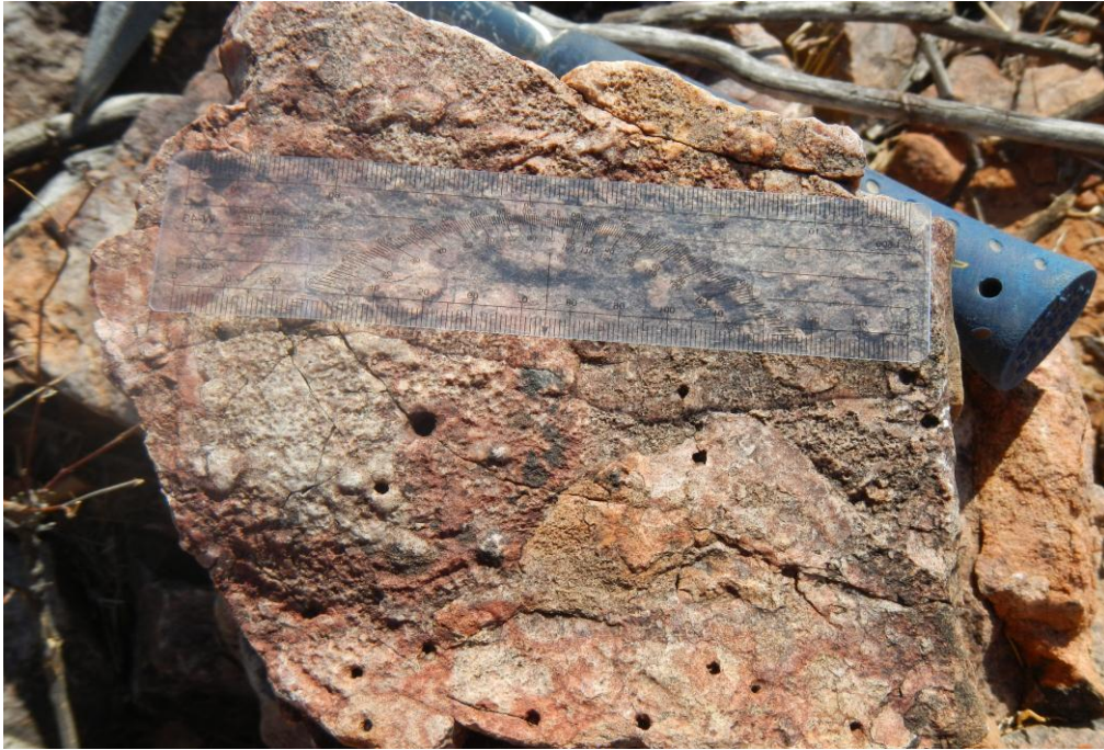
Figura 16. Orificios de entrada y salida de la galería.
