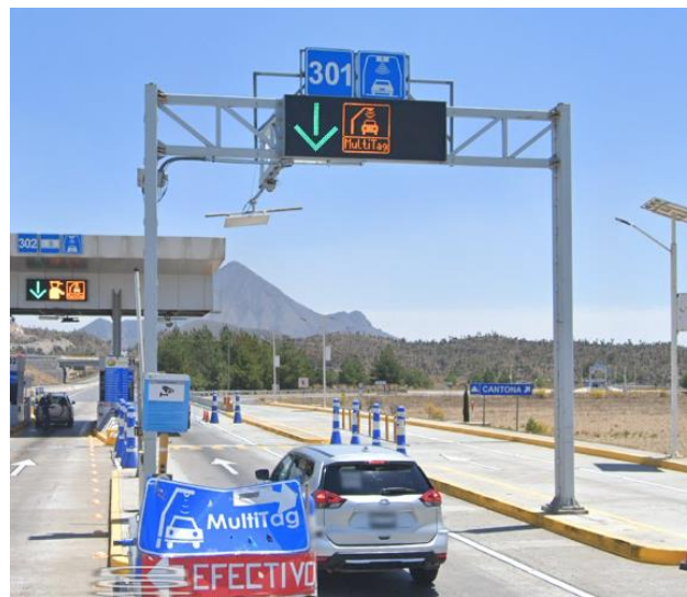
Figura 32 Sistema de Telepeaje en Plaza de Cobro Cantona en la Autopista Amozoc – Perote
