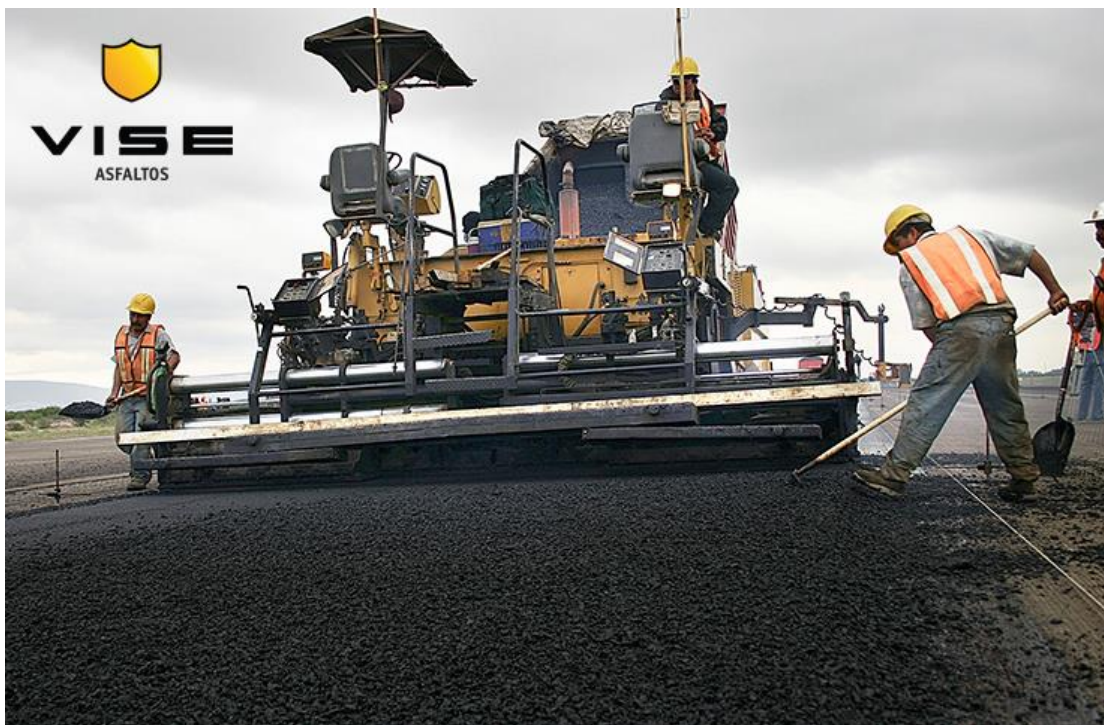
Figura. 2.6.1 Tendido de mezclas asfálticas para la construcción de pavimento (VISE, 2018)
