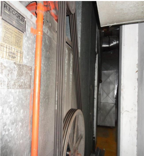
Foto 3.5. Bandas en buen estado y Flecha de turbina con sarro y desbalanceado. (Fuente Levantamiento Aeropuerto Tampico)
