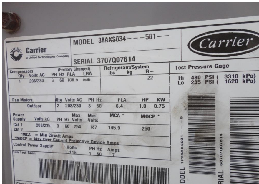
Foto 3.11. Características mecánicas y eléctricas de U.C-03.
