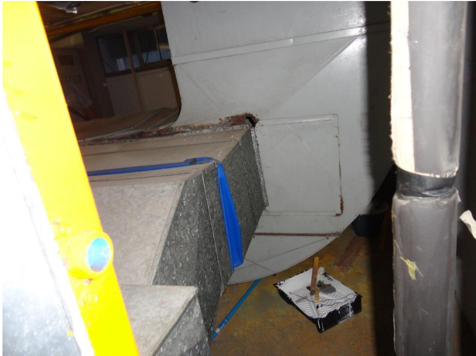
Foto 3.20. Presencia de orificios en ductos principales de inyección Unidad Manejadora de Aire UMA-09. (Fuente Levantamiento Aeropuerto Tampico)
