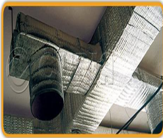
Foto 2.3 Aislamiento térmico para ductos interiores y para ductos expuestos a la intemperie (Fuente: tecnoclima.com.mx)
