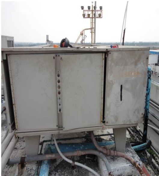
Foto 3.8. Gabinete de U.C. en mal estado y Medición de detección de fuga de gas Refrigerante R-22.
