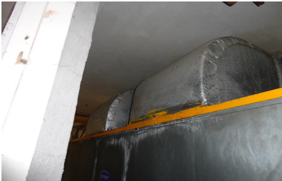
Foto 3.20. Presencia de orificios en ductos principales de inyección Unidad Manejadora de Aire UMA-09. (Fuente Levantamiento Aeropuerto Tampico)
