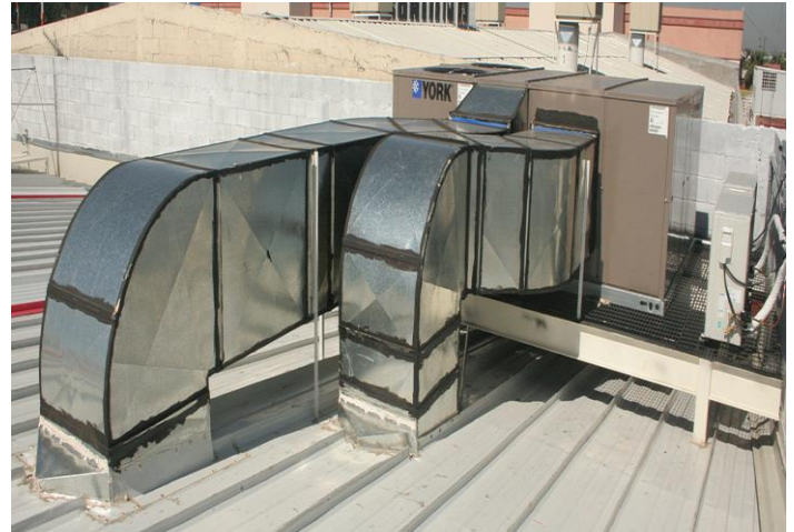
Foto 2.3 Aislamiento térmico para ductos interiores y para ductos expuestos a la intemperie (Fuente: tecnoclima.com.mx)
