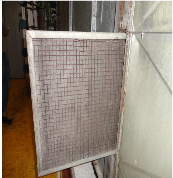
Foto 3.4. Filtro sucio y desmontaje de filtro para su revisión.
