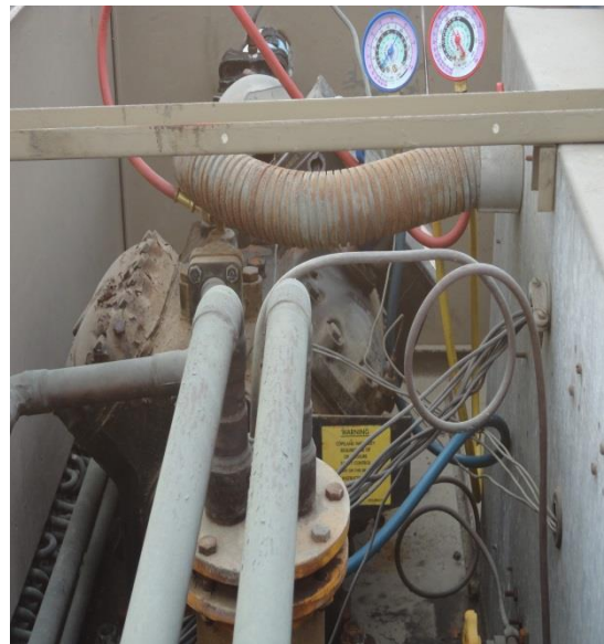
Foto 3.8. Gabinete de U.C. en mal estado y Medición de detección de fuga de gas Refrigerante R-22.
