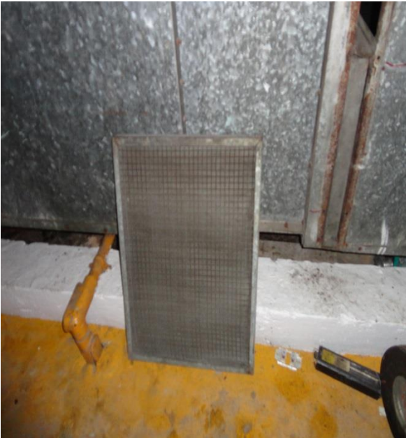
Foto 3.4. Filtro sucio y desmontaje de filtro para su revisión.
