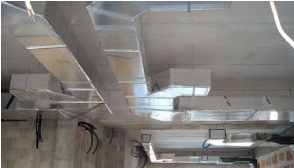
Foto 2.1 Instalación de ductos de Aire Acondicionado (Fuente Torre Bancomer Polanco Nivel 2)
