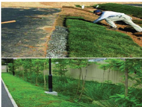
Parterre en carretera. Fuente: Springer Open, 2012
