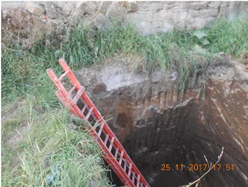
Foto No. 4.- Perfil estratigráfico del pozo a cielo abierto No. 3 (PCA-03). Tanto la estratigrafía como la consistencia son iguales a lo que se observó en el PCA-01.
