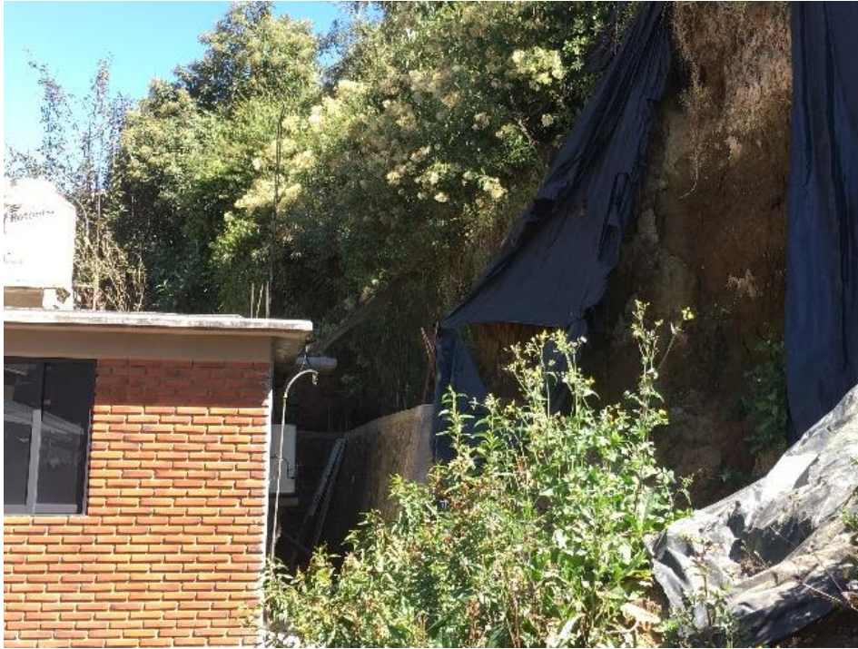
Figura 4. Talud de 90°, realizado para edificar una casa
