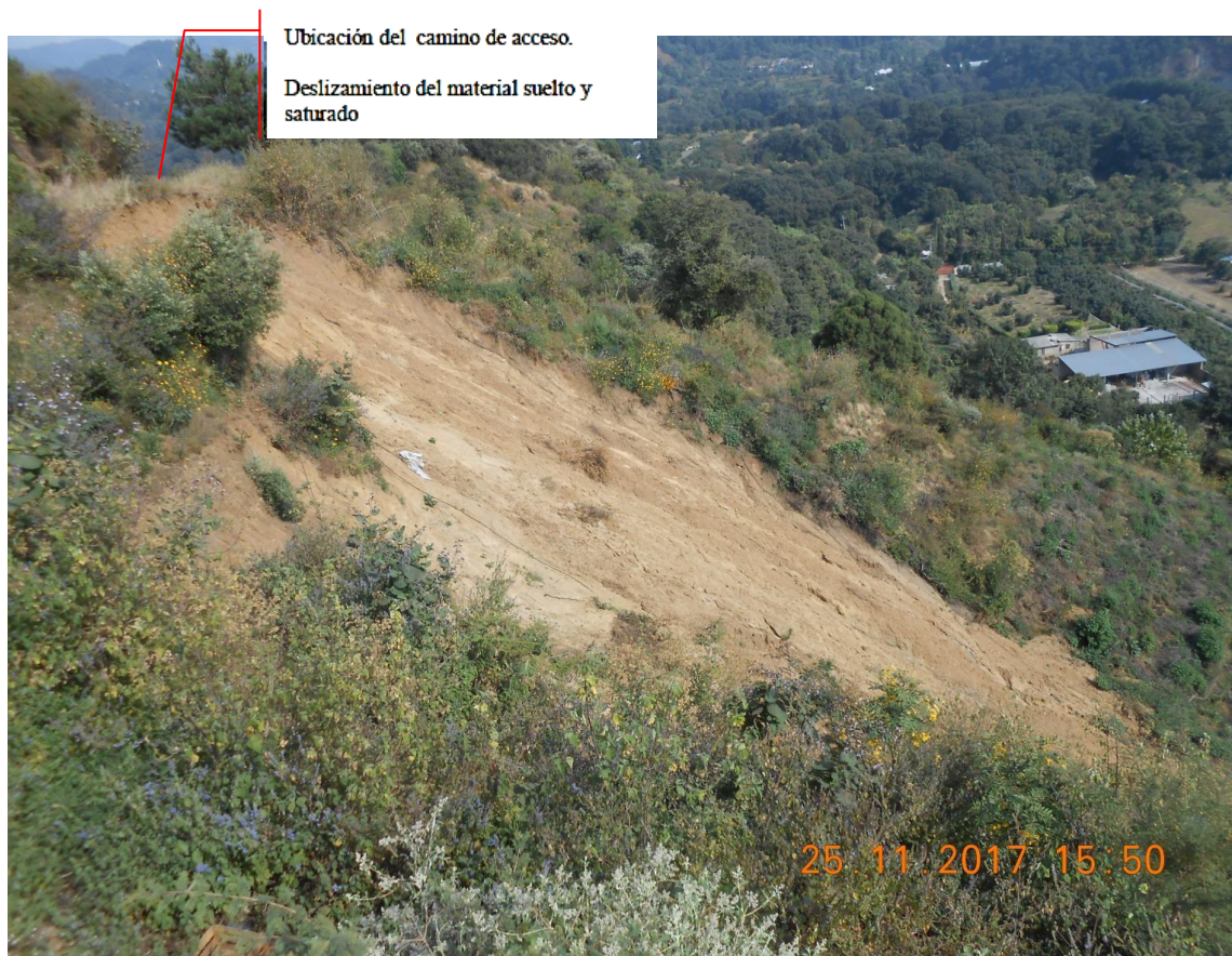
Foto No. 12.- Deslizamiento de material en una ladera en Lomas Lindas. Se observa que solo se desplazó el material suelto superficial (del orden de 50cm de espesor), que no hay escalones de liga en el terreno natural para recibir el terraplén del camino, que el terreno natural es una toba y que no se desplazó salvo la capa vegetal, no se observaron grietas en el cuerpo del terreno natural. Se concluye que solo se movió el suelo suelto colocado durante la construcción del camino.
