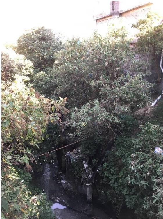
Figura 9. Ladera erosionada con presencia de basura
