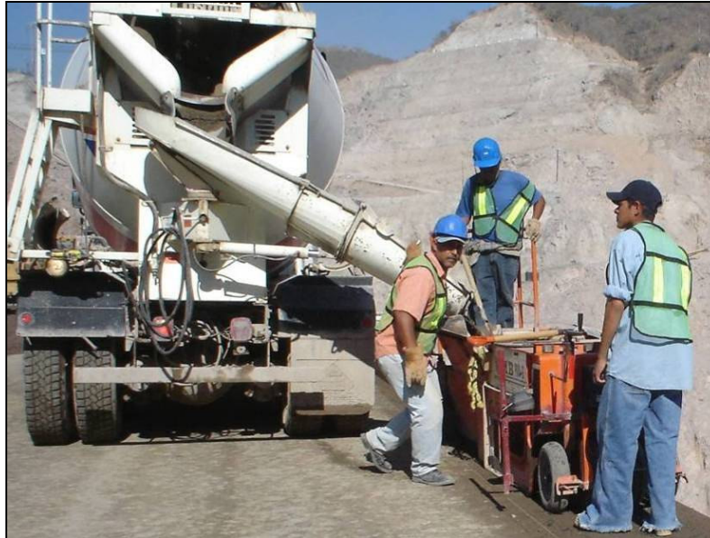
FIGURA II.47 DESCARGA DE CONCRETO A LA MÁQUINA BORDILLERA PARA LA CONSTRUCCIÓN DEL BORDILLO
