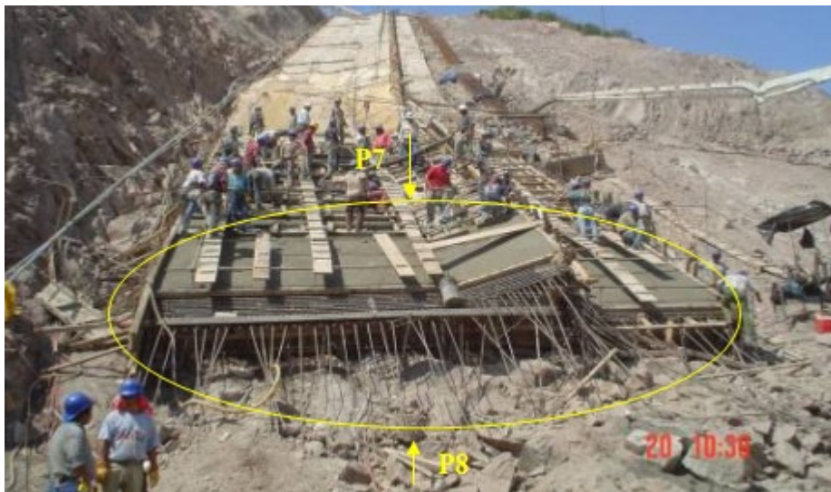
FIGURA II.43 COLOCACIÓN DE CONCRETO CON MOTOBOMBA ENTRE LOS PUNTOS P7 Y P8
