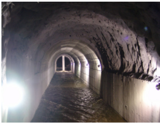
FIGURA II.7 OBRA DE DESVÍO DEL P.H. EL CAJÓN, NAY.
