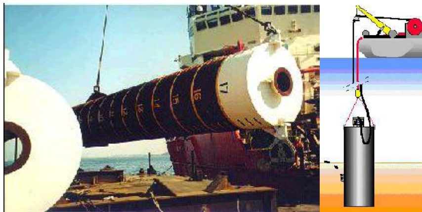
Figura 2.14 Pilotes hincados por succión
