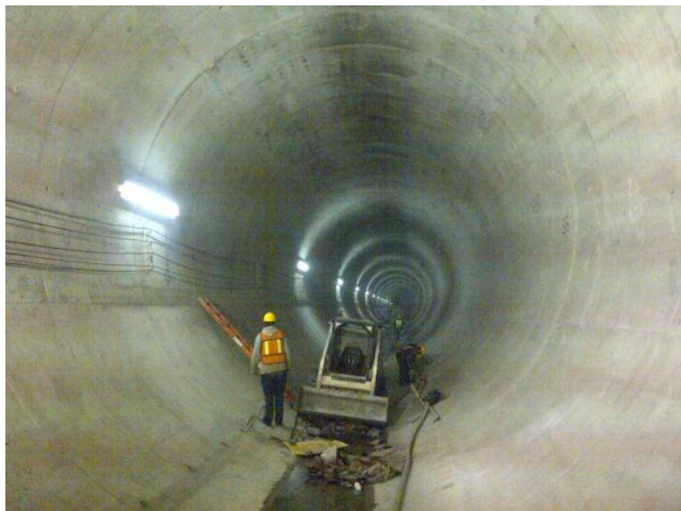
Imagen 4. 4 Acabado final con un diámetro de 7 metros
