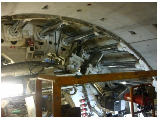
Imagen 3. 16 Gatos hidráulicos empujando la cabeza de la tuneladora, apoyados en el último anillo de dovelas
