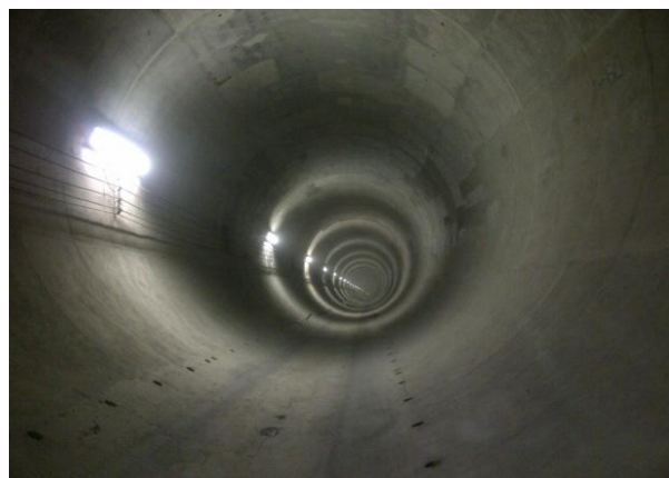
Imagen 3. 30 Acabado definitivo del Túnel Emisor Oriente
