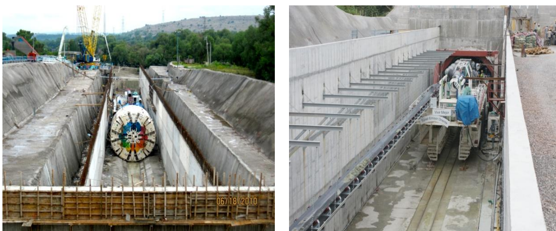
Imagen 3. 1 TBM en el portal de salida
