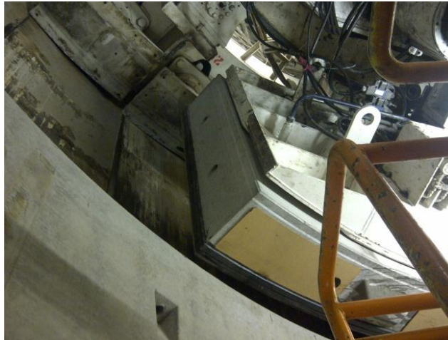
Imagen 3. 17 Colocación de dovelas con el anillo erector
