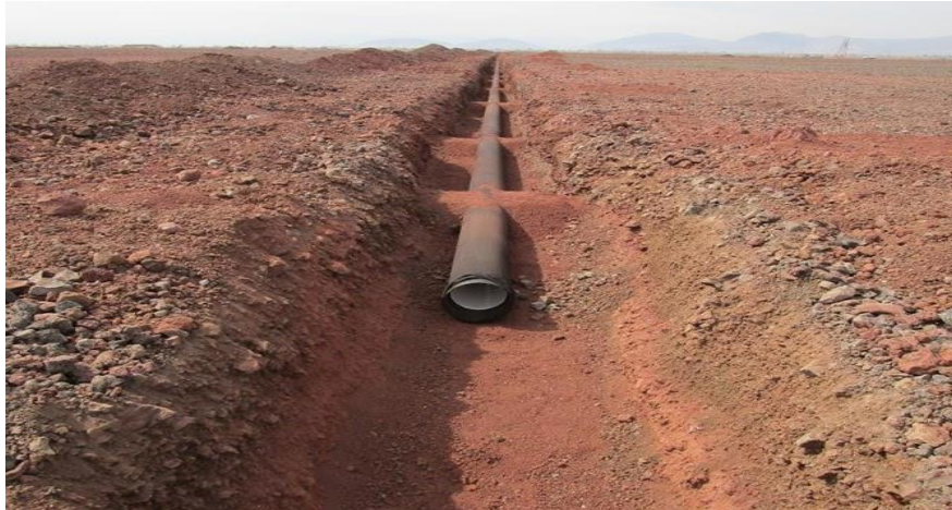
Figura 2.13 Drenaje horizontal de agua de precarga hacia los drenes THPD
