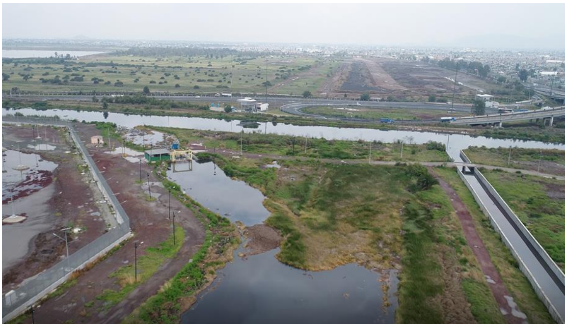
Figura 4.17 Aspecto del DTN al exterior del polígono del NAICM.
