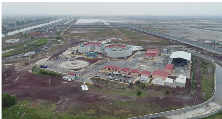
Figura 4.13 Aspecto general de la Laguna de Regulación Casa Colorada.
