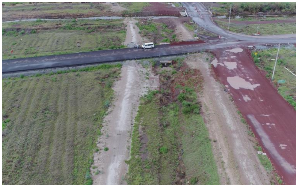
Figura 4.2 Condición del DPTM-3 y su descarga hacia el Dren Texcoco Norte
