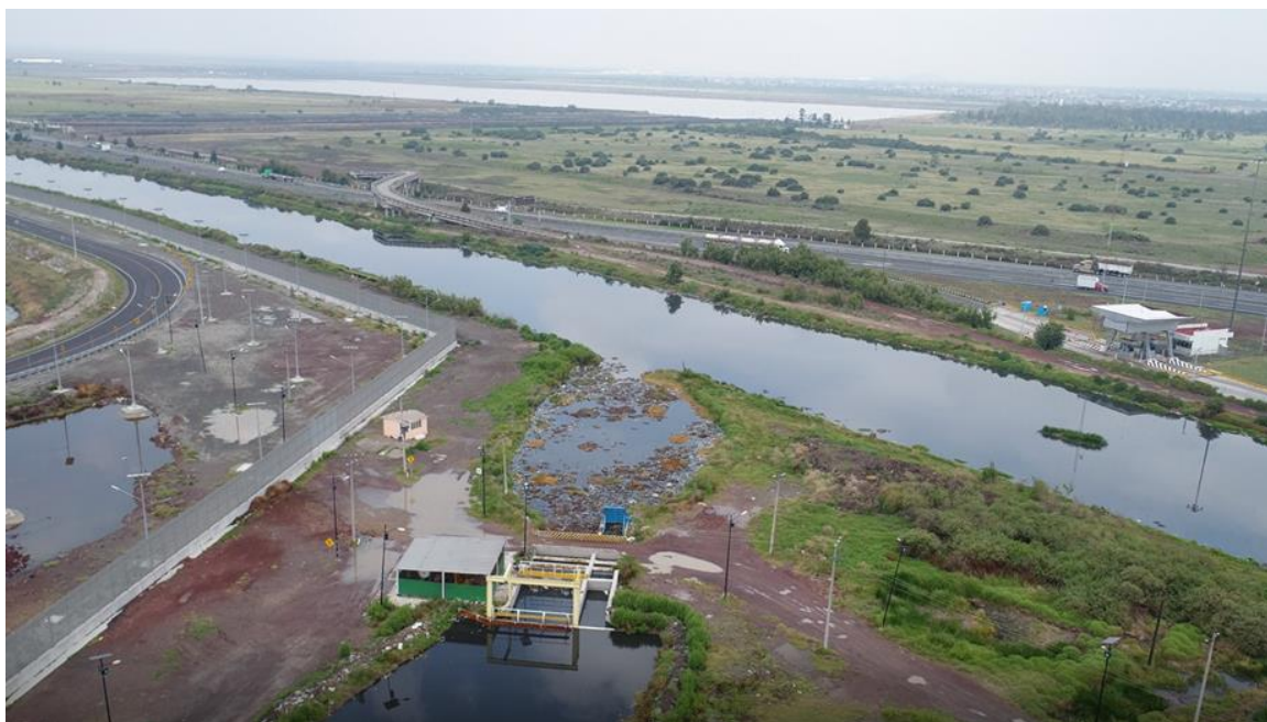
Figura 4.18 Detalle de la estructura hidráulica ubicada sobre el Dren Texcoco Norte.
