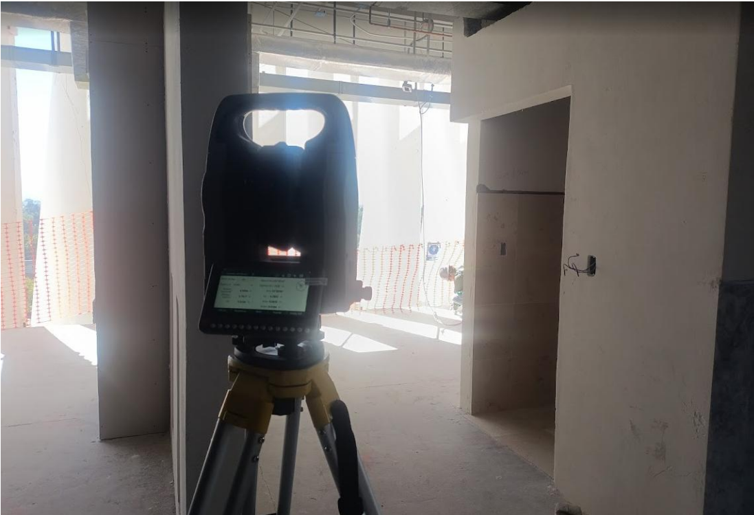
Ilustración 18. Trazo de referencias para alineamiento de cancelería exterior. Elaboración propia.
