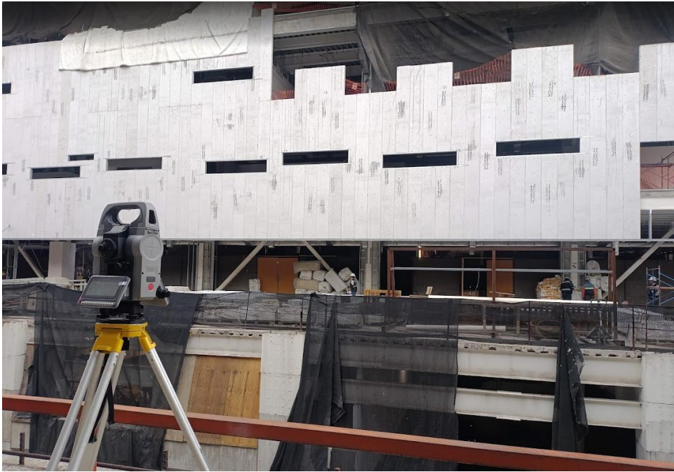
Ilustración 28. Monitoreo en campo de paneles en fachada posterior. Elaboración propia.
