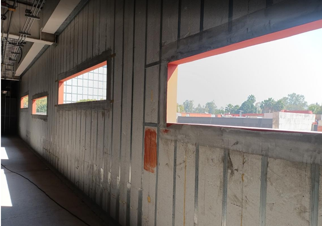
Ilustración 29. Ventanas de fachada visto desde el interior. Elaboración propia.
