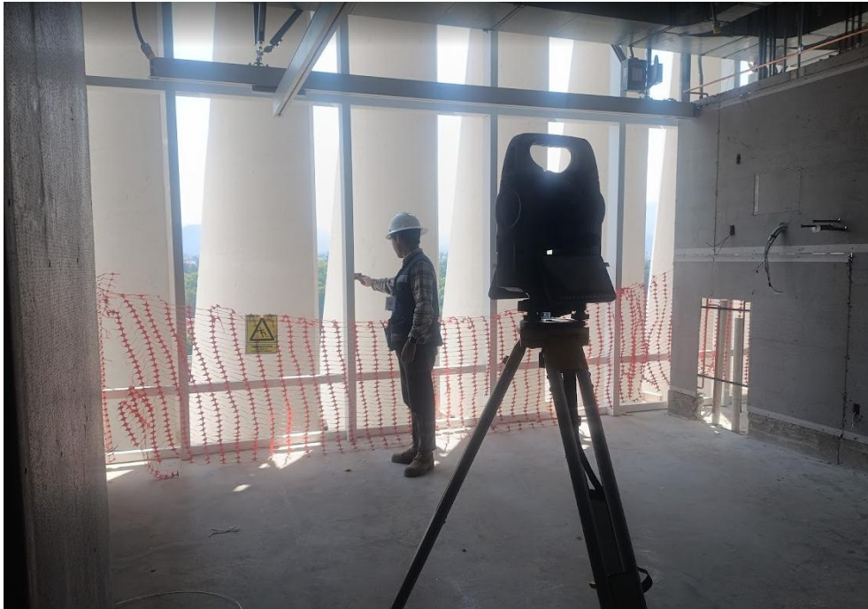
Ilustración 20. Monitoreo de alineamiento y verticalidad de soporte de cancelería. Elaboración propia.
