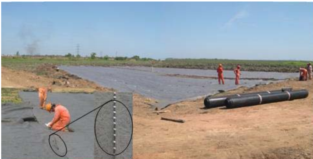
Figura No. 8.5 Costura del geotextil y tendido del mismo. También se aprecia los rollos en que los proporciona el proveedor.
