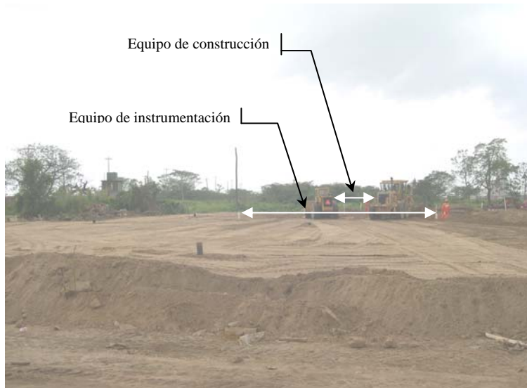
Figura No. 5.11. Fotografía que muestra la ubicación de la instrumentación (en este caso placas para registrar el asentamiento del terreno de apoyo) y el espacio que ocupa el equipo de construcción.
