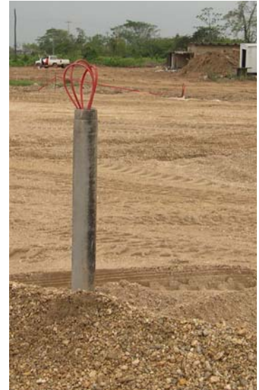
Figura No. 8.3 Extremos superiores de los tubos (rojos) del piezómetro hidráulico y camisa protectora de acero para evitar daños por el paso del equipo de construcción y de personal.
