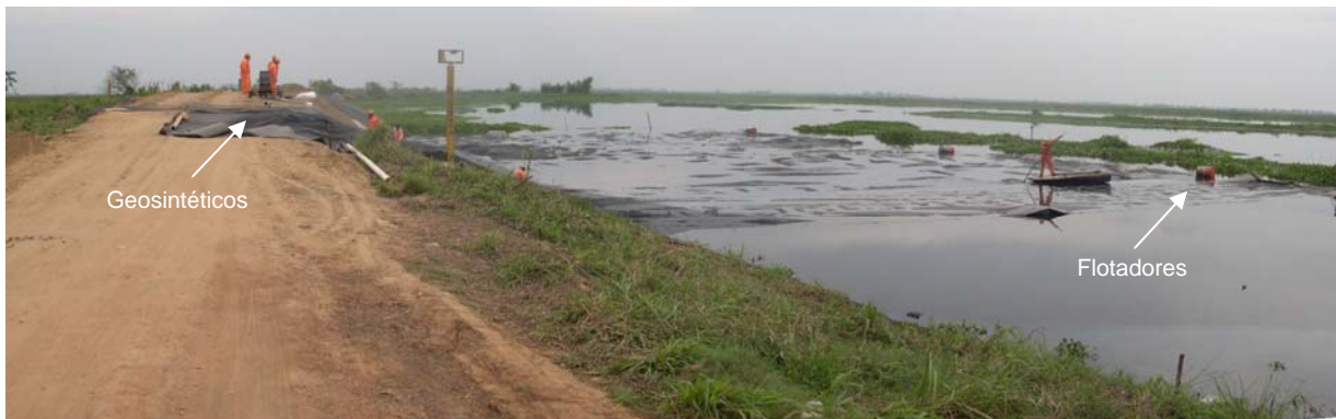
Figura No. 8.11 Fotografía que muestra las condiciones de la zona en que se construiría el TR-5, y la colocación de los primeros geosintéticos.
