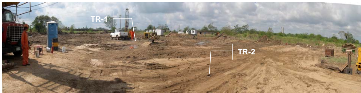
Fig. 3.2. Superficie despalmada en la que se construirían los TR-1 y TR-2
