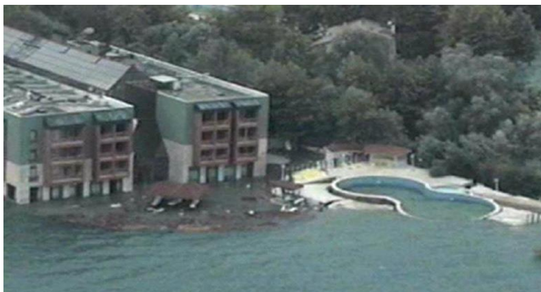
Figura 1.4. Hundimiento del hotel bajo condiciones finales de licuación (Beaty y Byrne, 1999).
