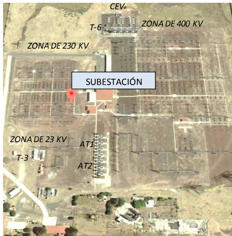
Figura 10. Vista de la Subestación
