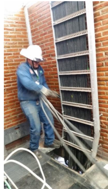
Figura 4. Fotografías que muestran el proceso de tendido de cable comenzando por el conteo de metros de cable a utilizar, el acomodo del cable en trinchera desde las bahías de 230 kV hacia la caseta de control para su destino en el tablero de la protección 87B.
