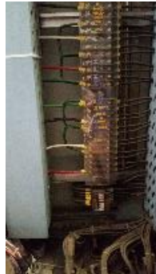
Figura 8. Fotografía que muestra el proceso de conexión de los cables de control y de corrientes en cada una de las bahías de 230 kV.
