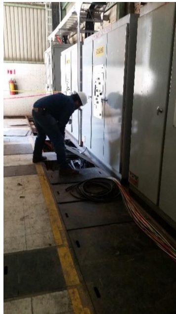
Figura 4. Fotografías que muestran el proceso de tendido de cable comenzando por el conteo de metros de cable a utilizar, el acomodo del cable en trinchera desde las bahías de 230 kV hacia la caseta de control para su destino en el tablero de la protección 87B.
