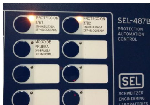
Figura 31. Botones de bloqueo y modo prueba de la protección 87B
