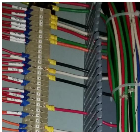
Figura 28. Fotografía de la conexión del cable de control por color de acuerdo a la cedula de cableado en el punto correspondiente.
