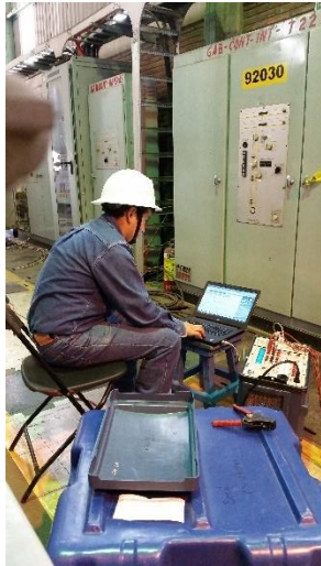
Figura 7. Fotografías que muestran el proceso de prueba de la resistencia de aislamiento a los conductores y pruebas de inyección de corriente al cable de corrientes para faseo y correspondencia de fases por cada bahía.
