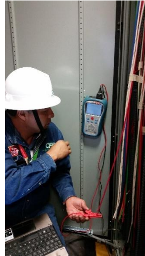
Figura 7. Fotografías que muestran el proceso de prueba de la resistencia de aislamiento a los conductores y pruebas de inyección de corriente al cable de corrientes para faseo y correspondencia de fases por cada bahía.
