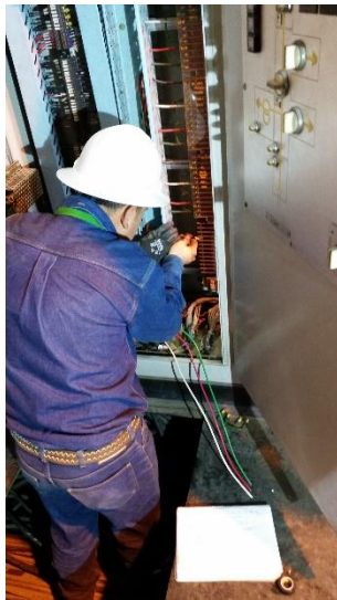
Figura 8. Fotografía que muestra el proceso de conexión de los cables de control y de corrientes en cada una de las bahías de 230 kV.
