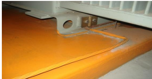
Fig.9 Conector de tierra tipo B
