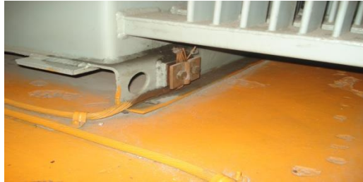
Fig.16 Derivación al transformador TR-1
