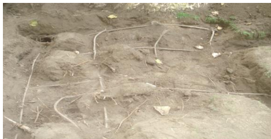
Fig.7 Mallas de tierra principales
