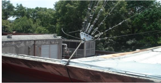
Fig. 47 Retenidas sin referencia tierra.
