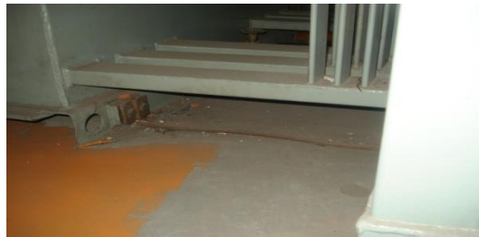
Fig.17 Conector de tierra del TR-1
