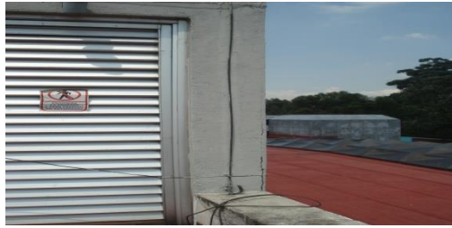
Fig.42 Anillo perimetral trozado.
