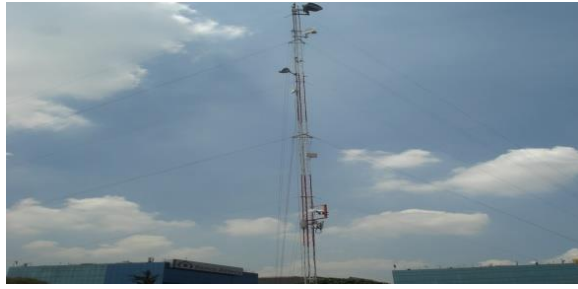
Fig.46 Torre con punta pararrayos.
