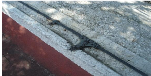
Fig.39 Conector a compresión en anillo perimetral.
