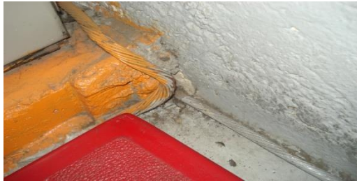
Fig.19 CPT que surge de la S.E.1
