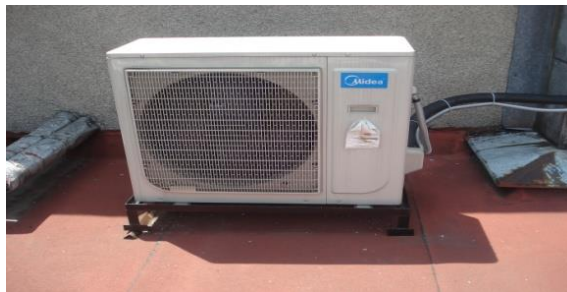
Fig.44 Equipo sin referencia a tierra.
