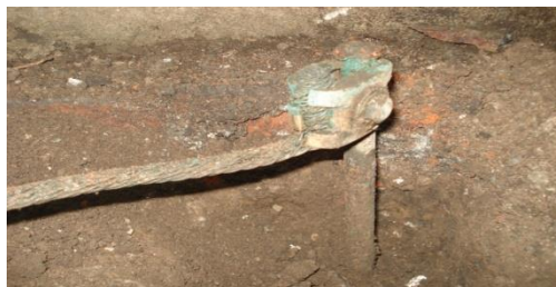
Fig.49 Conector mecánico en varilla. 1
