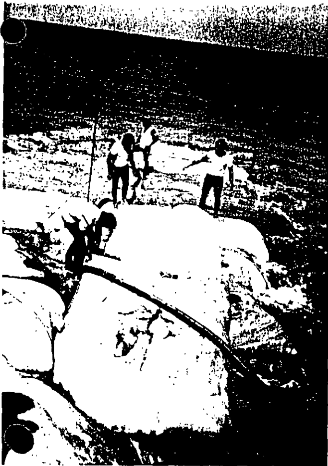
Las cimbras textiles impermeables, que pueden reforzarse e interconectarse, pesan unos cuantos kilogramos, y permiten el colado directamente en obra para fabricar enormes bloques de 6 toneladas de peso, Bolsacreto (R) BC-6, con el empleo de mangueras flexibles y un equipo de trabajadores anfibios.
