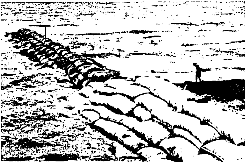
Para algunas obras, se pueden utilizar contenedores textiles permeables Bolsaroca (R), que se llenan en el lugar del proyecto hidráulicamente con arena de playa y que se protegen con una coraza de Bolsacreto, como ilustra la foto del rompeolas Sur del Puerto de Servicio del Distrito Industrial Marítimo Laguna del Ostión, Veracruz.
