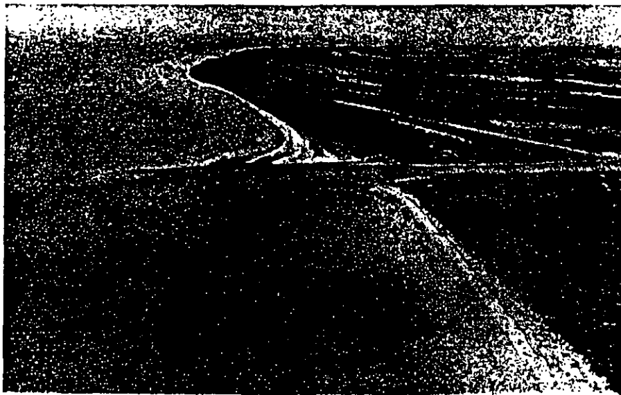
Escollera del Río Lagartos, Yuc., construida con Bolsaroca en dos meses
