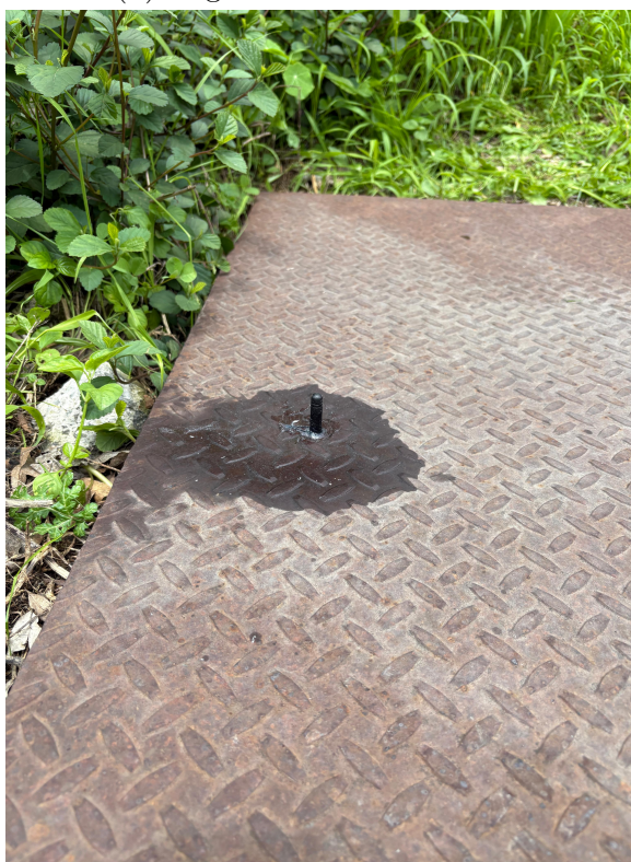
(d) Extracción de la antena
