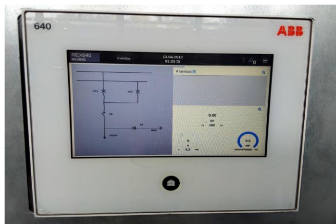
Imagen 198_Visualización del display del REX640.
