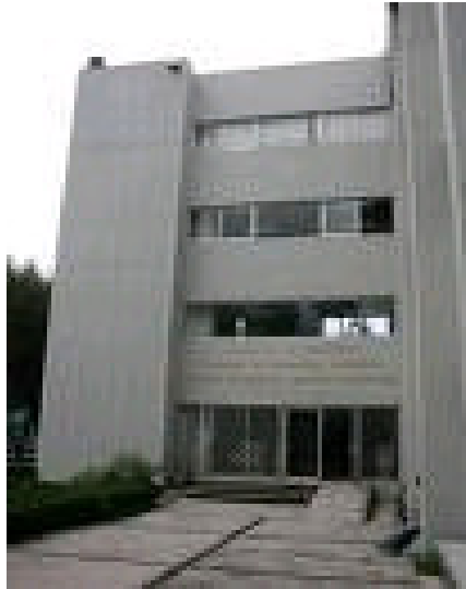
Figura 10 “Instalaciones Departamento de Ingeniería Eléctrica, UNAM (DIE)”
