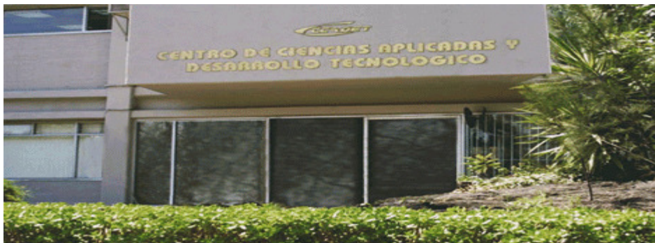
Figura11Instalaciones Centro de Ciencias Aplicadas y Desarrollo Tecnológico (CCADET)”
