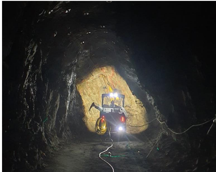
Figura 9. Vista trasera de jumbo instalado realizando actividades de barrenación.
