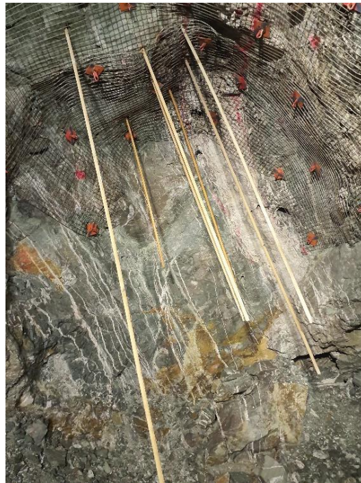
Figura 41. Uso de faineros para comprobar inclinación y paralelismo.
