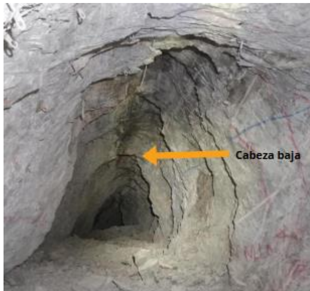
Figura 37. Cabeza baja quedada por mala voladura.
