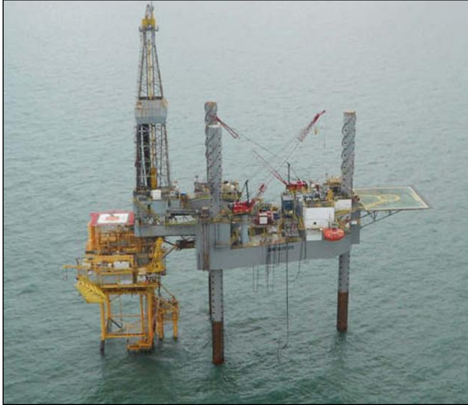
Fig. 2.4.2.1.1 Sistema de Perforación Jackup. Tomado de: IADC. Types of Drilling Rigs (RT). 2015
