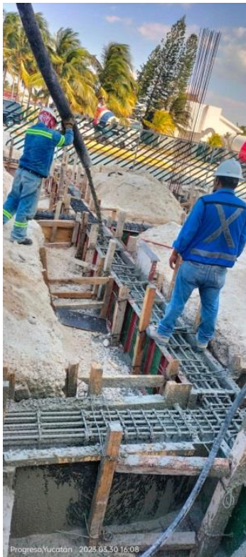
Colado de contr trabes
