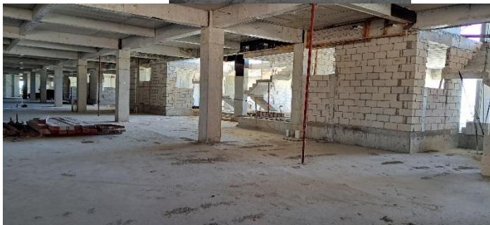
Sistema de losa bidireccional con vigas en Marina Resort YucaPETÈN.
