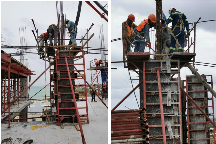
Actividad de colado. Se observa el personal y la herramienta necesaria para la correcta ejecución de la actividad.
