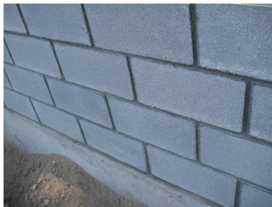
Acabado aparente en muro de block. Se observa detalle en el junteo entre block.
