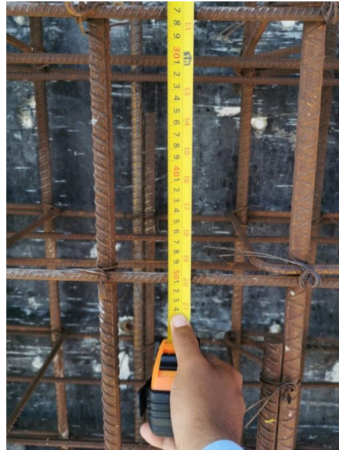
Longitud de gancho y separación de estribos acorde a detalle en planos estructurales.
