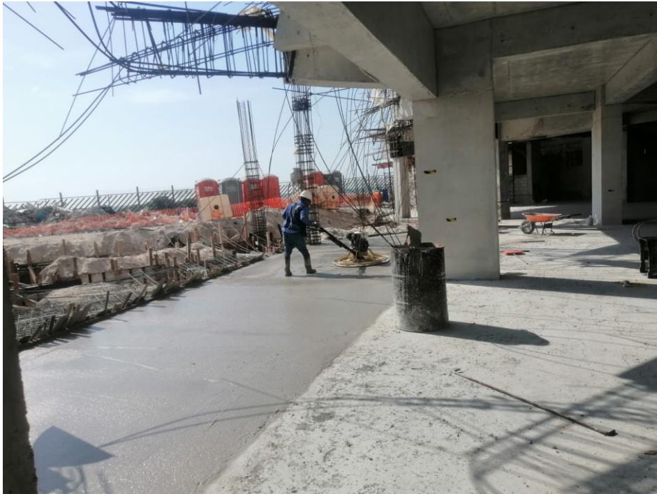
Aplicación de acabado pulido en firme con máquina.
