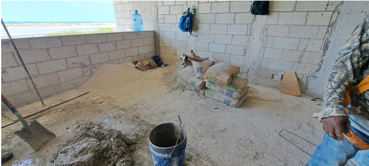
Preparación de material sobre artesa u hoja de triplay para evitar la contaminación.
