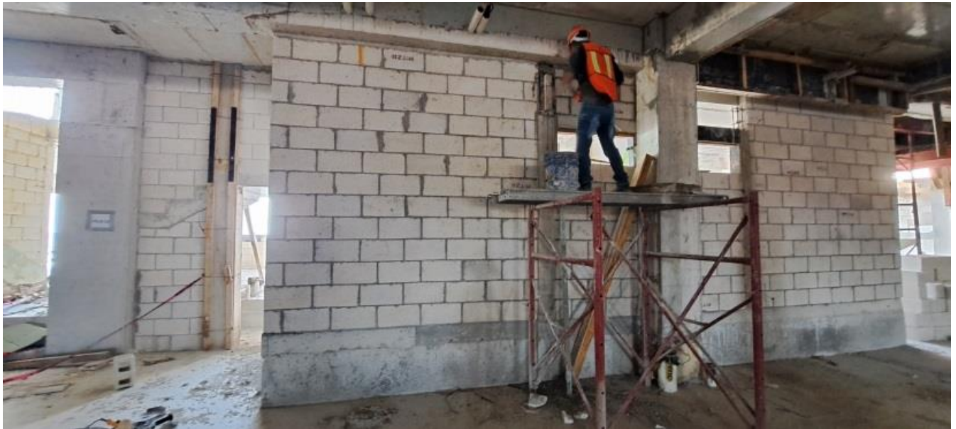
Acabado mezcla cortada en muro de block.
