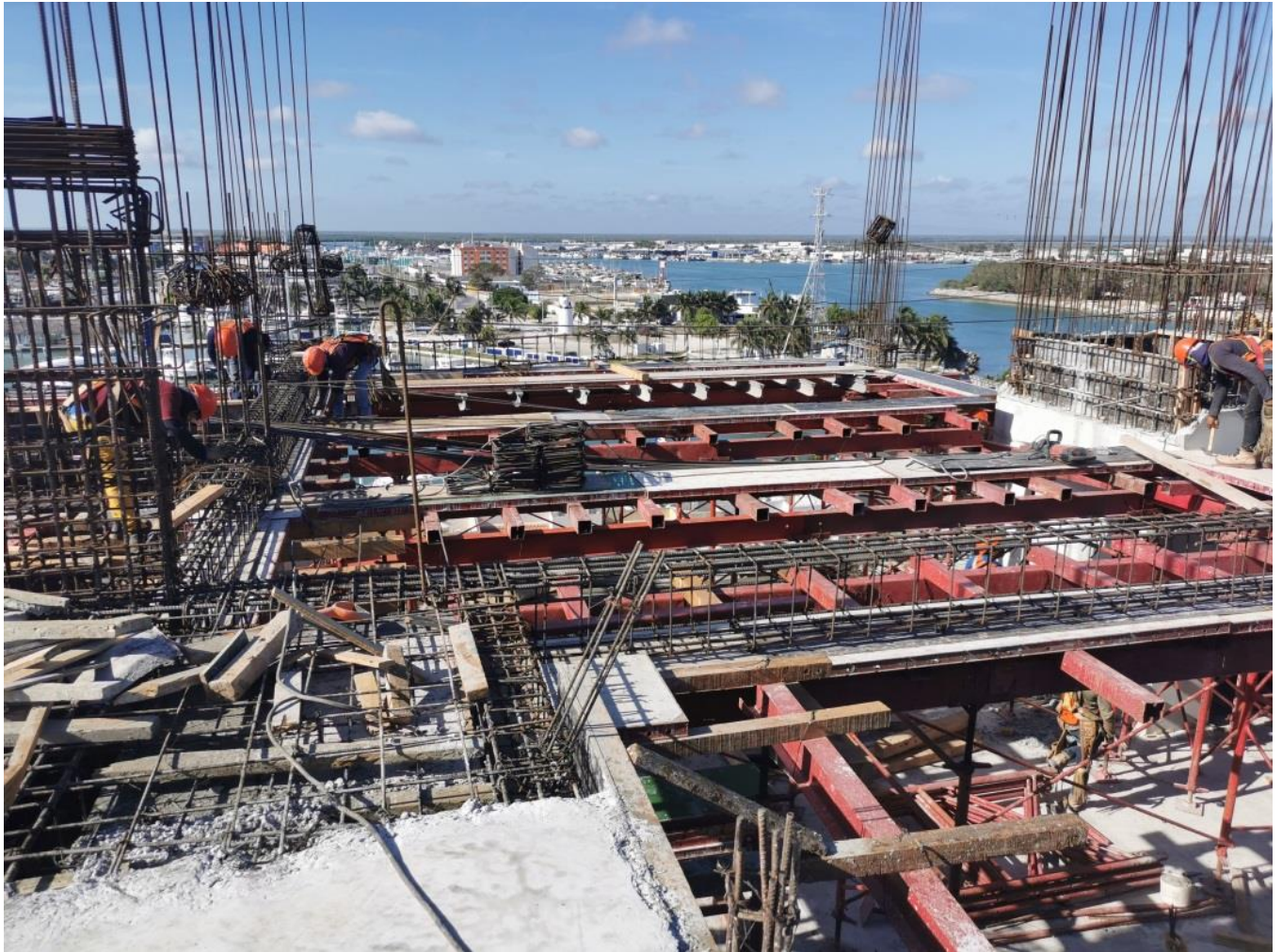
Andamios utilizados para habilitado de fondo de losa
