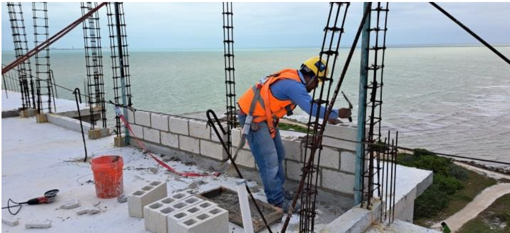
Personal con arnés de seguridad asegurado a línea de vida
