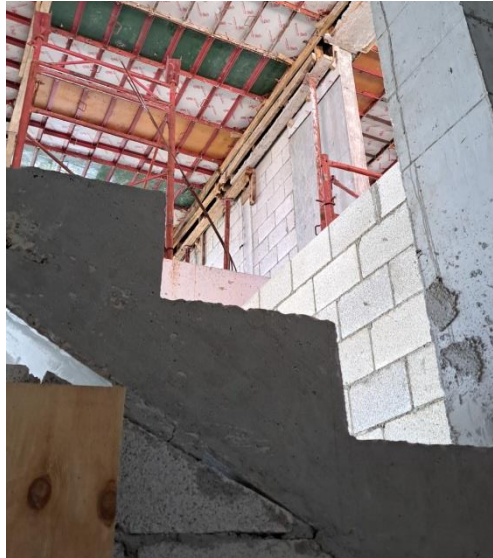
Panel de hoja triplay fenólico en losa
