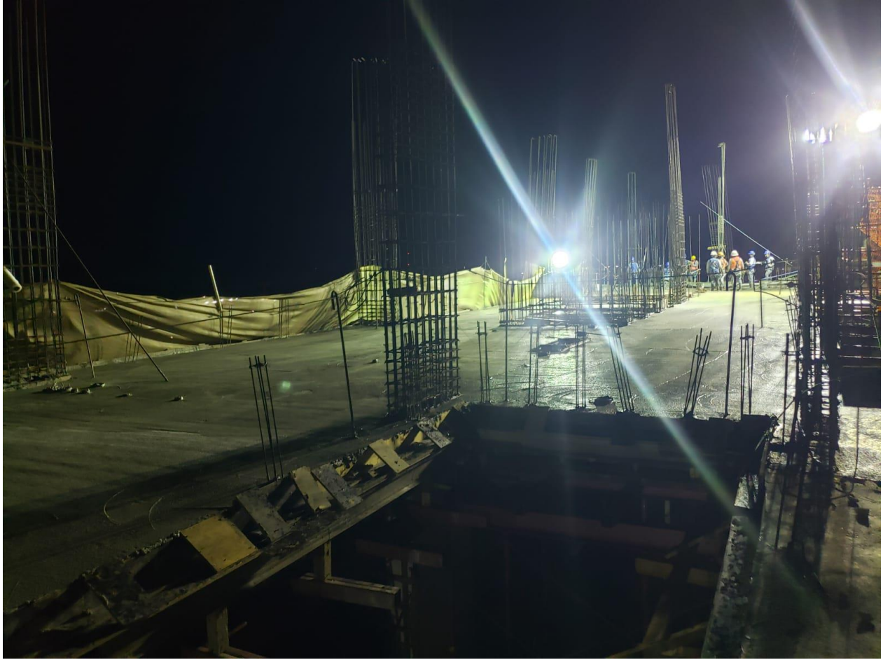
Finalización de colado de losa.
