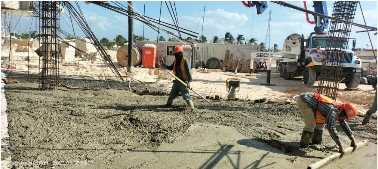
Colado de firme de concreto.
