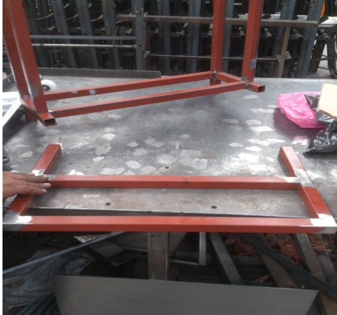
Ilustración 32. Parte trasera de la estructura.
