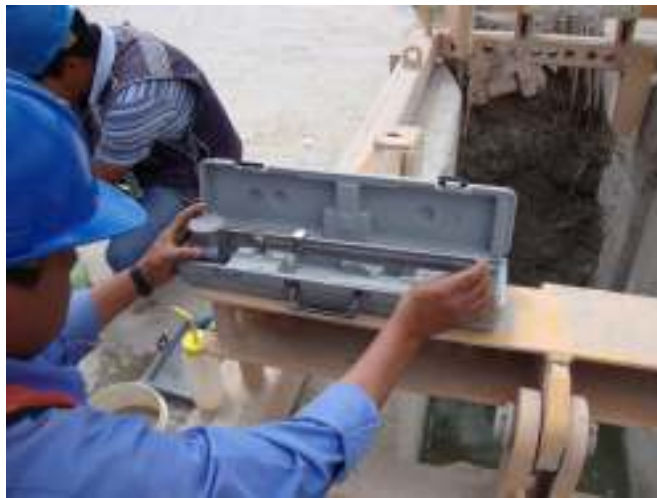
Prueba de densidad del lodo bentonítico
