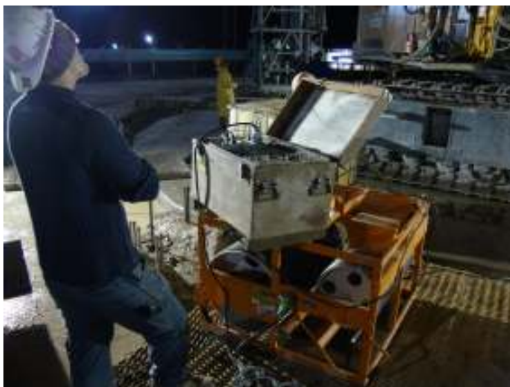
Verificación de la verticalidad de la excavación con el KODEN
