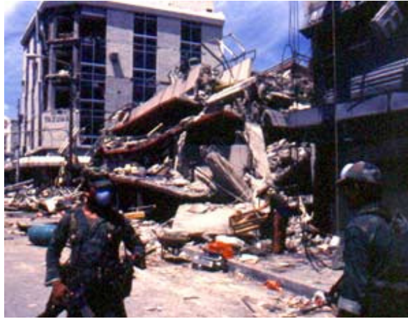
Figura 6 Edificio Rubén Darío durante el sismo de El Salvador en 1986) EERI et al. , (1987)
