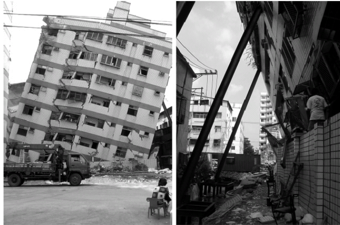
Figura 14 Fotografías de Taichung Miracle building Naeim et al. , (2000).
