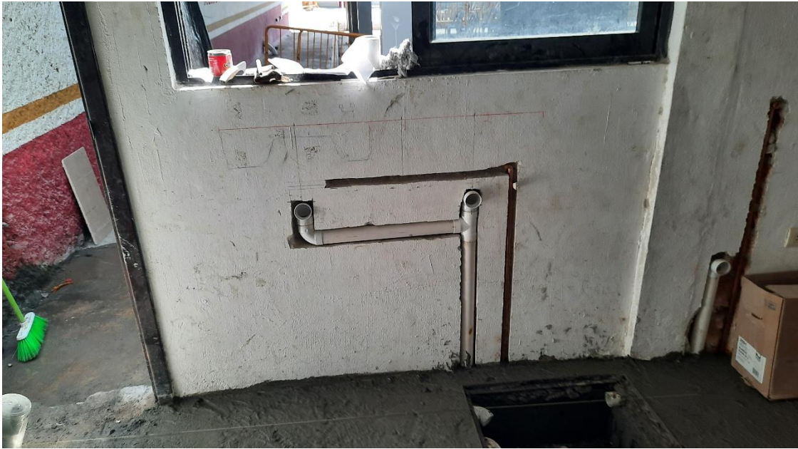
Foto 11 Colocación de Instalación Hidrosanitaria en la oficina de Migración de Beta Tapachula Chiapas INM Colección personal del autor
