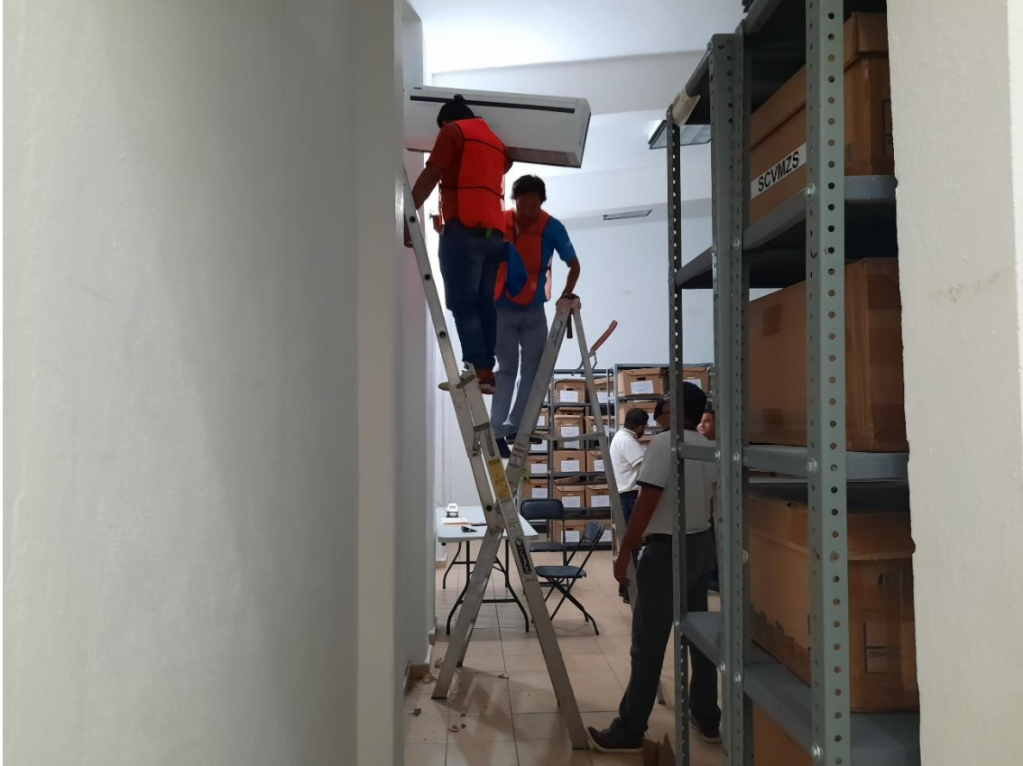
Foto 10 Colocación de equipo de aire acondicionado en la oficina de Migración de Beta Tapachula Chiapas INM Colección personal del autor
