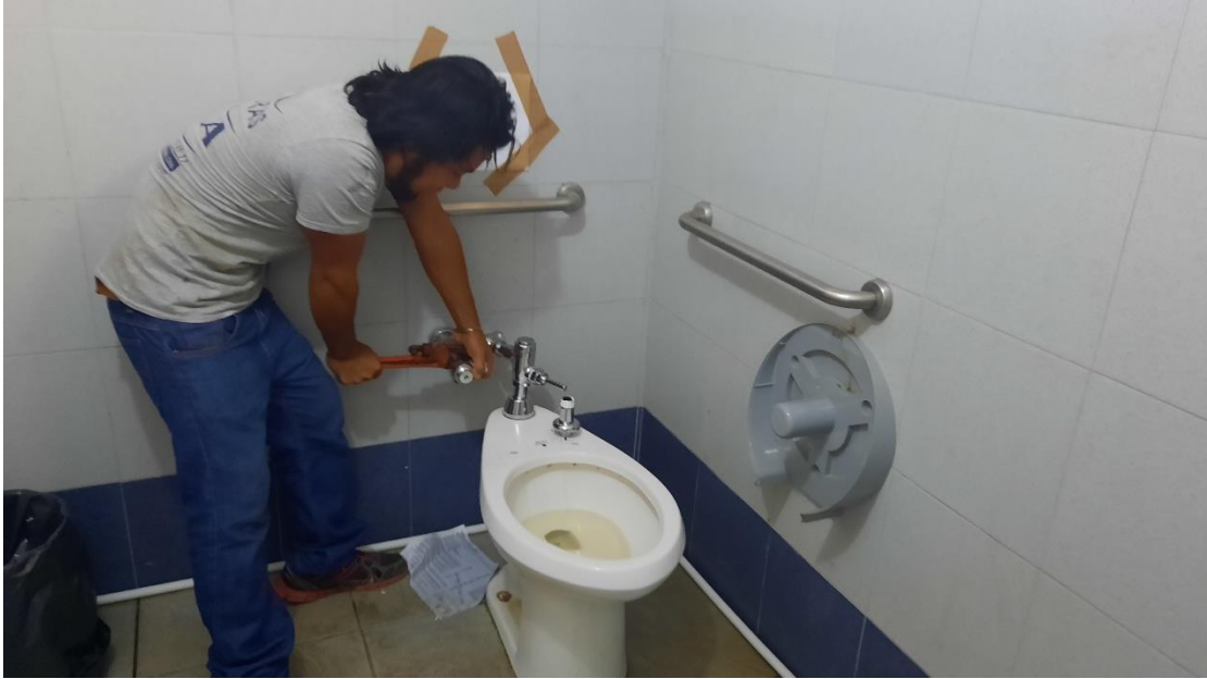
Foto 12 Colocación de mueble sanitario en la oficina de Migración de Suchiate 1 Chiapas INM Colección personal del autor
