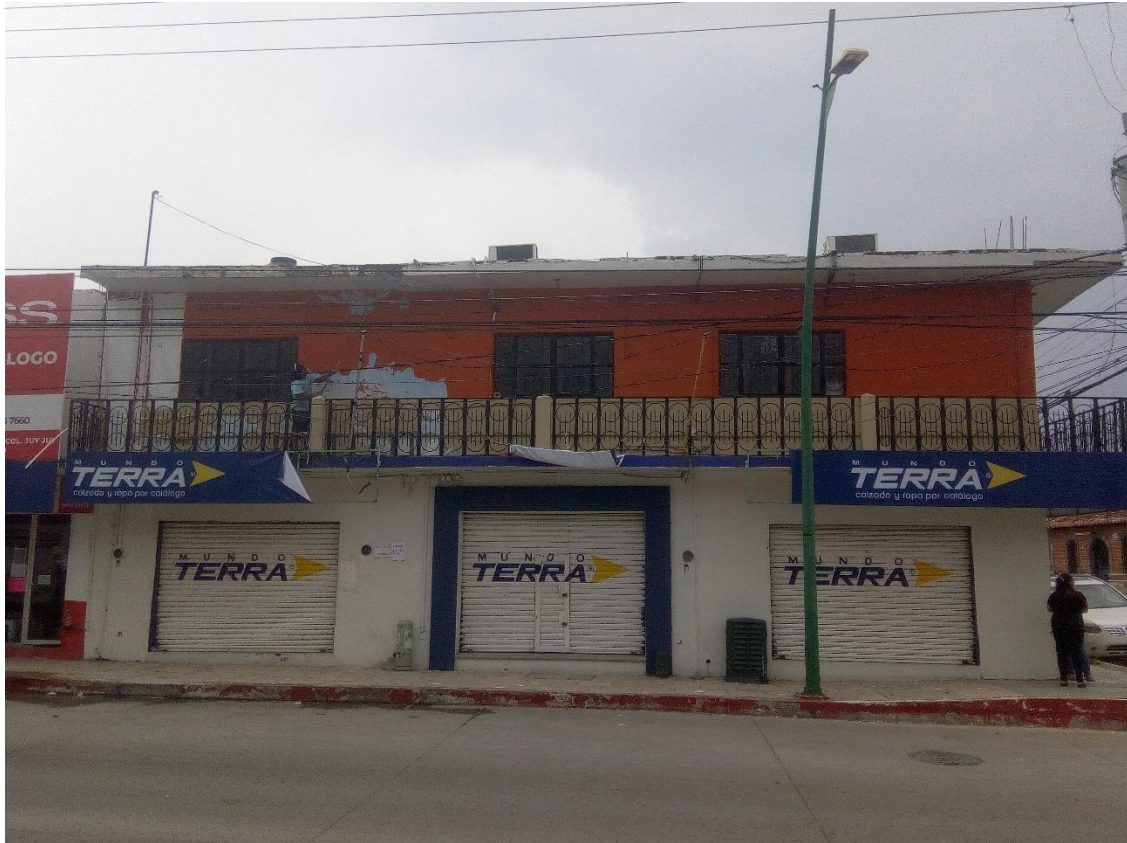
Foto 1 Fachada de Oficina de Migración de la oficina Beta Tuxtla Chiapas INM, antes de realizar trabajos de pintura Colección personal del autor
