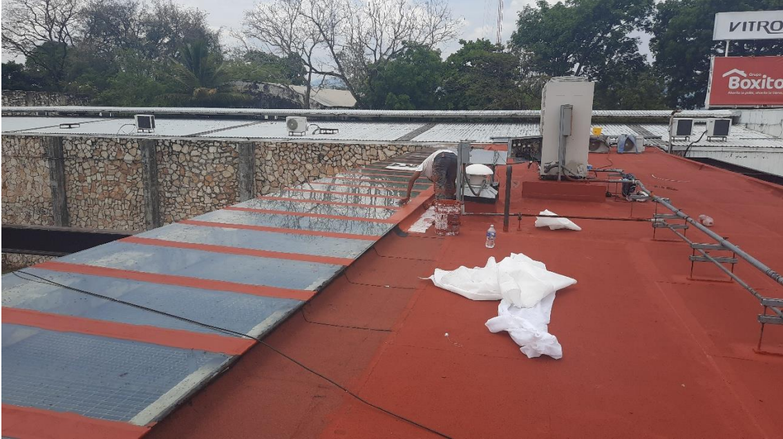
Foto 16 Azotea en oficina de Migración en Palenque Chiapas INM, trabajos finalizados de impermeabilización Colección personal del autor
