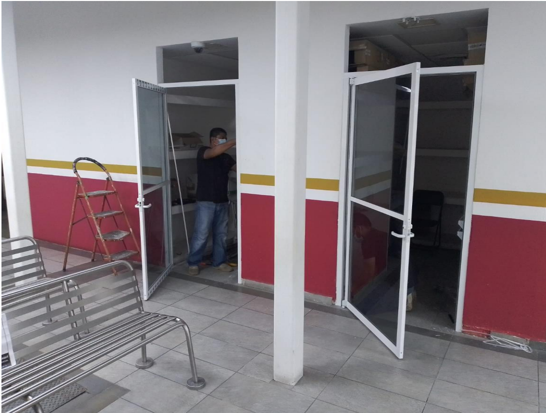
Foto 7 Colocación de puerta de aluminio en la oficina de Migración de Suchiate 1 Chiapas INM Colección personal del autor
