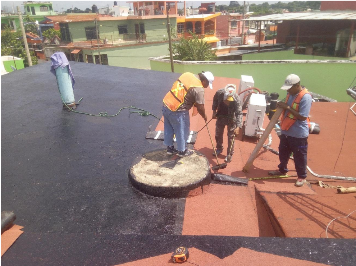
Foto 3 Oficina de Migración de la oficina Beta Tapachula Chiapas INM Colocación de impermeabilizante Colección personal del autor
