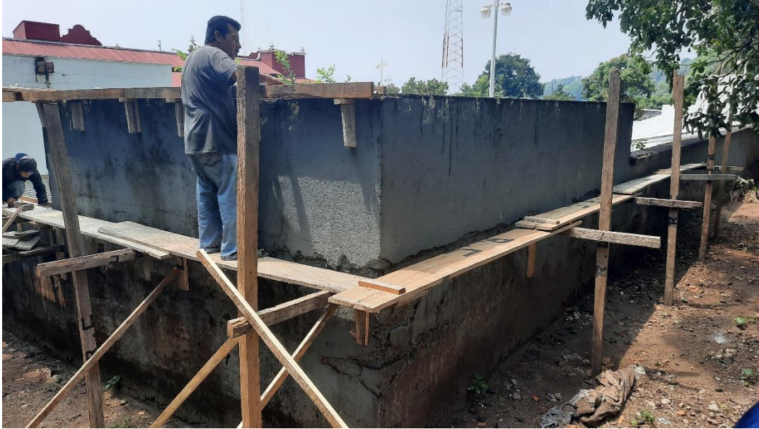
Foto 5 Aplanado en muro exterior en la oficina de Migración de Casa Roja Chiapas INM Colección personal del autor
