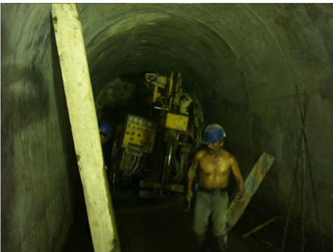
Foto. 4 Perforación en plinto (track drill)
