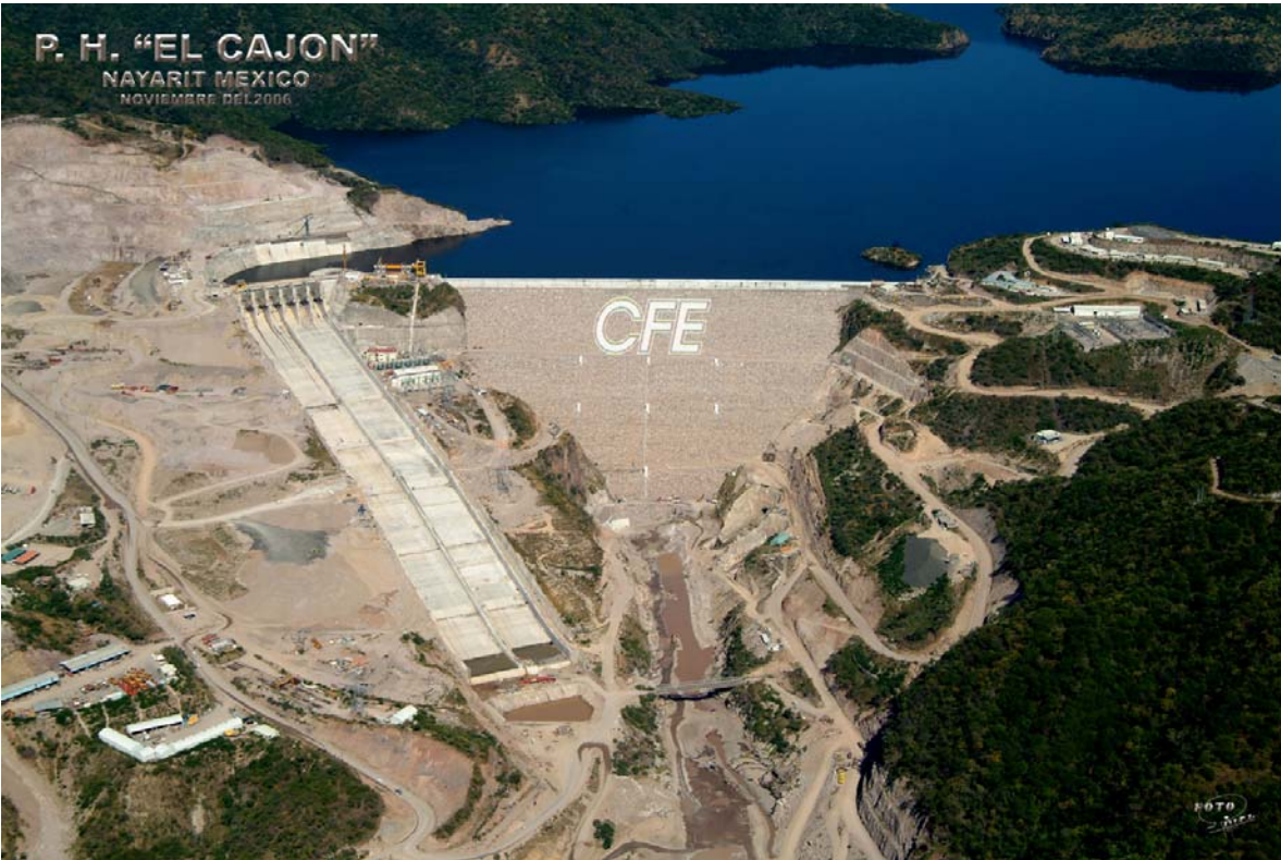
Foto 11. Vista General del Proyecto (Noviembre 2006).
