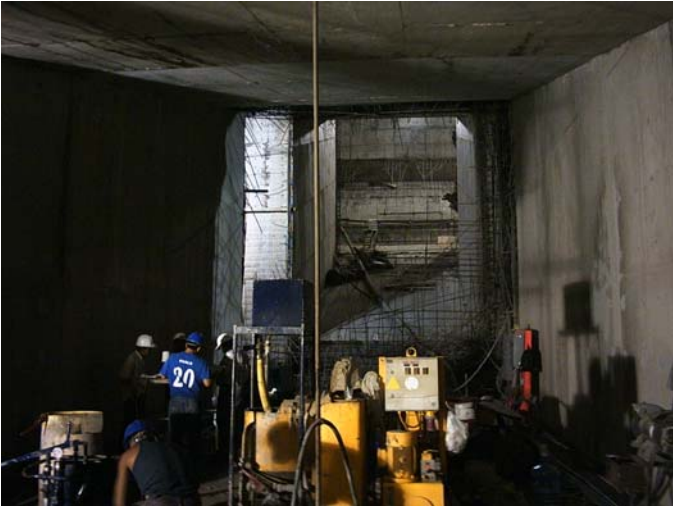
Foto. 6 Inyección en Codo de Aspiración
