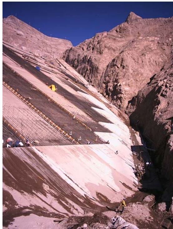
Foto. 2 Vista del Plinto (margen derecha)
