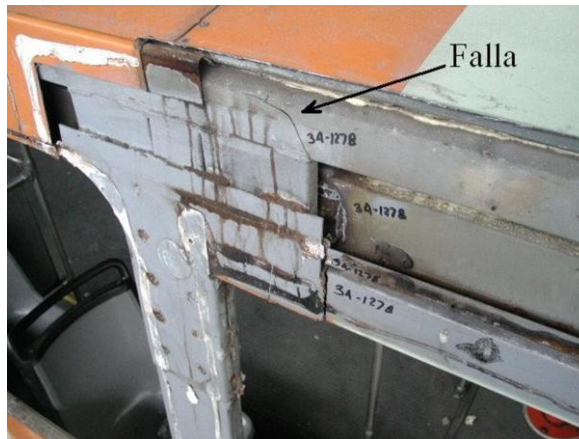
Figura 1.2. Grieta en la esquina superior derecha del marco de la puerta delantera.
