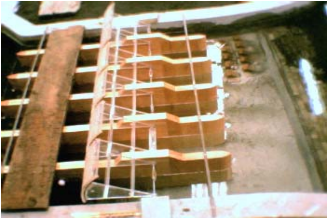
Fotografía 4.2.2 Detalle de forma y distribución de las pilas.
