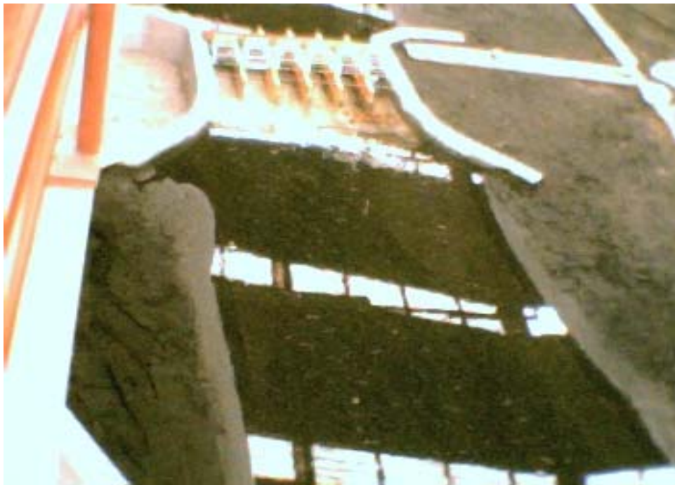
Fotografía 4.2.8 Detalle de paso por la estructura.
