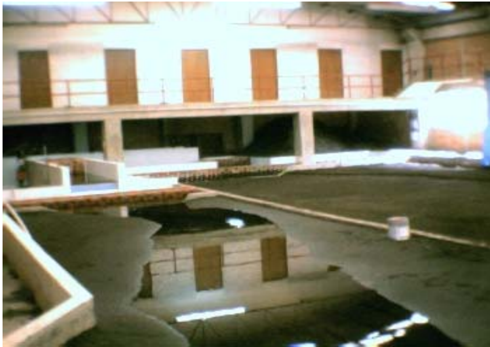
Fotografía 4.2.3 Vista de la zona de aguas arriba
