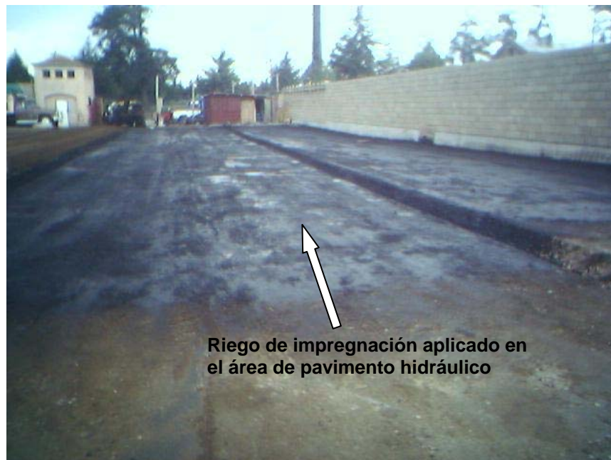
Foto III.6.1.4 Riego de impregnación en zona de pavimento hidráulico.
