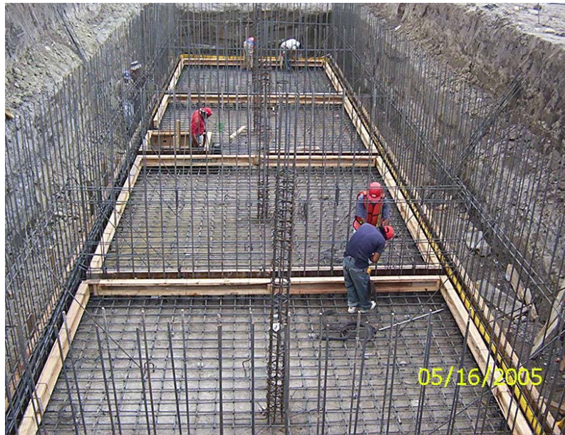
Foto III.4.4.4 Habilitado de acero de refuerzo en la losa de fondo.
