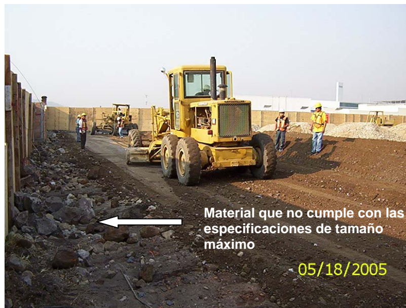
Foto III.2.2.9 Se aprecia la selección y tendido de material.
