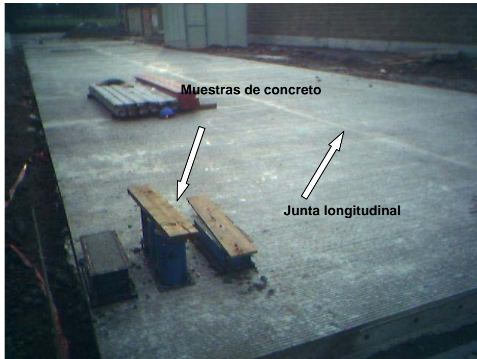
Foto III.6.2.7 Losa de concreto terminada y muestras del concreto hidráulico.
