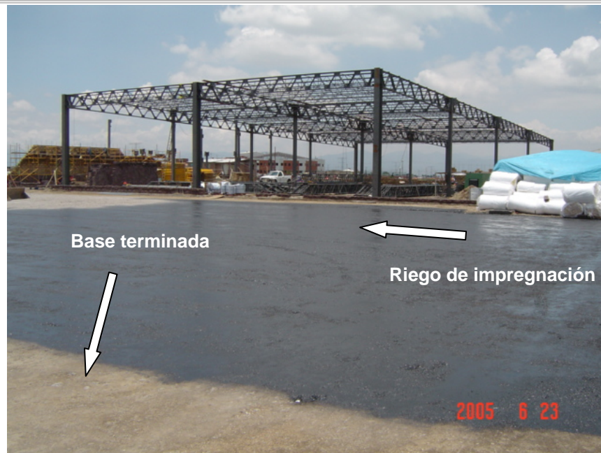
Foto III.6.1.3 Riego de impregnación.
