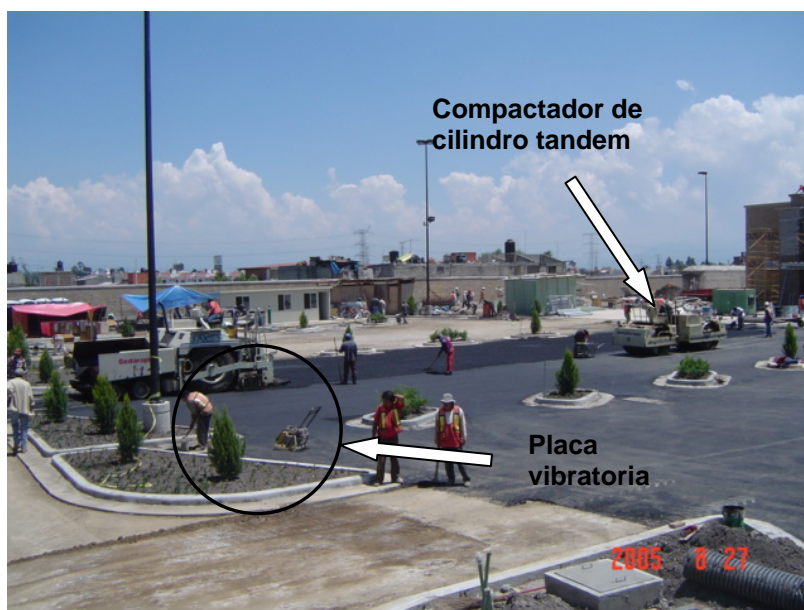
Foto III.6.1.10 Se observa el trabajo simultáneo.
