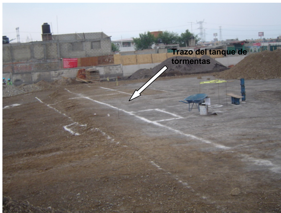
Foto. III.1.2.2 Señalamientos con cal.
