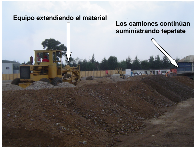
Foto III.2.2.3 Construcción de terraplén.
