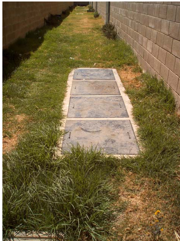
Foto III.4.2.3 Trampa de grasa terminada.
