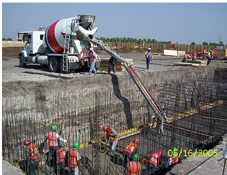
Foto III.4.4.5 Colado de la losa de fondo.
