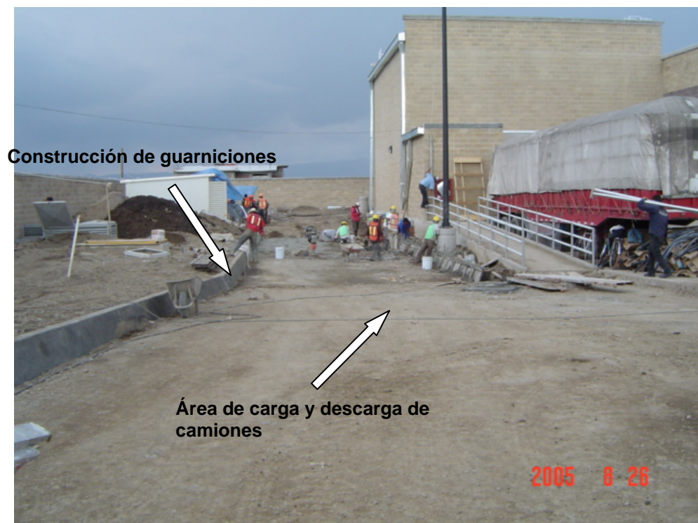
Foto III.6.2.1 Trabajos previos al colado.
