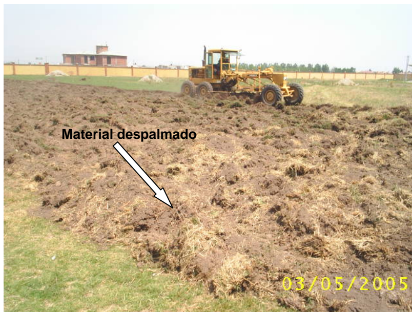
Foto III.2.1.1 Trabajos de despalme.
