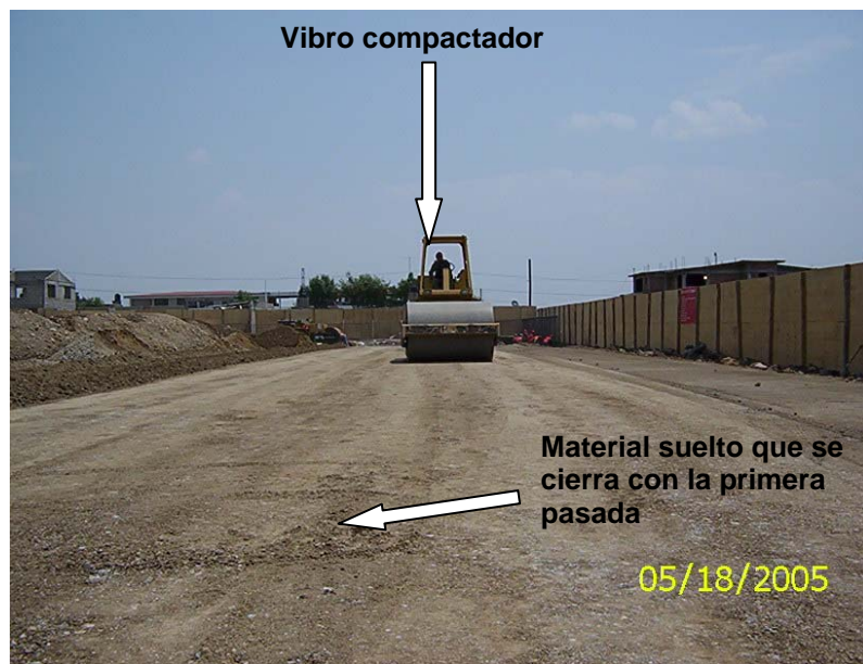
Foto III.2.2.11 Compactación y acabado final.
