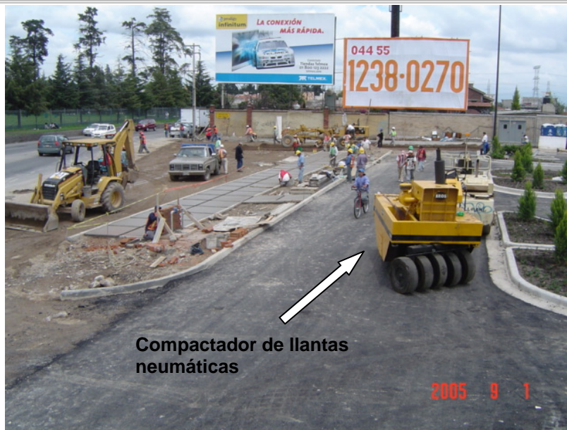
Foto III.6.1.9 Se aprecia el equipo compactador de llantas neumáticas.
