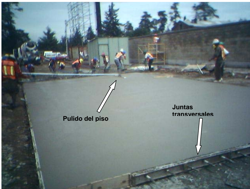
Foto III.6.2.6 se aprecia el trabajo de pulido del piso.
