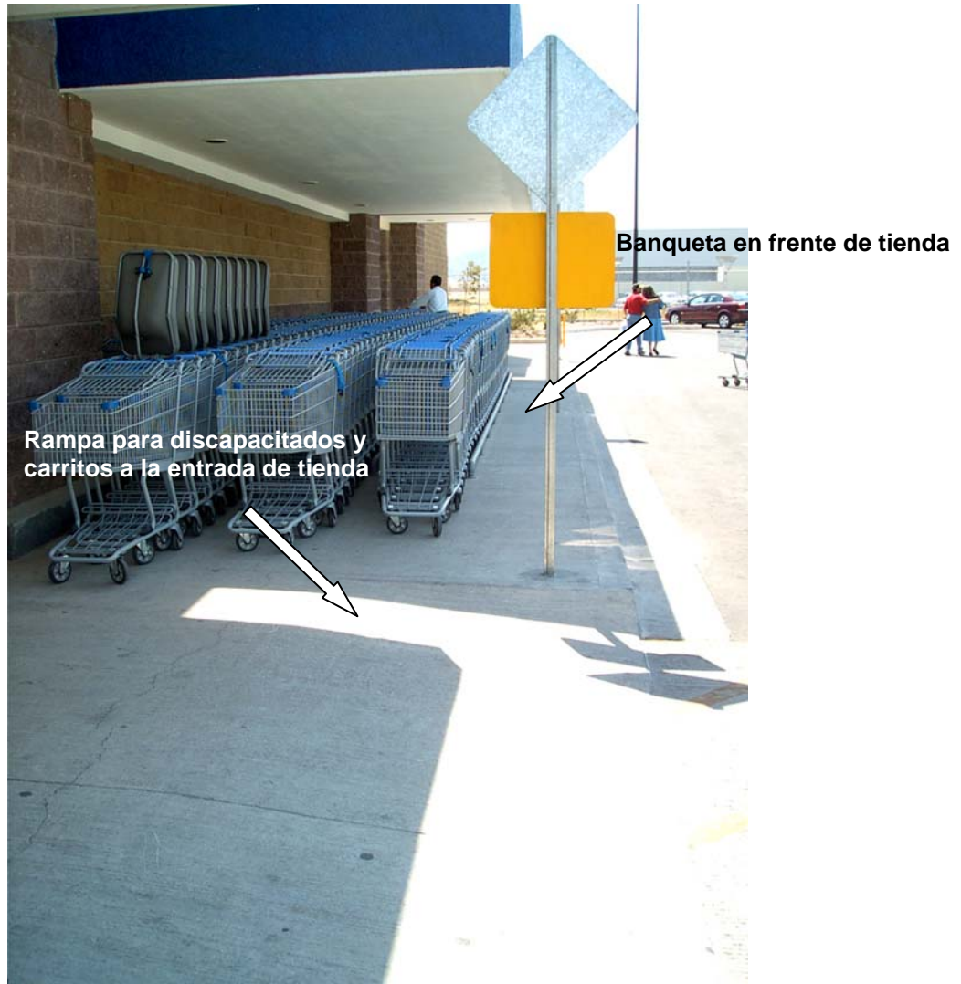
Foto III.3.1.2 Rampa y banqueta en tienda.
