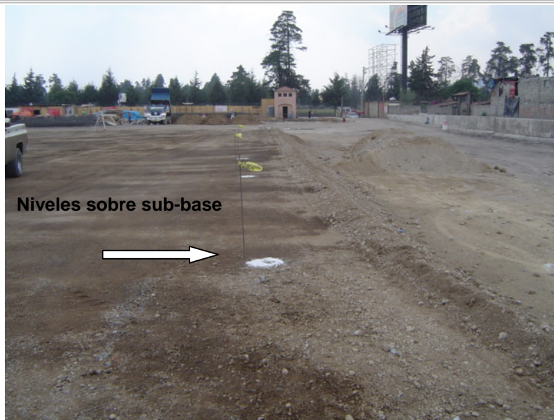
Foto III.2.2.12 Niveles de sub - base terminada.
