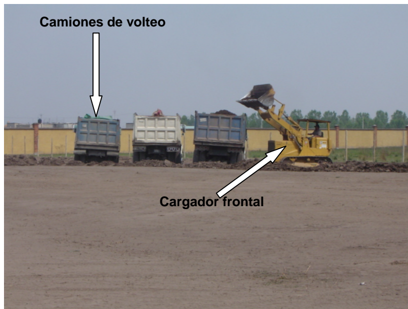
Foto III.2.1.2 Trabajos de carga de material de corte y despalme.
