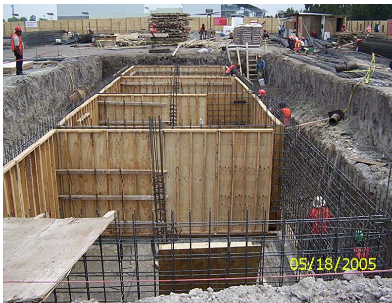
Foto III.4.4.7 Proceso de cimbrado de los muros del tanque.
