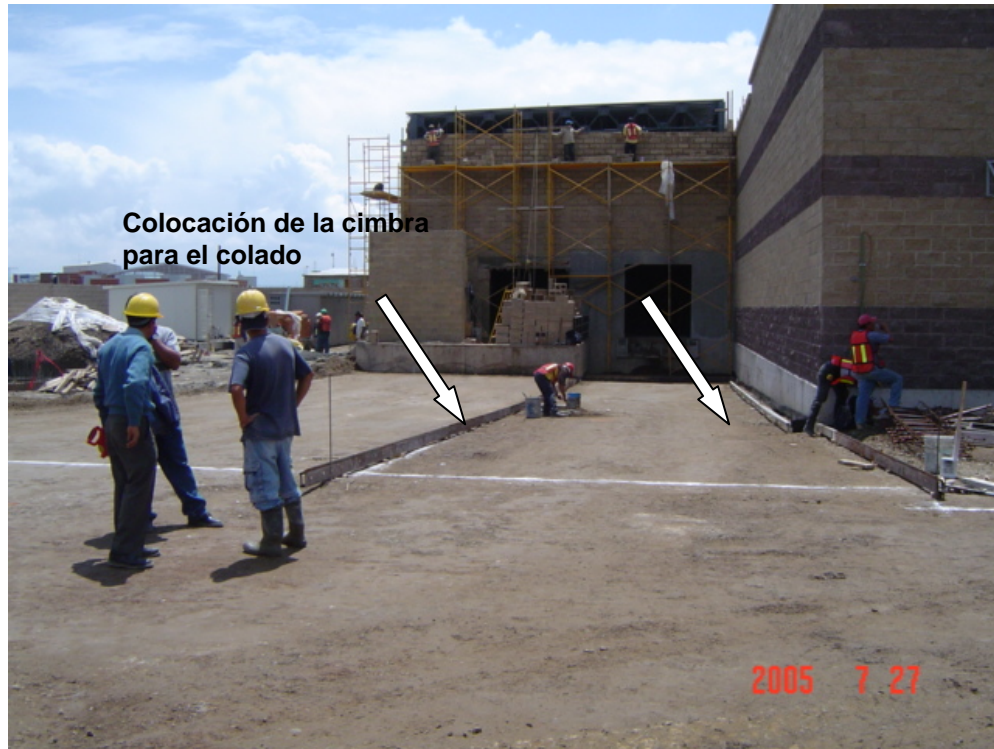
Foto III.6.2.2 Colocación de las cimbras para el colado.
