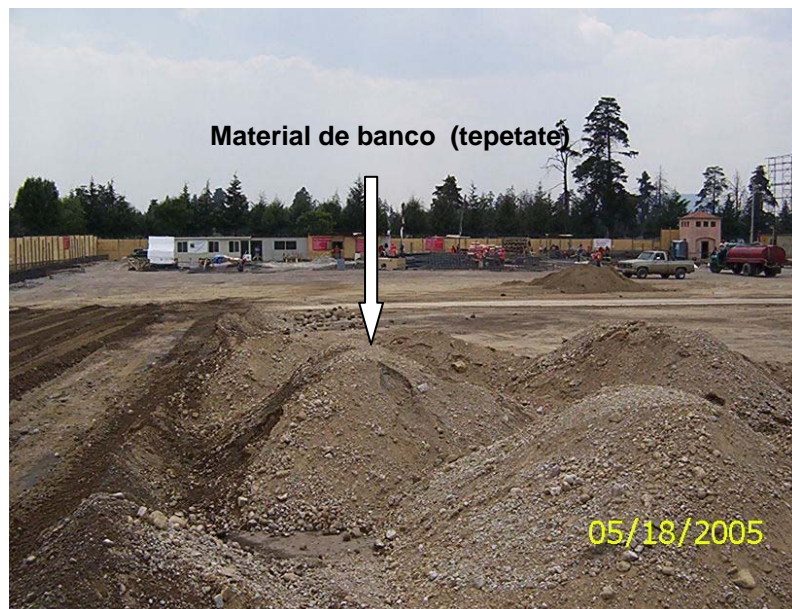
Foto III.2.2.4 Material para el relleno.
