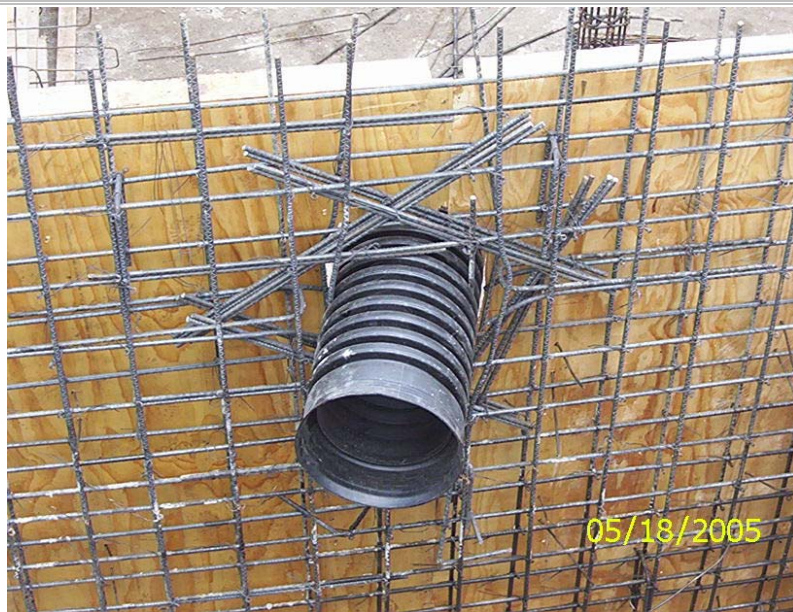
Foto III.4.4.8 Preparación de las tuberías de entrada al tanque.
