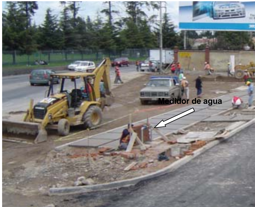
Foto. III.4.1.2 Fabricación del cuadro de acometida de agua.
