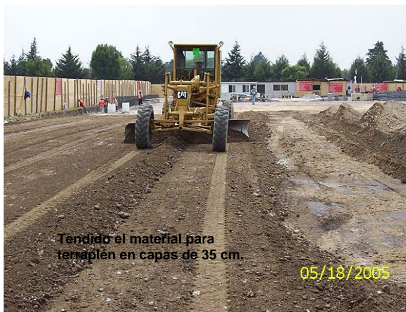
Foto III.2.2.7 Tendido de material.
