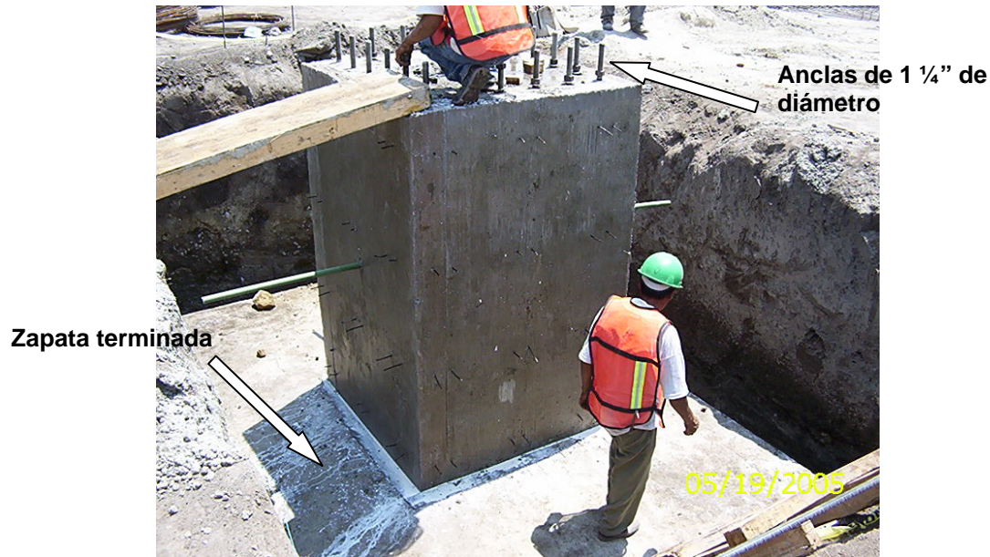
Foto III.3.7 Zapata terminada.
