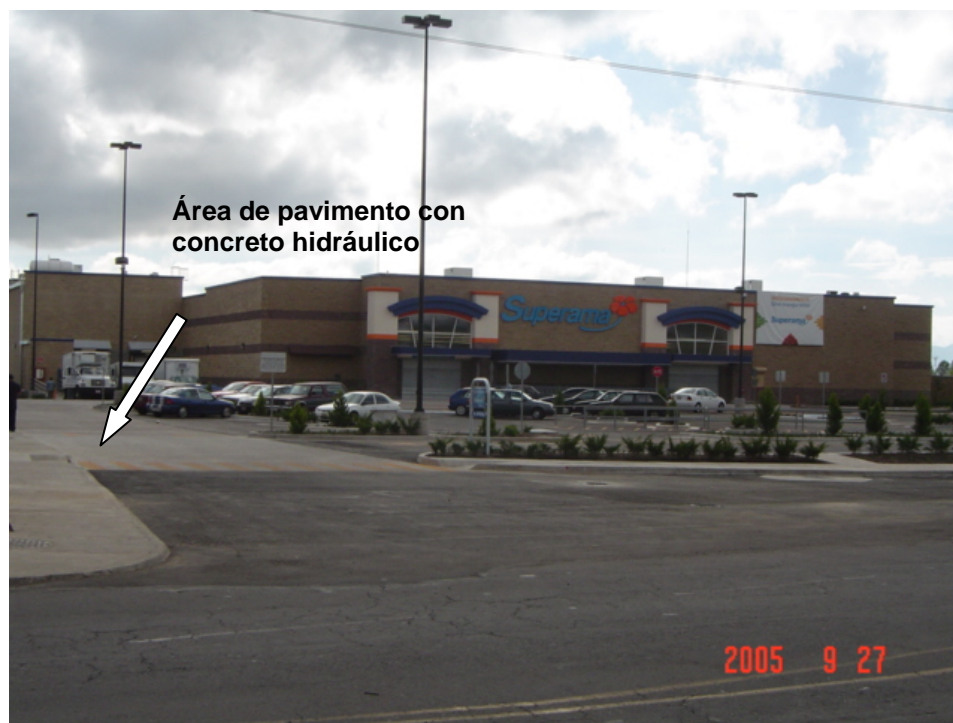
Foto III.6.2.8 Pavimento de concreto hidráulico ya terminado.
