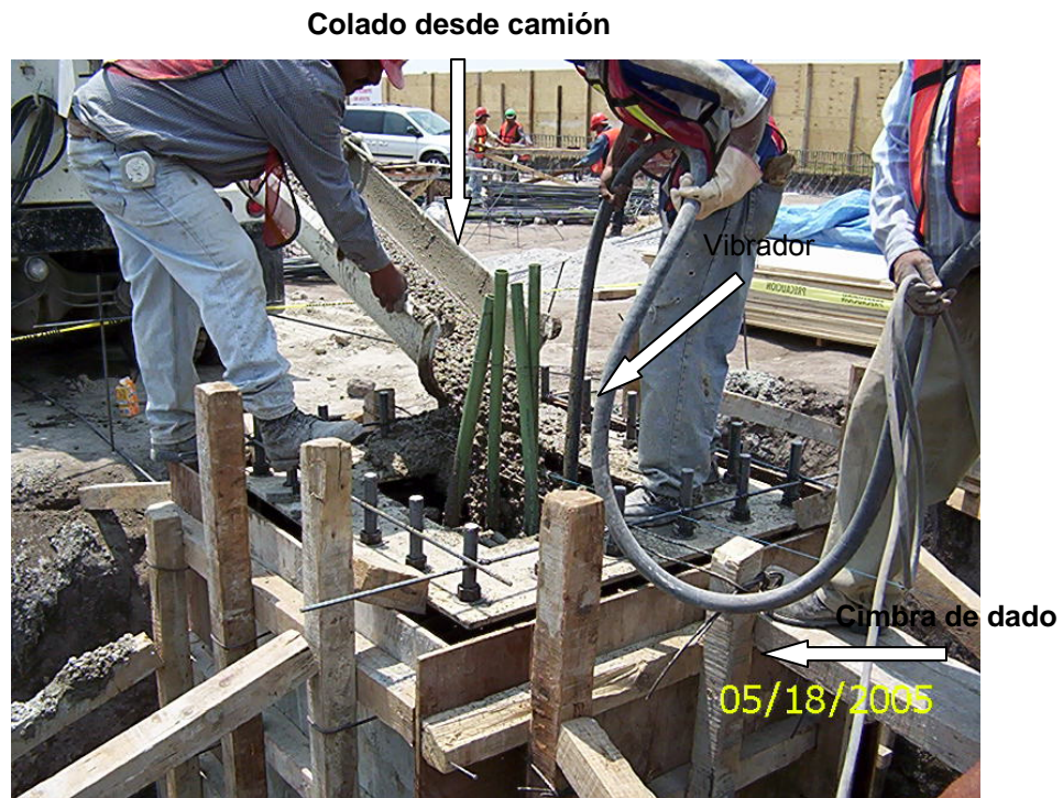
Foto III.3.3.2 Colado y vibrado de zapata.
