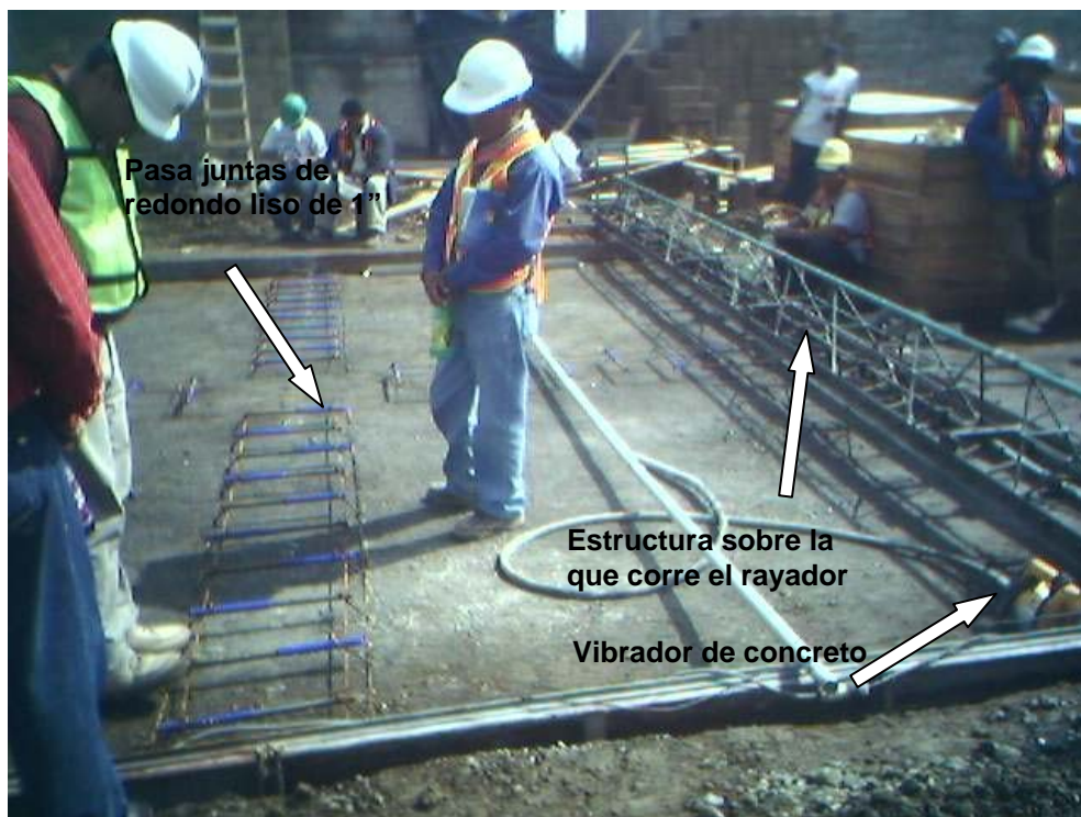
Foto III.6.2.3 Supervisión final antes de iniciar el colado.
