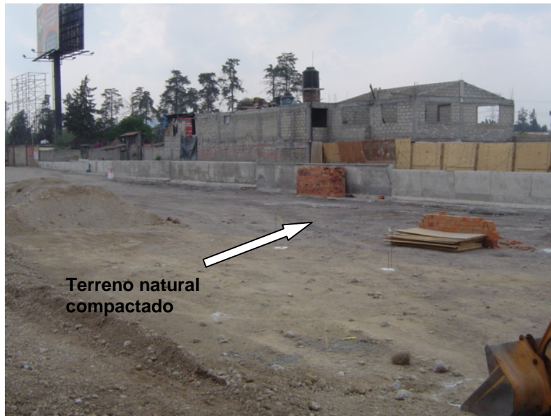
Foto III.2.1.5 Terreno natural recién compactado.
