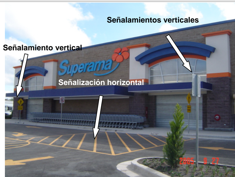
Foto III.6.3.1 Se aprecian las señalizaciones horizontales y verticales.
