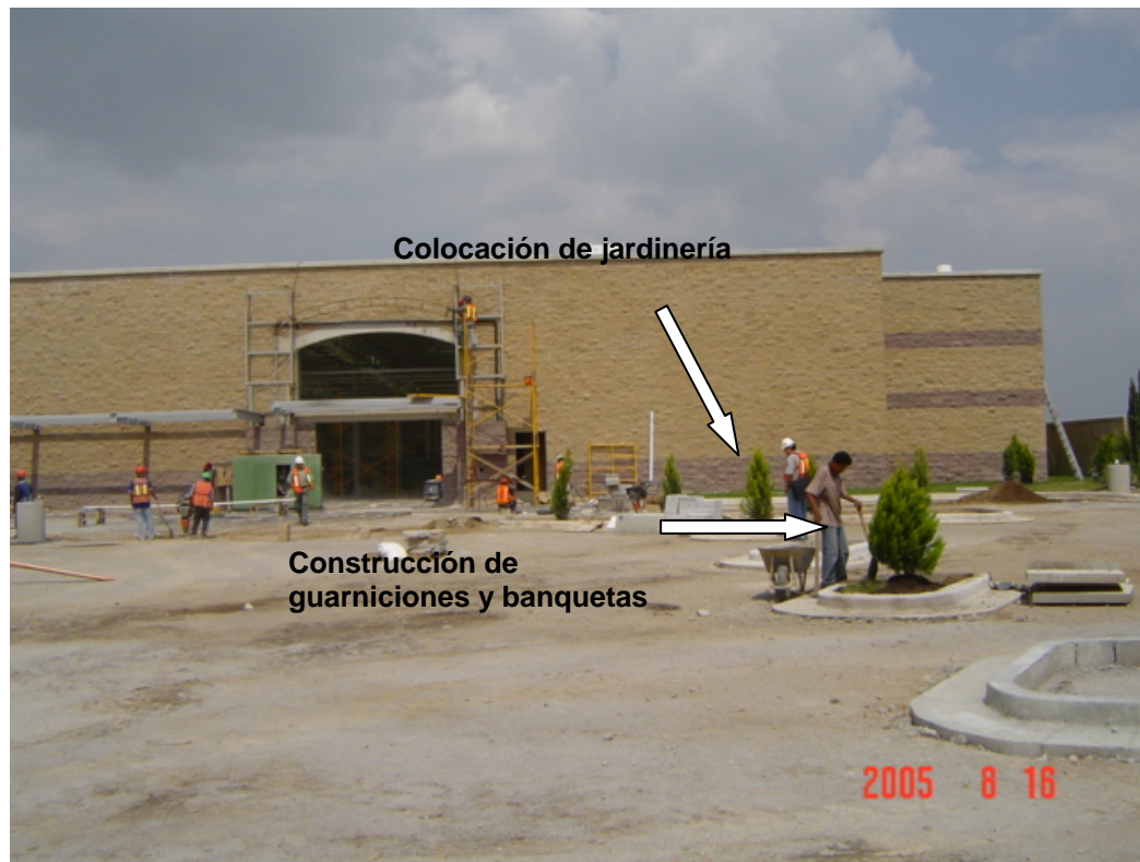
Foto III.6.1.1 Trabajos previos a la pavimentación.
