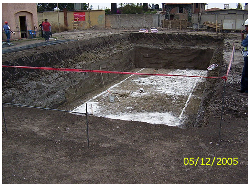
Foto. III.4.4.1 Excavación del cajón y estabilizado con cal.
