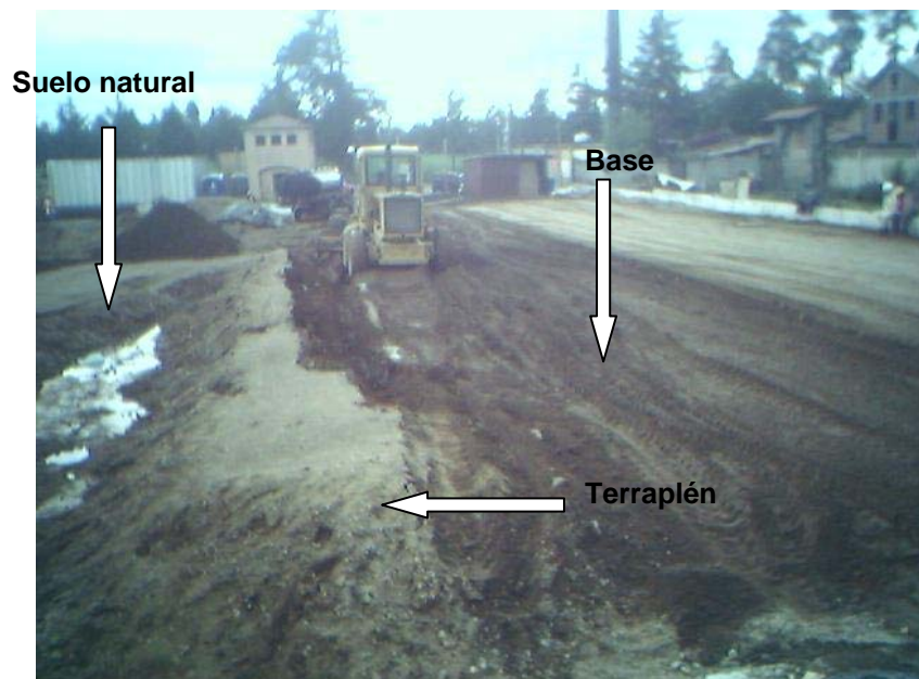
Foto III.2.2.13 Tendido de material.
