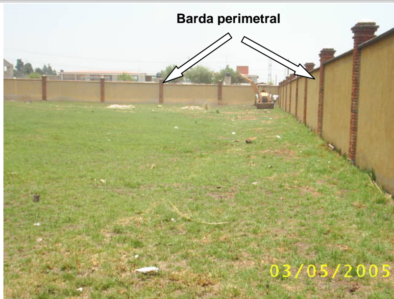
Foto. III.1.3.4 Inicio de los trabajos de demolición.
