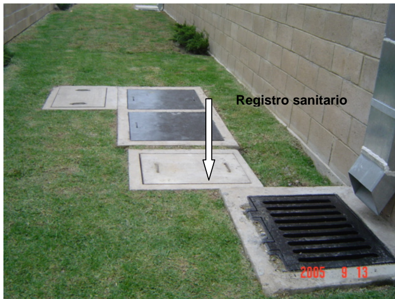
Foto III.4.2.2 Registro sanitario terminado.
