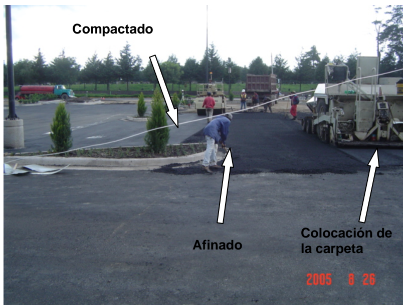
Foto III.6.1.12 Se observan las etapas de la colocación.
