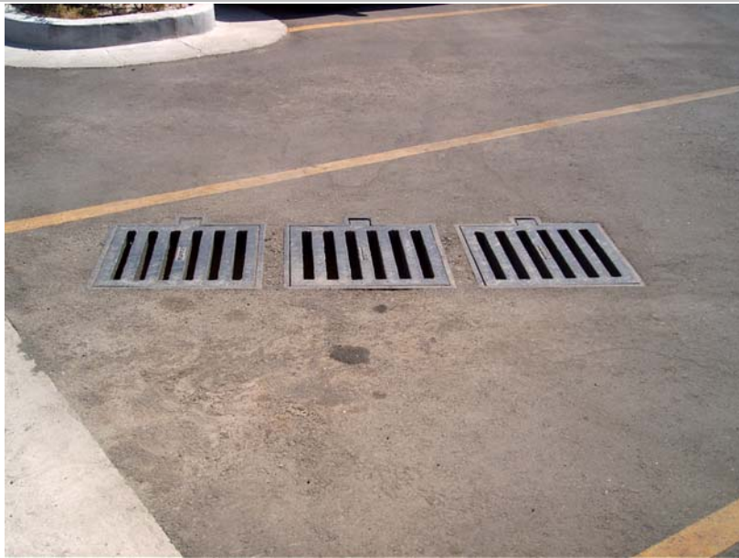
Foto III.4.3.2 Registro pluvial triple con rejilla de piso terminada
