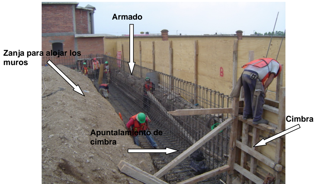
Foto III.3.2.2 Armado y cimbra.
