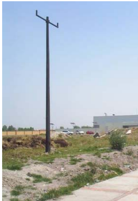
Foto. III.1.3.1 Poste cónico que se desmontó.
