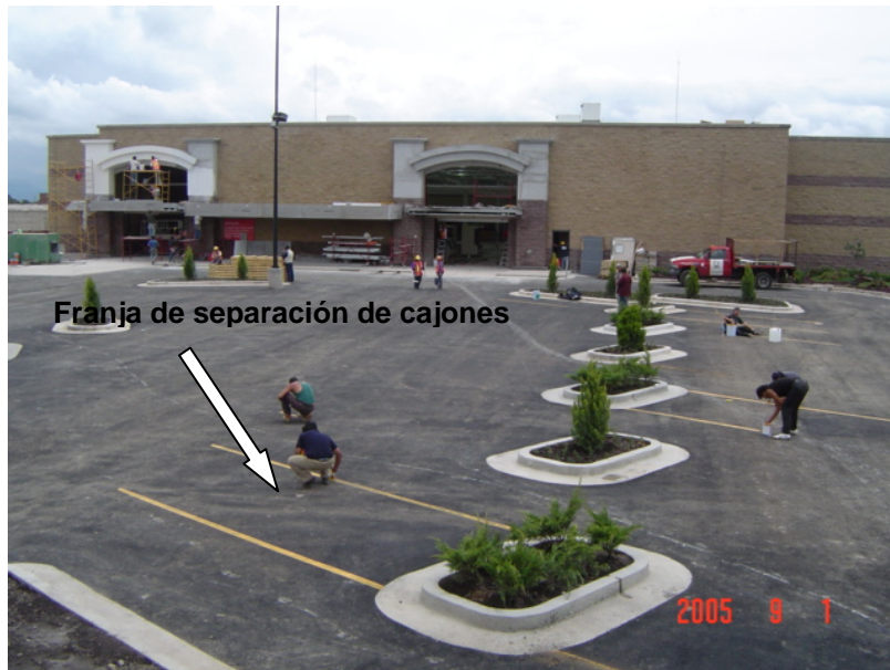
Foto III.6.3.2 Pintado manual de señalamiento horizontal.
