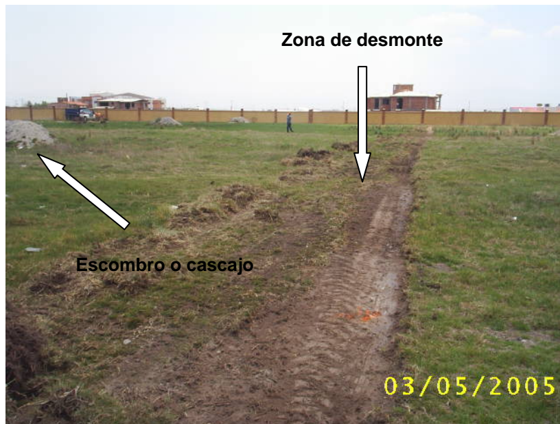
Foto III.2.1.4 Retiro de vegetación y cascajo.
