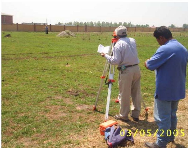
Foto. III.1.2.1 Trazo de los ejes de proyecto.
