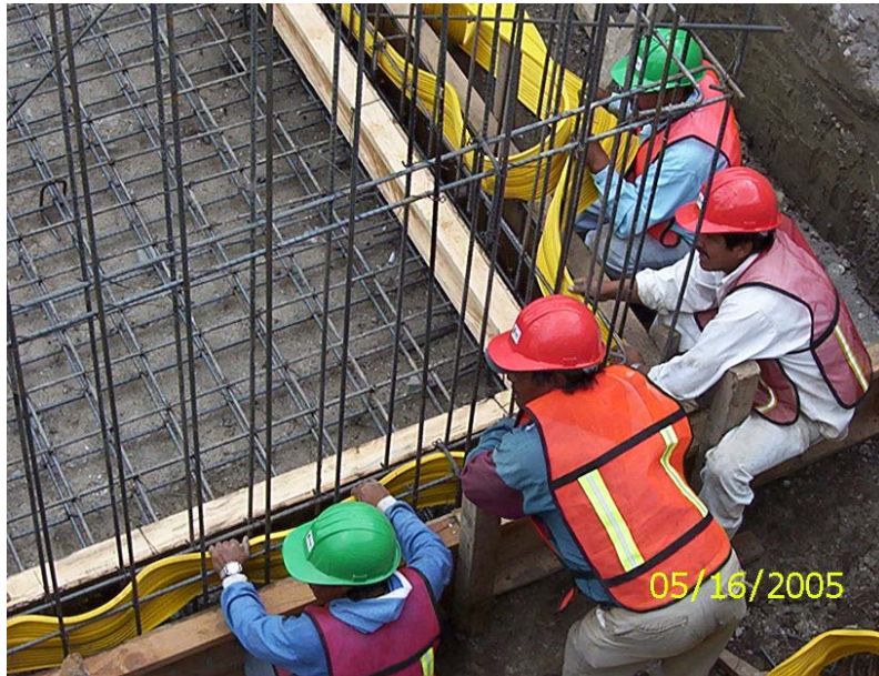
Foto III.4.4.6 Colocación de la banda de PVC.
