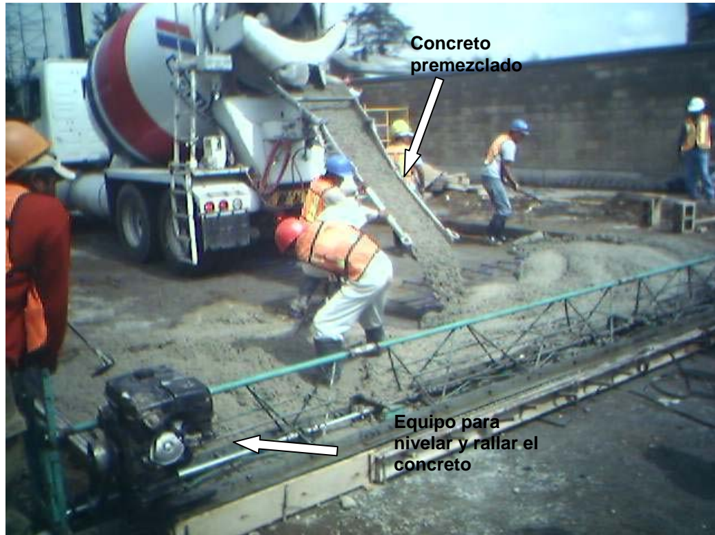
Foto III.6.2.5 Se aprecia el momento del vaciado de concreto.
