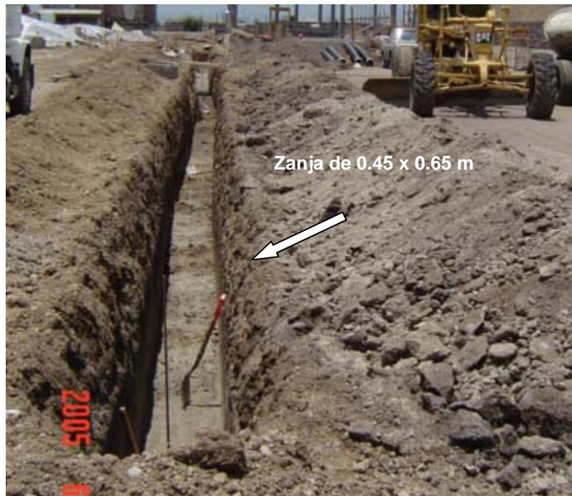
Foto. III.4.1.1 Zanja de acometida de agua potable.
