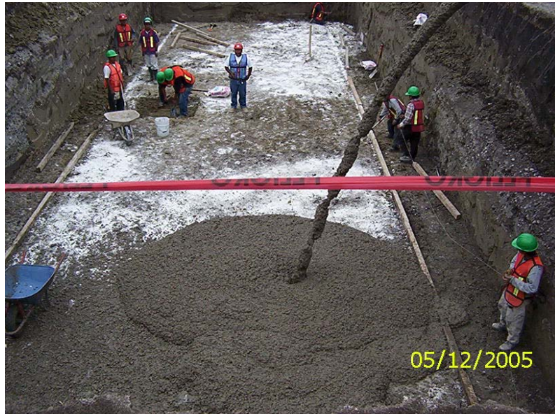
Foto III.4.4.2 Colado de plantilla de concreto.
