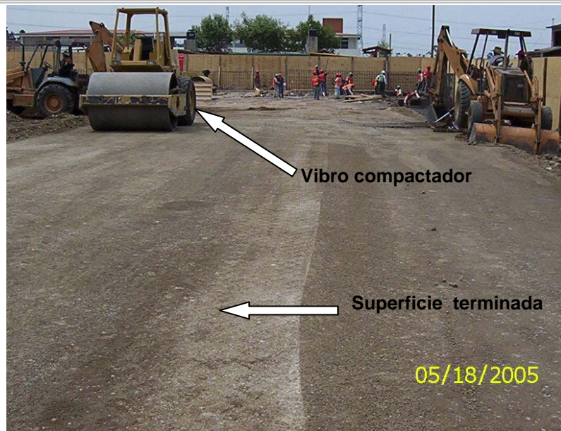
Foto III.2.2.10 Trabajos de compactación.
