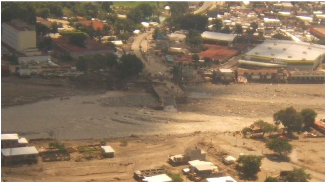
Figura 3.3 Restos del puente Coatán después del paso de la avenida, Octubre 2005.
