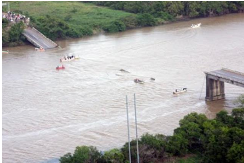
Ilustración 2 Colapso del Puente Tonalá
