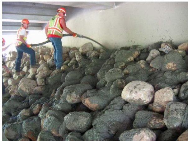
Figura 4.2 Inyección de concreto a material graduado
