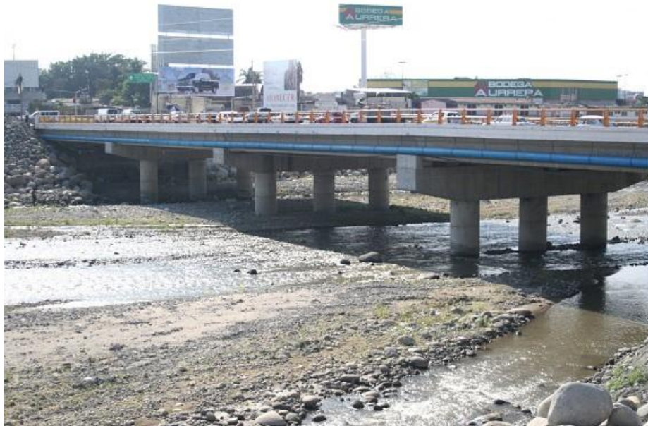
Figura 3.5 Nuevo puente Coatán, 2006
