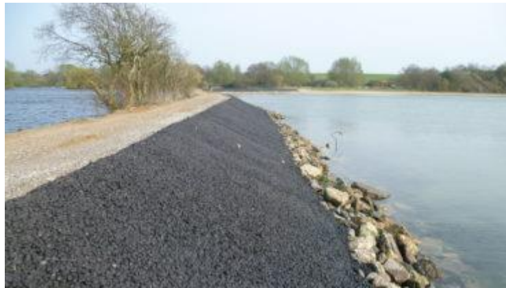
Figura 4.1 Protección de estribos en rio pavimento.
