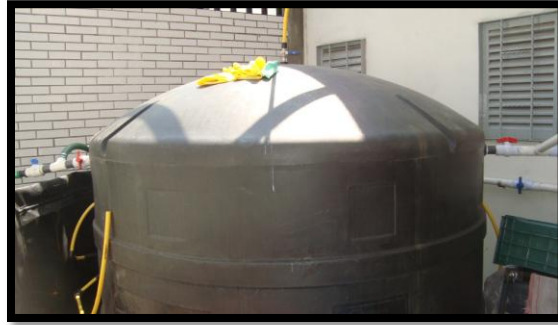
Figura 4. 7 Digestor de 5000 L
