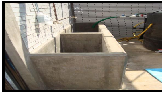
Figura 4. 8 Espesadores de lodos
