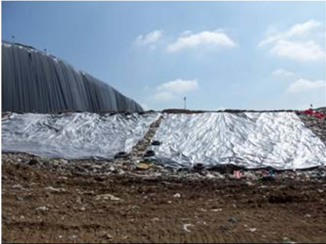
Imagen 4. Extensión de lona a lo largo del talud. Relleno Sanitario de Naucalpan de Juárez, Estado de México.
