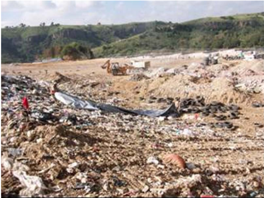
Imagen 2. Extensión de lona a lo ancho del talud. Relleno Sanitario de Naucalpan de Juárez, Estado de México.
