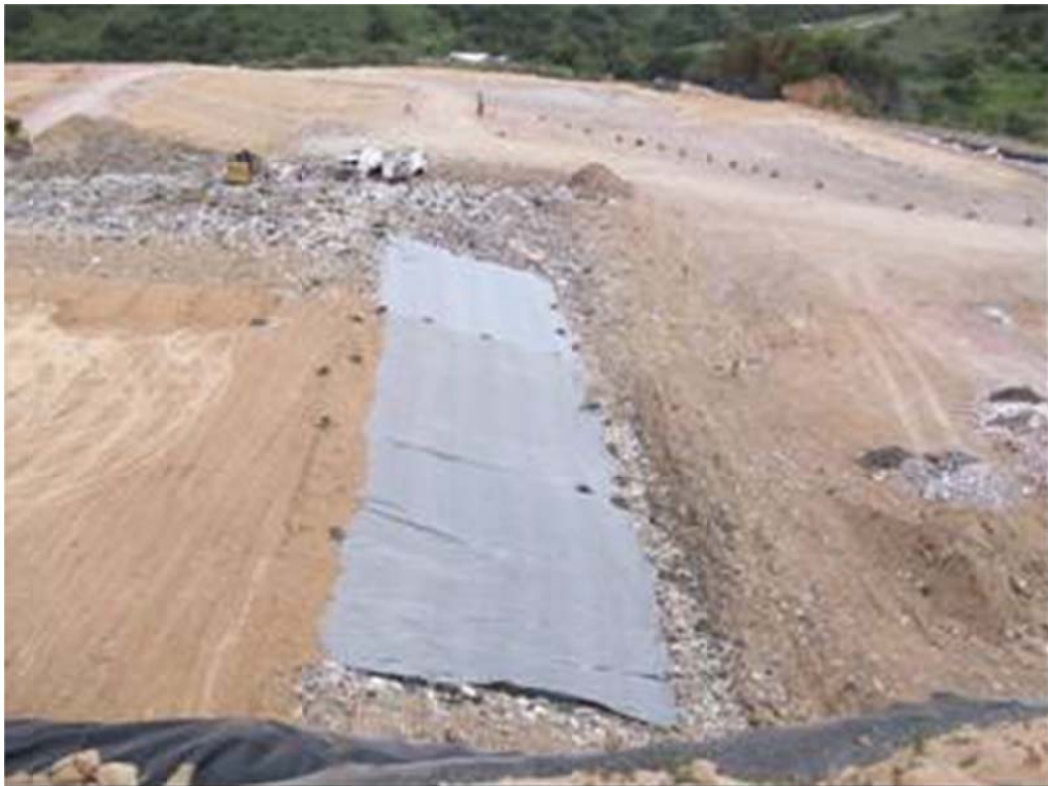
Imagen 5. Continuidad de lonas. Relleno Sanitario de Naucalpan de Juárez, Estado de México.
