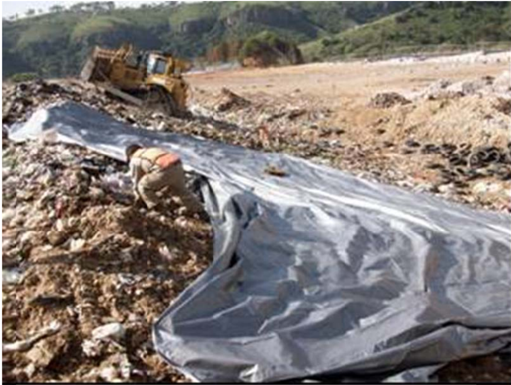
Imagen 3. Anclaje superior de lona. Relleno Sanitario de Naucalpan de Juárez, Estado de México.
