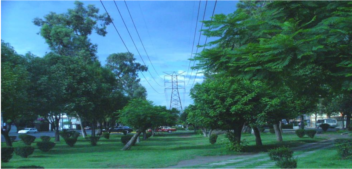
Figura 1.7 Vista de red de transmisión eléctrica aérea dentro de la Ciudad de México.
