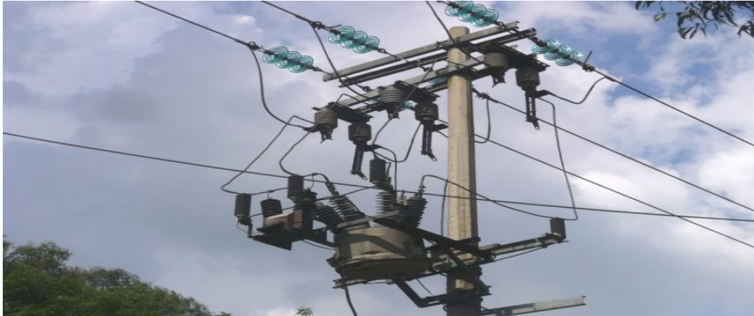
Figura 1.21 Reconectador automático de gas GVR (Gas Voltage Recloser).
