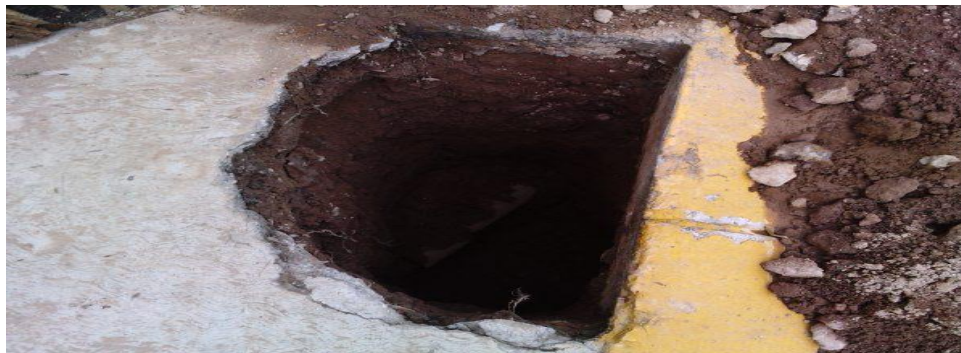
Figura 1.32 Excavación para poste de concreto reforzado.
