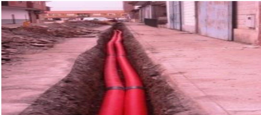
Figura 1.54 Tubería de PVC terminada y preparada para la instalación de red de baja tensión de cable subterráneo.
