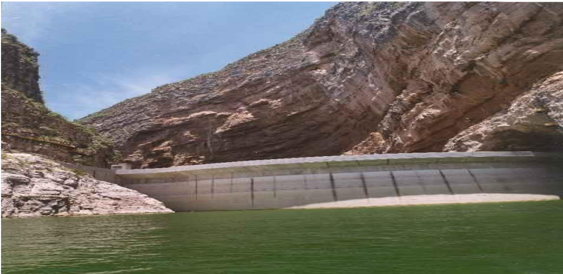
Figura 1.1 Presa hidroeléctrica Zimapán en el estado de Hidalgo.
