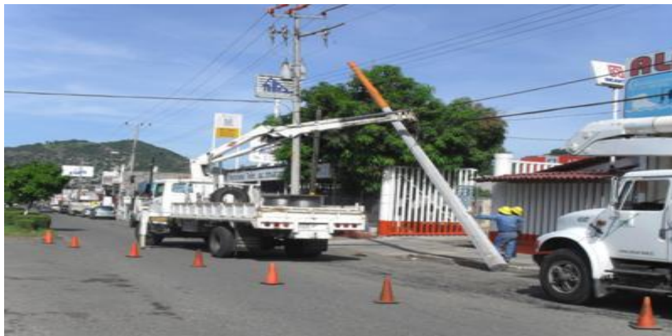
Figura 1.33 Brazo hidráulico colocando poste de concreto.
