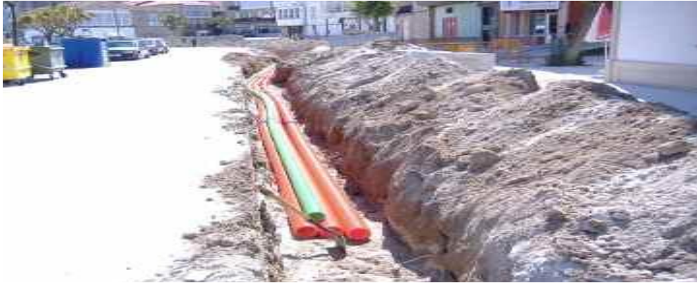
Figura 1.53 Preparación de tubería para instalación de red subterránea de baja tensión.
