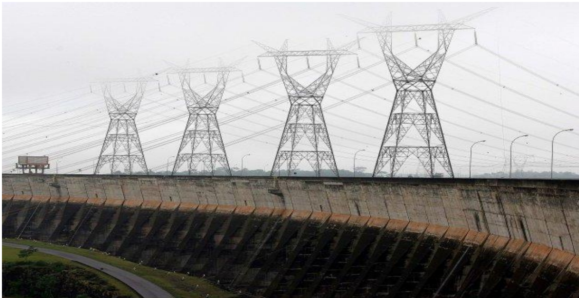
Figura 1.5 Salida de la subestación elevadora y transporte de la presa hidroeléctrica la Yesca, ubicada en el municipio de El Nayar en el estado de Jalisco.
