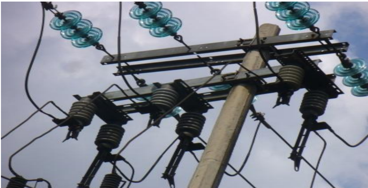
Figura 1.24 Cuchillas invertidas manuales con cortador.
