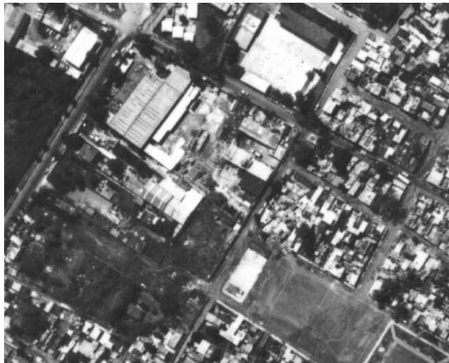
Figura 8.3. Fotografía aérea de la zona metropolitana. Esta fotografía es un fragmento tomado de la fotografía en la figura 8.1.
