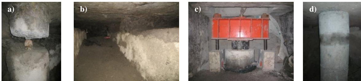
Figura 2.53 Trabajos de renivelación: a) desconexión de pilotes de fricción, b) subexcavación, c) liberación de tuercas y penetración del pilote y, d) reconexión de los pilotes de fricción.
