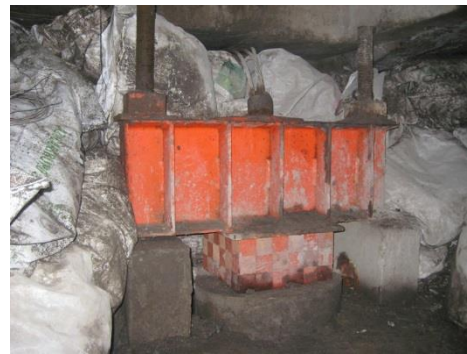
b) Con arreglo de tres niveles de 6×6 cubos de madera
