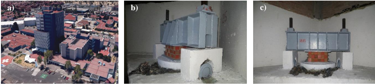
Figura 2.36 Hospital ubicado en la zona lacustre: a) edificio (Google Earth, 2016), b) y c) pilotes de fricción con sistema de control nuevo en la cabeza.
