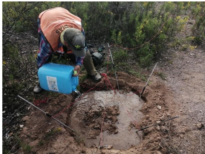
Fig. 4.8. Instalación e hidratación del electrodo remoto.
