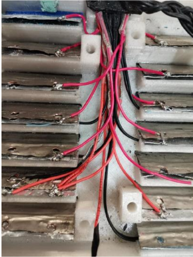
Figura 1.10. Conexión de los cables de monitoreo de voltaje. (UNAM Motorsports 2020)
