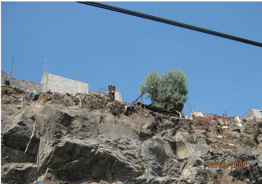
Figura 71. Retiro de árbol en zona inestable.
