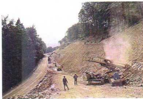
Ejemplo: Trabajos de perforación realizados empleando una máquina perforadora autopropulsada de cadenas.
