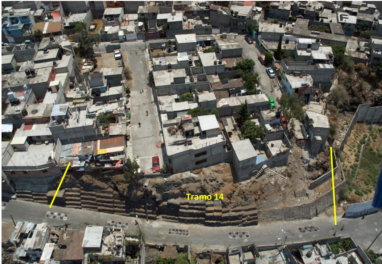
Figura 17. Vista aérea del tramo 14.
