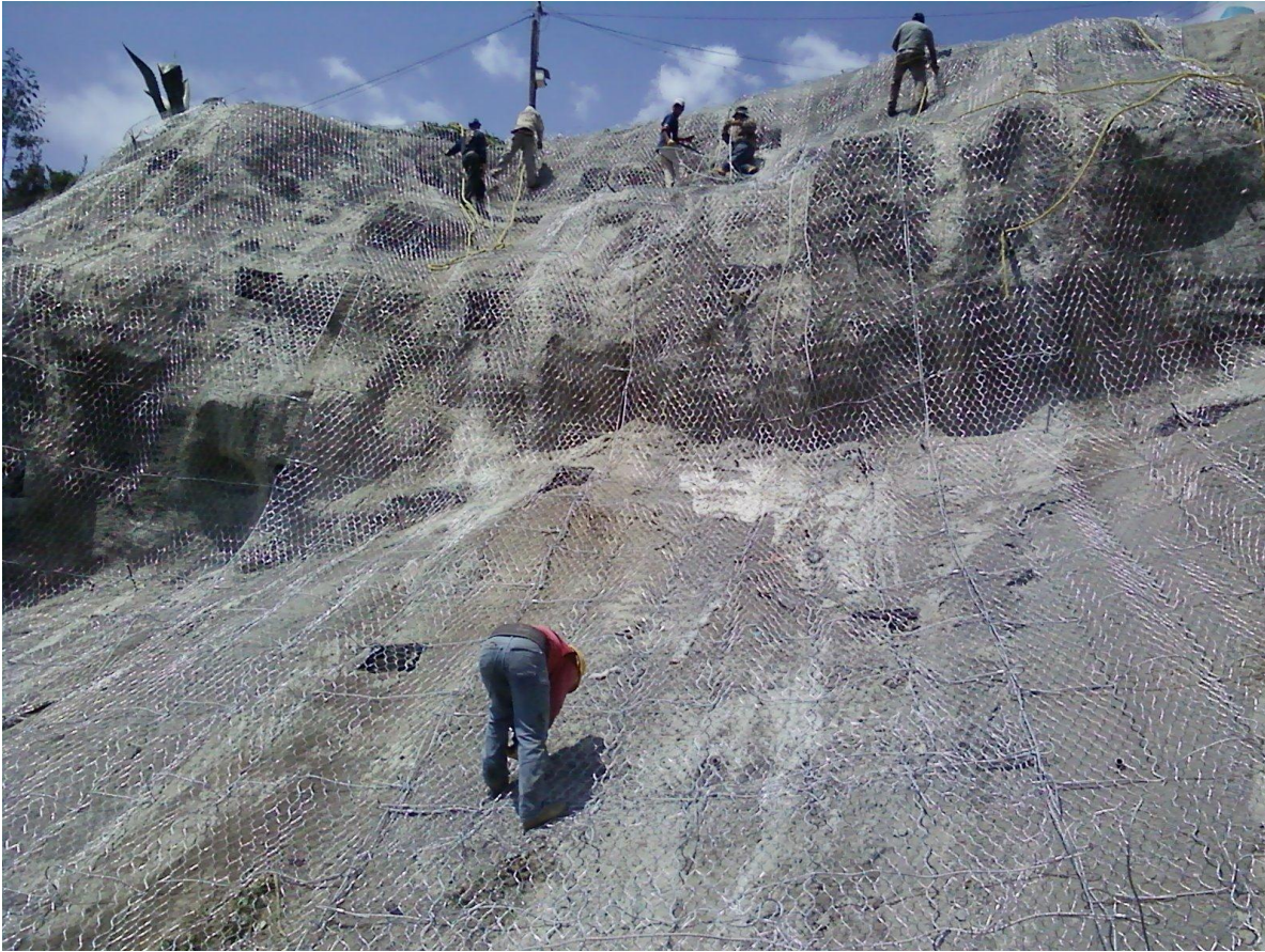
Figura 93. Colocación de malla triple torsión mixta reforzada con cable de acero.
