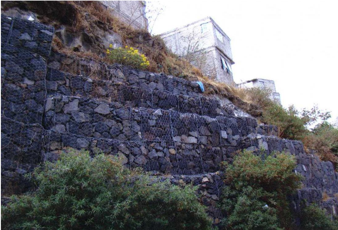
Figura 18. Muro gavión del tramo 14.
