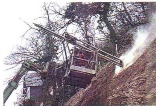
Ejemplo: Dependiendo de las condiciones del terreno, la perforación se ejecuta desde una plataforma soportada por una pequeña grúa o una plataforma colgada
