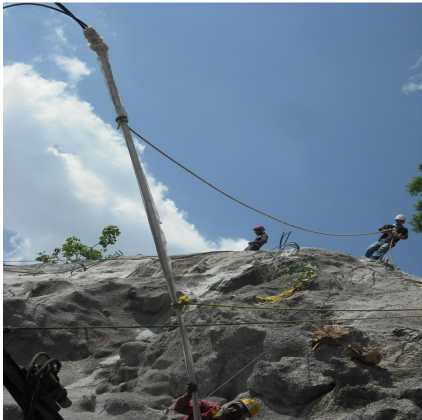
Figura 84. Colocación de anclas en zona de pendiente.
