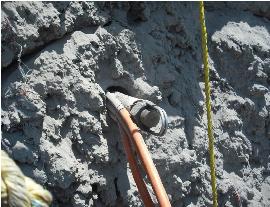
Figura 112. Lechada cemento-agua en talud de escoria volcánica y basalto brechoide.
