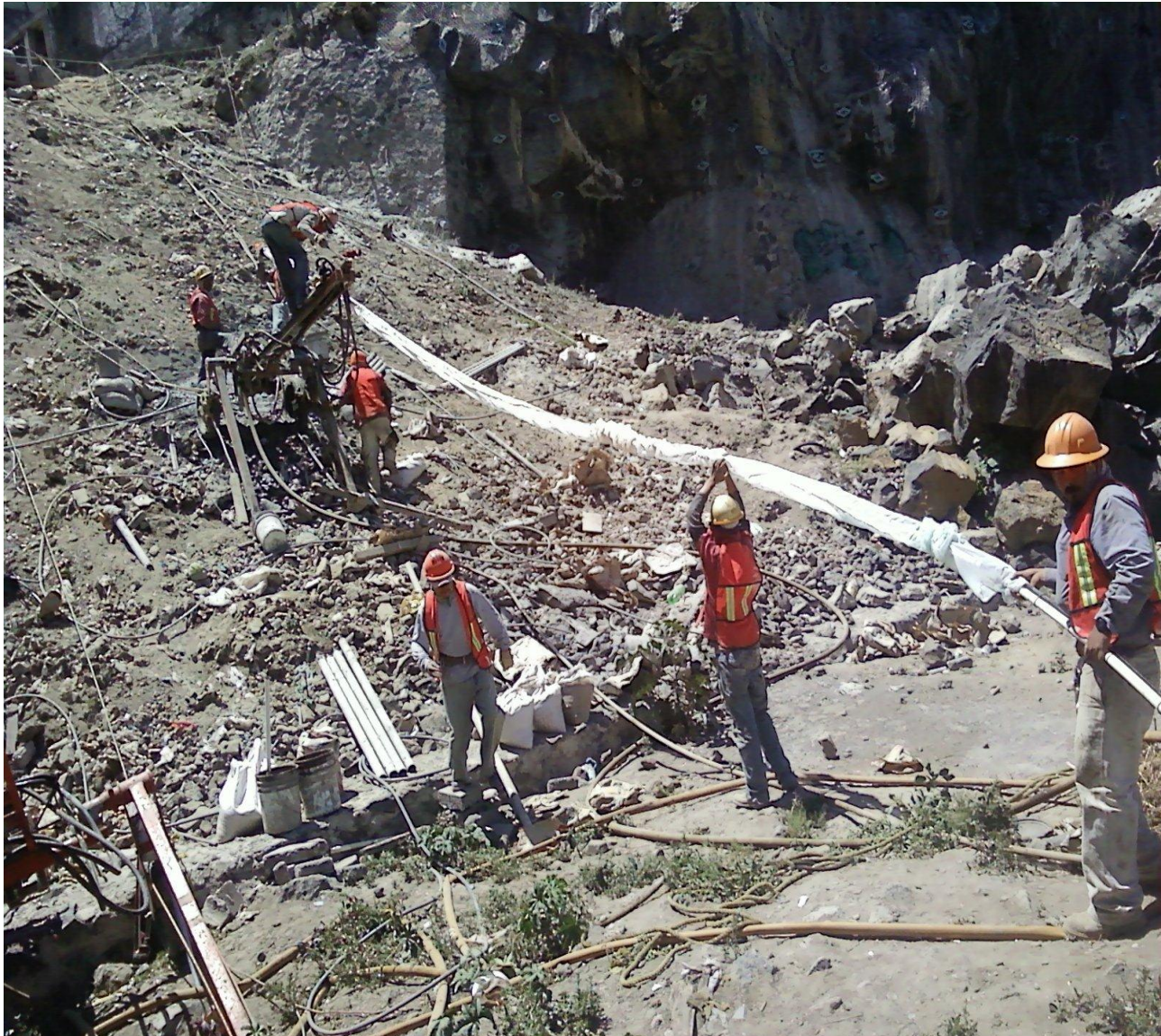
Figura 81. Colocación de anclas.
