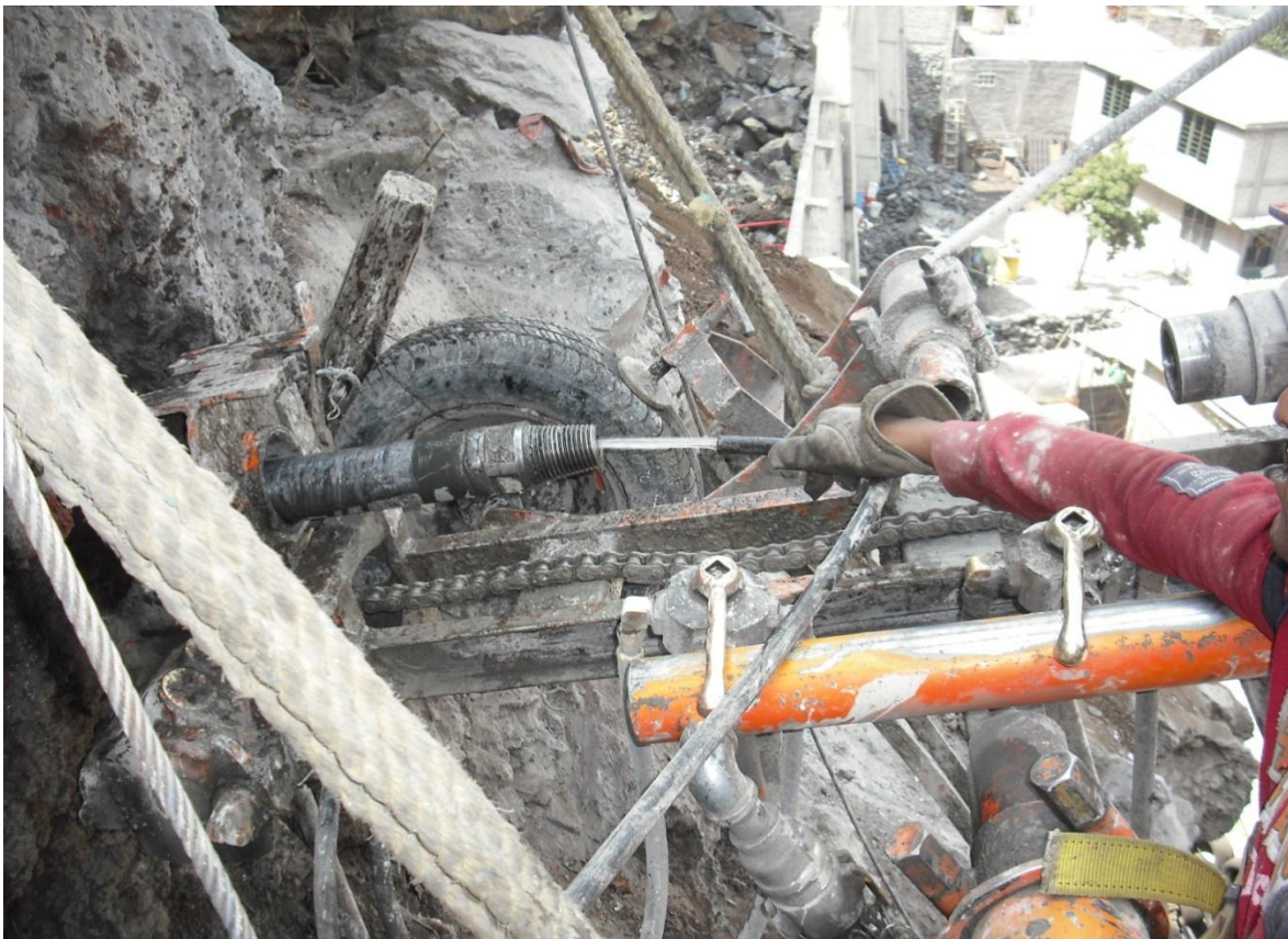
Figura 89. Colocación de producto químico (espuma y agua) para evitar la caída del barreno en estratos de arenas y evitar el polvo de la rezaga en lugares específicos.
