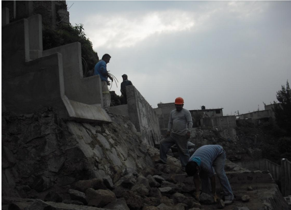
Figura 110. Construcción de lavadero tramo 14.
