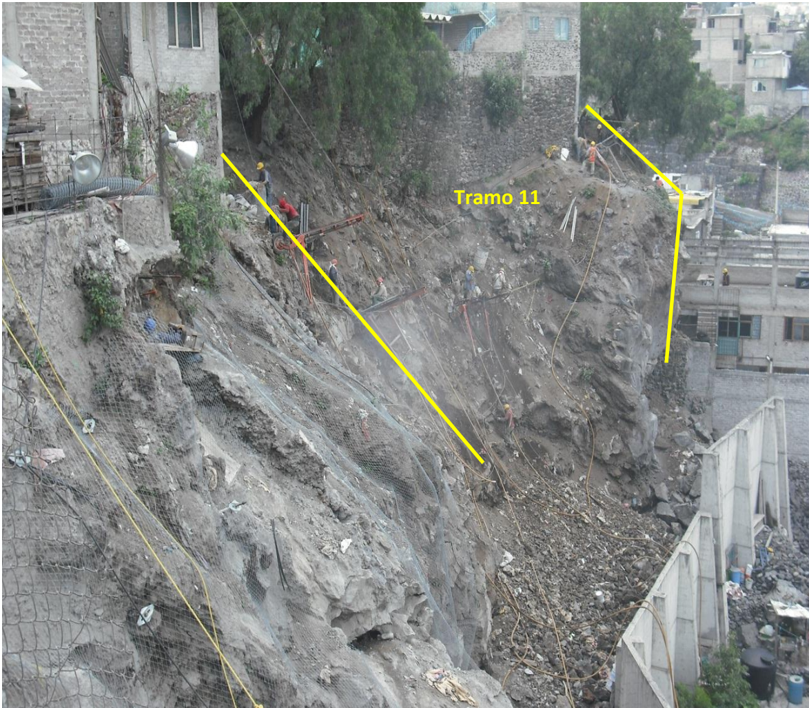
Figura 44. Vista frontal del tramo 11.
