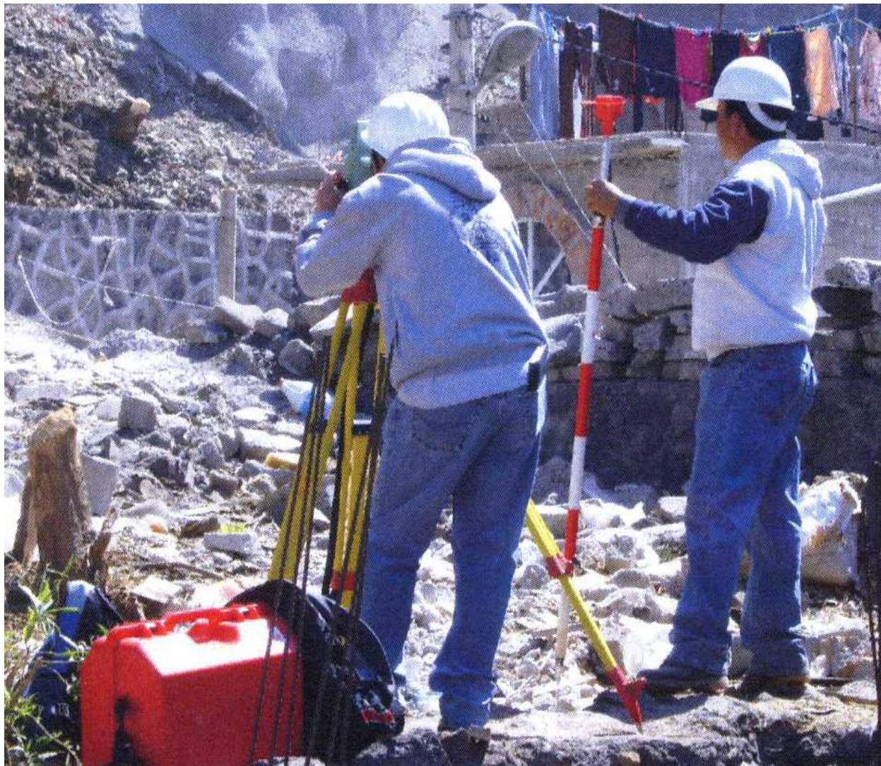
Figura 8. Equipo que utilizó la brigada de topografía.
