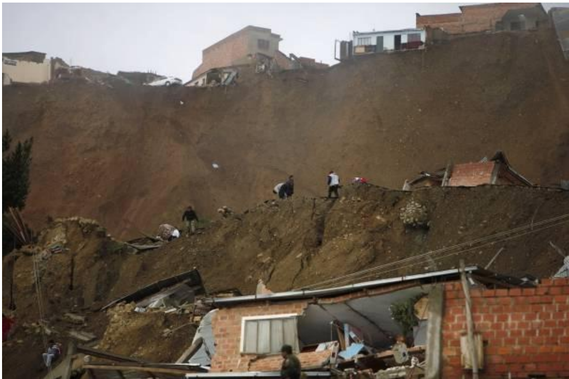
Figura 2. Ejemplo de un derrumbe o caído.
