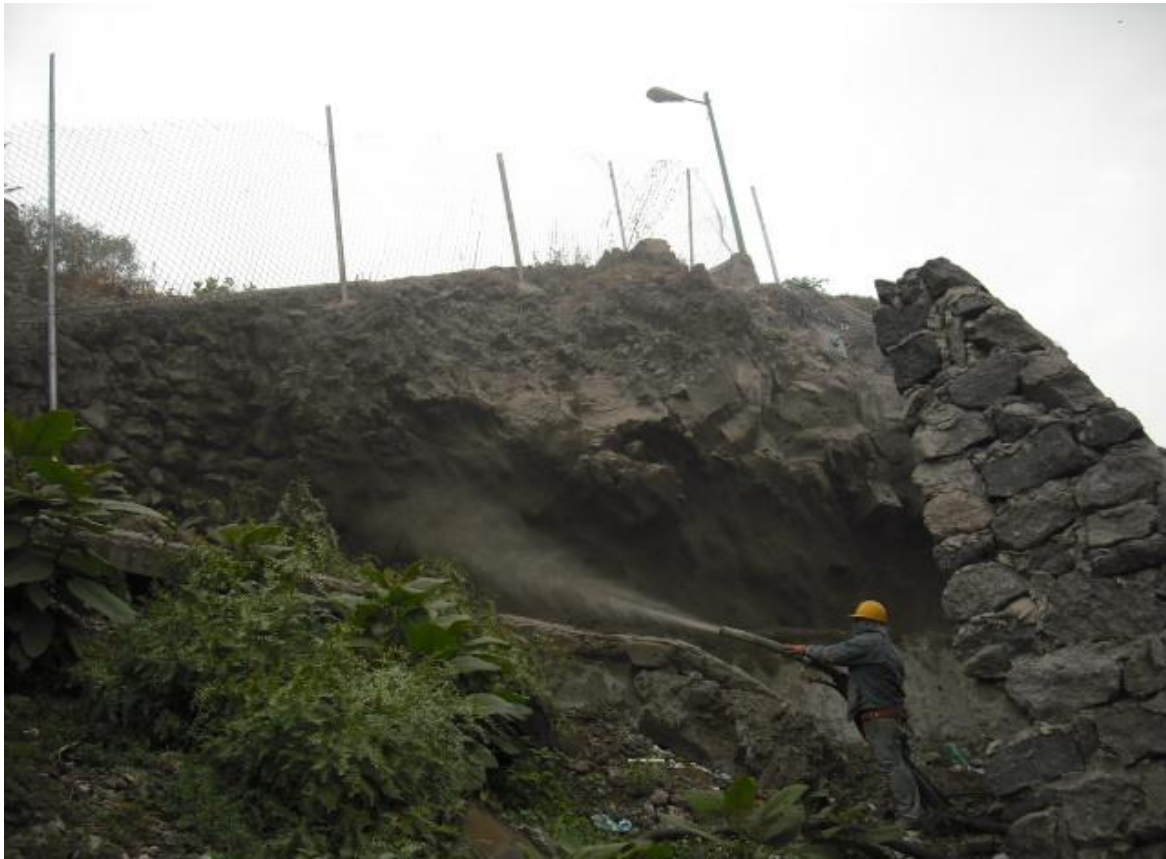
Figura 114. Lanzado de concreto vía seca.
