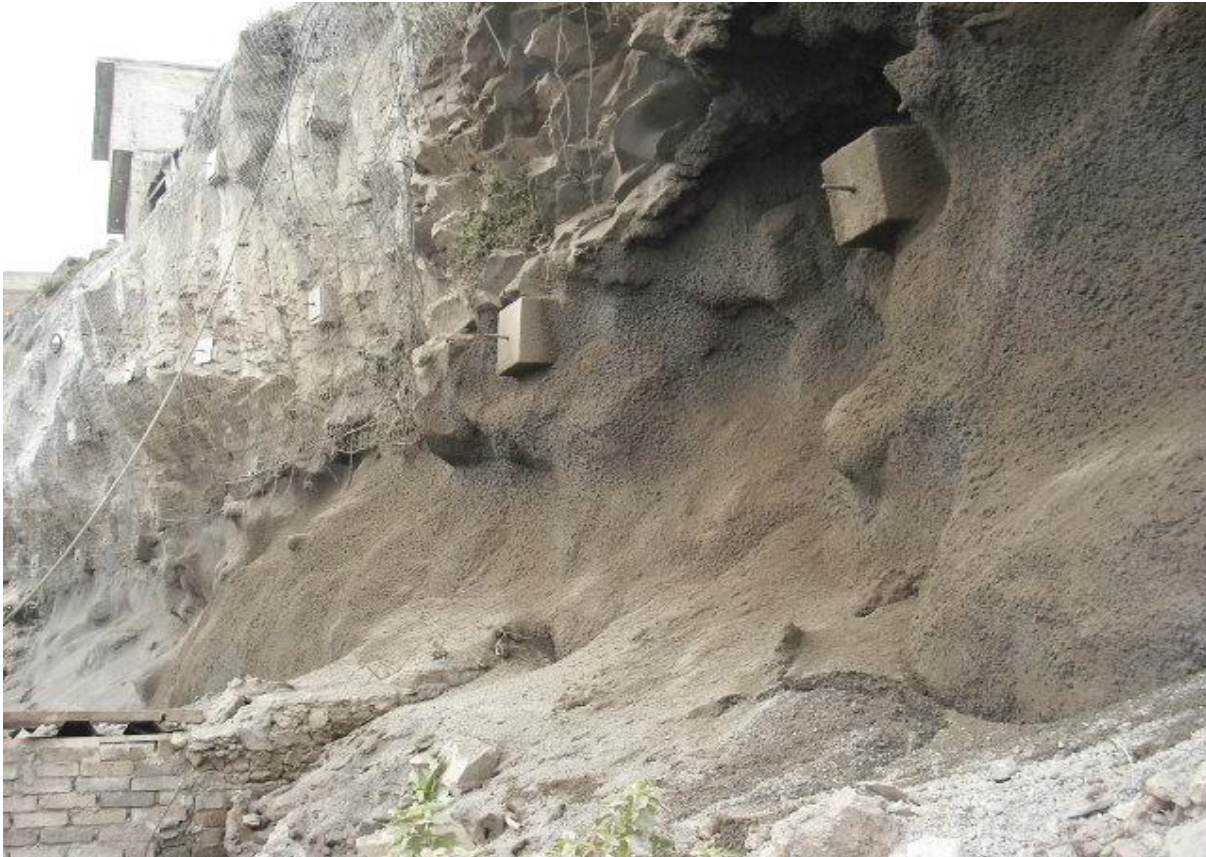
Figura 115. Concreto lanzado.
