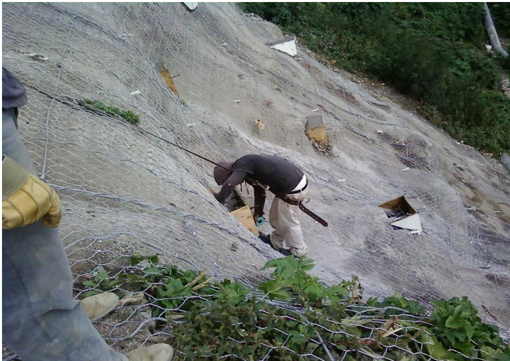
Figura 97. Preparación de zapatas en la cara del talud.
