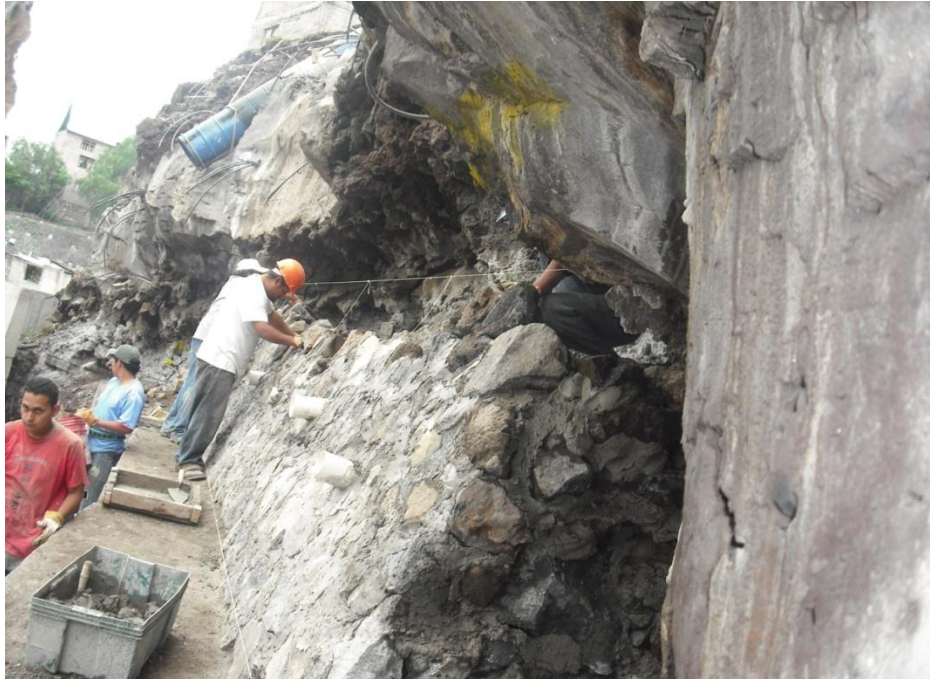
Figura 108. Conformación de muro de mampostería.
