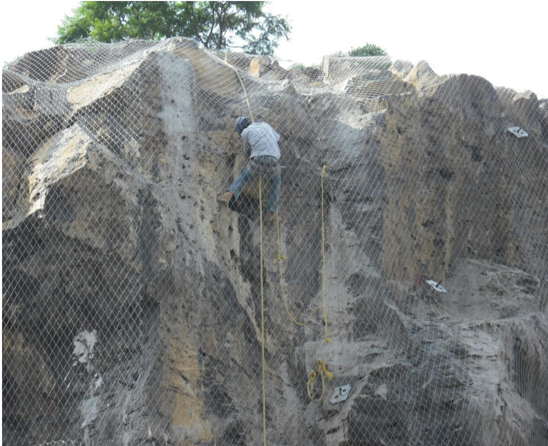
Figura 94. Colocación de malla de alta resistencia Tecco.
