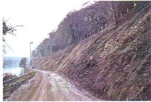
Medidas de preparación del terreno (limpieza, desbroce, cortes parciales, etc.)
