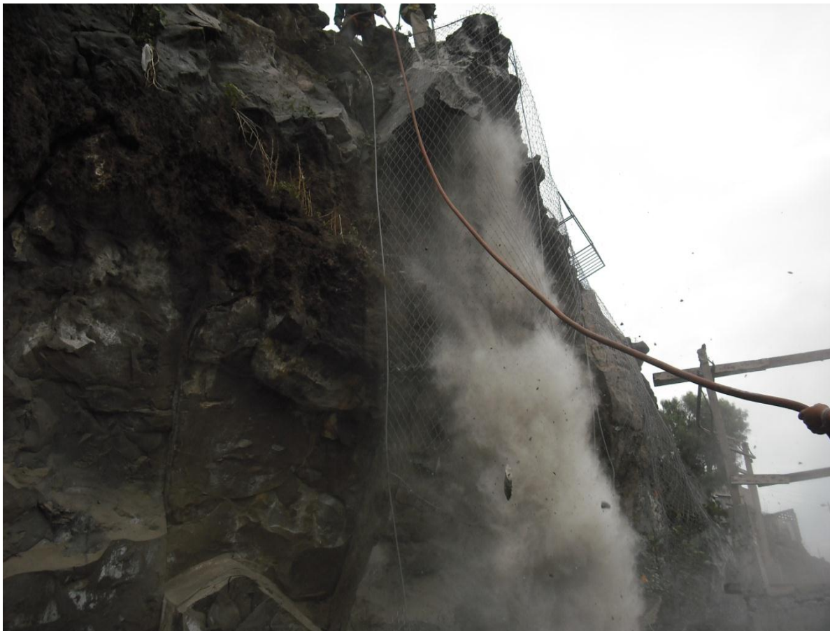
Figura 73. Retiro de bloques inestables en forma controlada.
