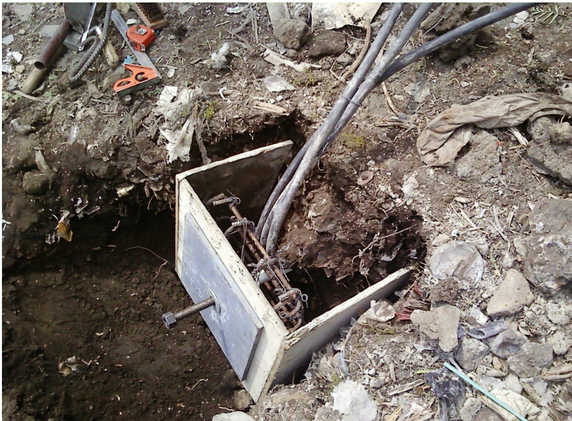
Figura 98. Armado de zapata.
