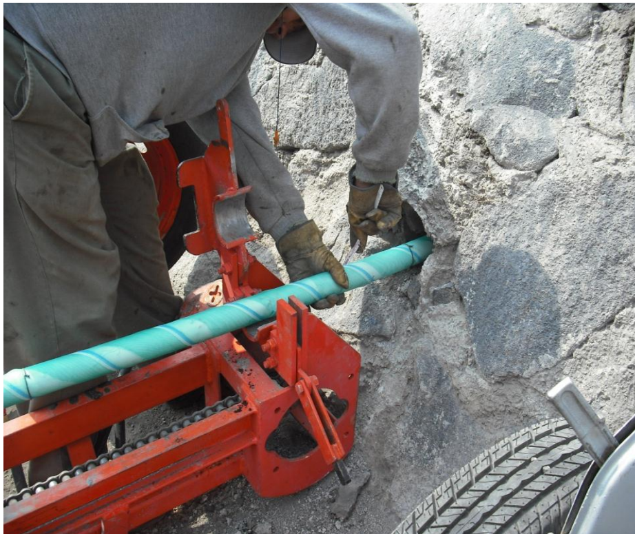
Figura 90. Colocación de dren transversal.
