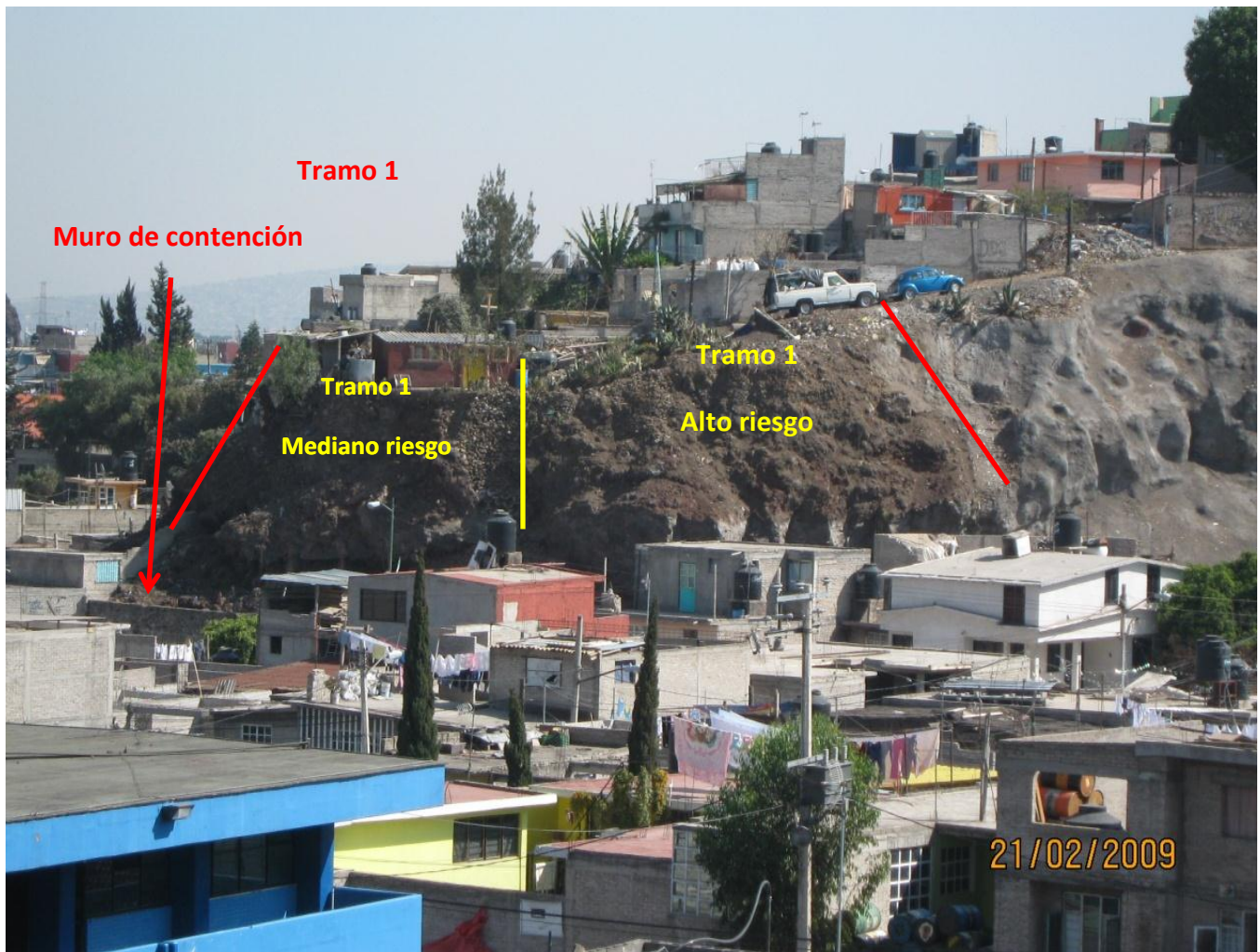
Figura 21. Vista frontal del tramo 1.
