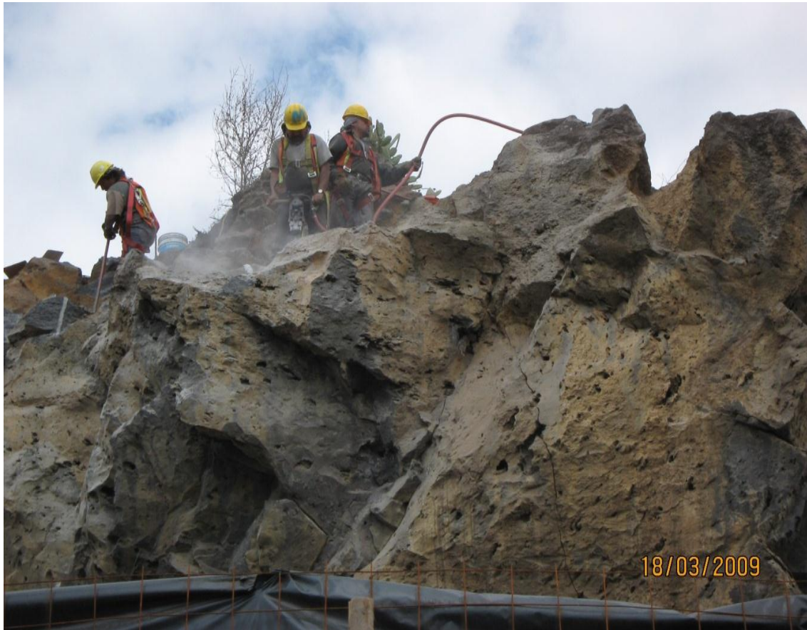
Figura 101. Preparación para aplicación de expansores químicos y retiro de bloques inestables.
