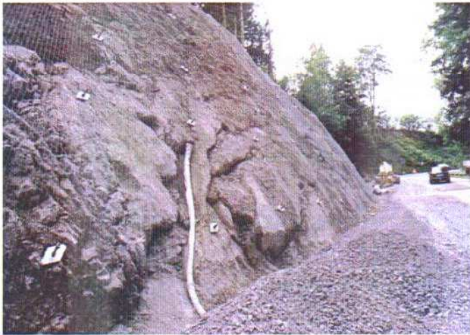
Ejemplo: Manguera de drenaje para extraer el agua del talud
