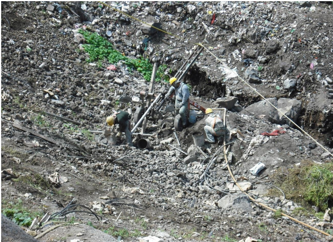
Figura 77. Perforación en talud.
