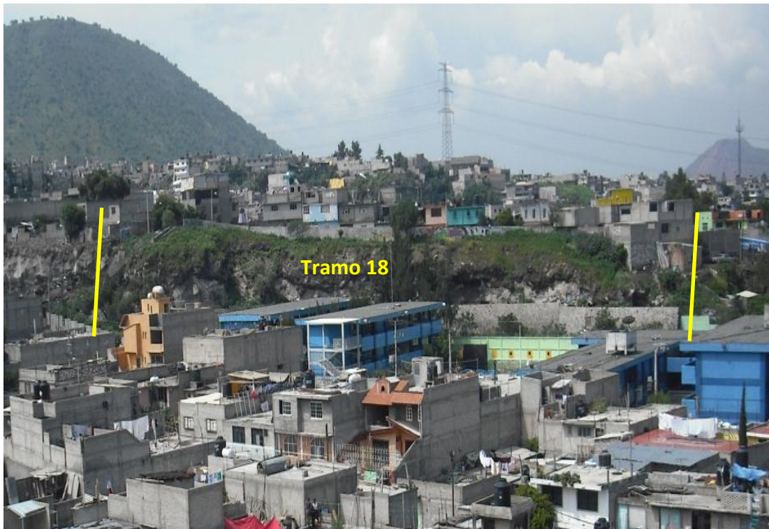
Figura 33. Vista frontal del tramo 18.
