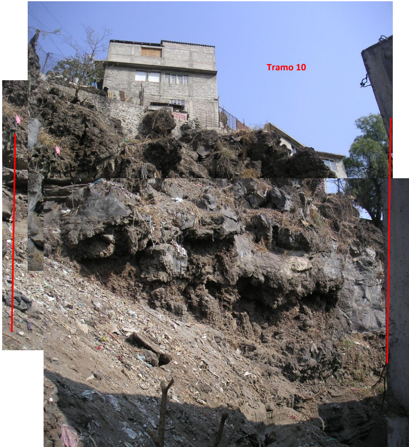
Figura 42. Vista frontal del tramo 10.
