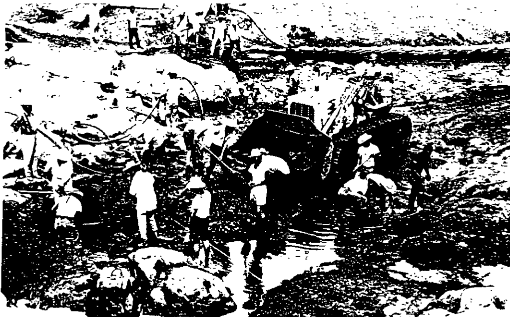
Foto 19. Presa Guamuchil Sin. Limpia de "dedo" en el fondo del río, después de haber excavado con máquinas el relleno de aluviones en el cau- ce.-
