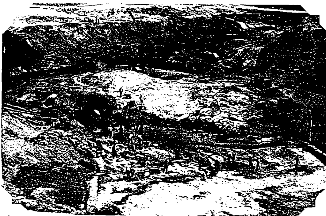
Foto 2I-22. Presa Guamuchil Sin. Aspecto ya terminada la limpia de "dedo" en el cauce del río.- En la parte central se aprecia una perforadora de o- ruga para los barrenos de inyección.- En la parte su- perior derecha se ve las instalaciones para el mezcla- do y bombeado de lechada.-
