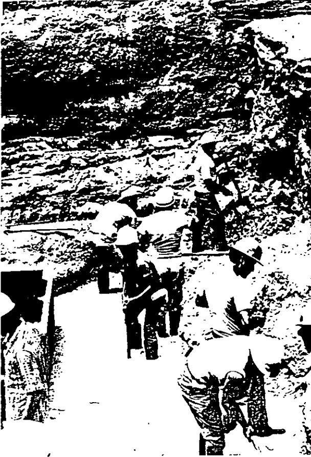
Foto 22. Remoción a mano de estos materiales de lo que ya no pudo excavar la retroexcavadora.
