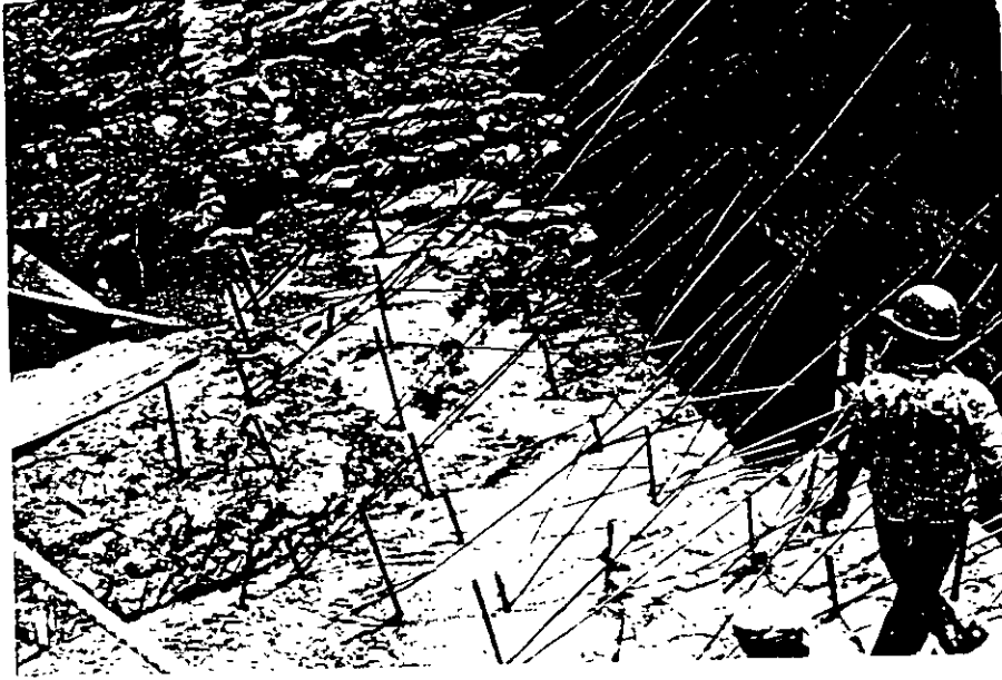
Foto 32. Aspecto del fondo con sus lozas coledas. Estas lozas sirvieron de apoyo para las inyecciones de tapete y pantalla.
