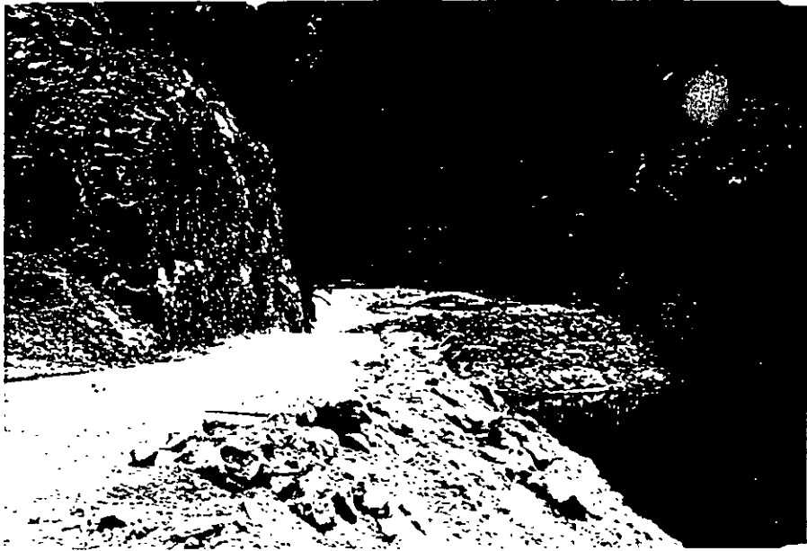
Foto 3. Ataguía de Aguas Arriba y túnel de desvío No. I.
