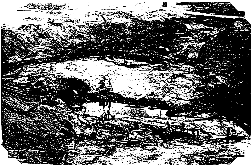
Foto 2I-22. Presa Guamuchil Sin. Aspecto ya terminada la limpia de "dedo" en el cauce del río.- En la parte central se aprecia una perforadora de o- ruga para los barrenos de inyección.- En la parte su- perior derecha se ve las instalaciones para el mezcla- do y bombeado de lechada.-
