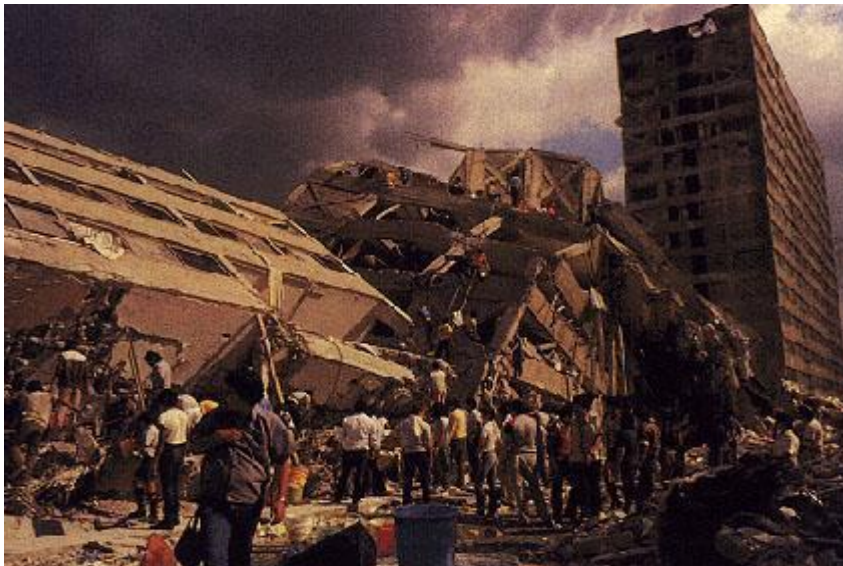
Figura 1.4 Edificio Nuevo León, México 1985 (Cárdenas, 1998)
