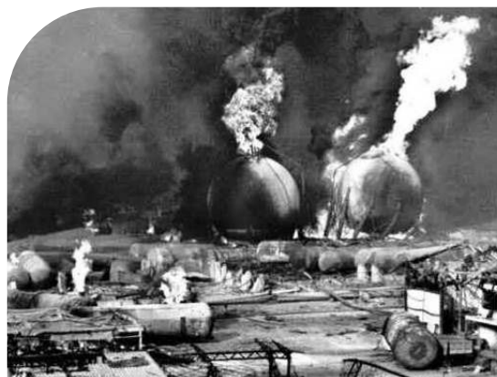
Figura 1.19. Chorros de fuego desde esferas de gas licuado del petróleo (CENAPRED, 2019)
