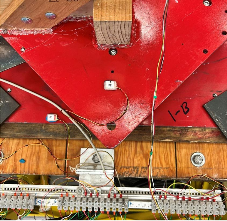
Figura 17. Vista en planta de acelerómetros CH01 y CH02.
