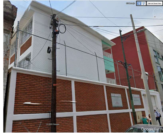
Otro ángulo de la fachada y del edificio de aulas con tres niveles cercano al acceso. (Google Earth 2025)
