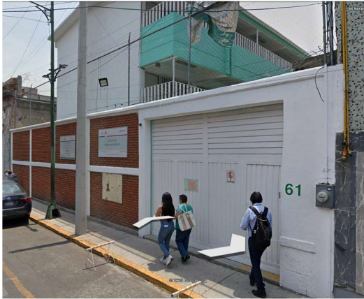
Vista de la fachada Principal y Acceso desde la Calle de Naranjo no. 61 y del edificio de aulas con tres niveles. (Google Earth 2025)
