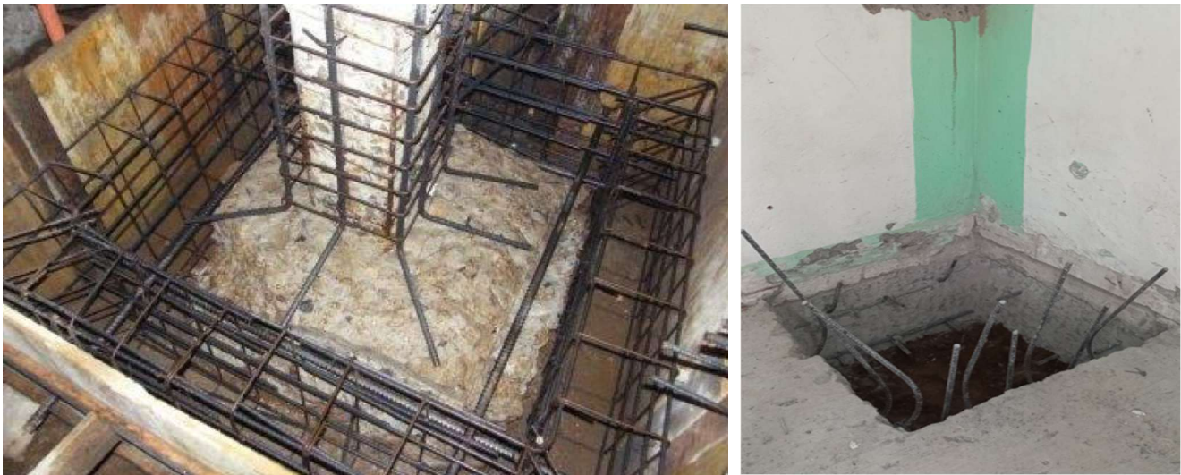
Ampliación y continuación de zapata
