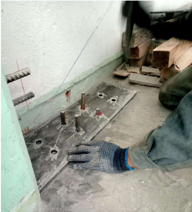
Colocación de barrenos coincidentes con las placas para colocar cabezales de contraventeos
