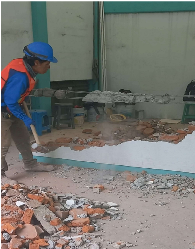
Demolición de muros para integración de contraventeos
