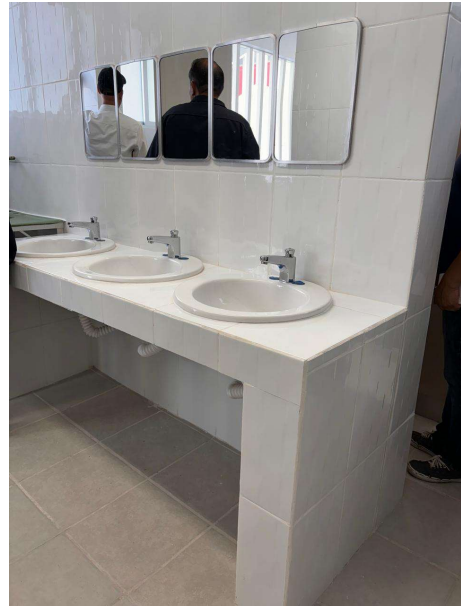
Colocación de muebles sanitarios
