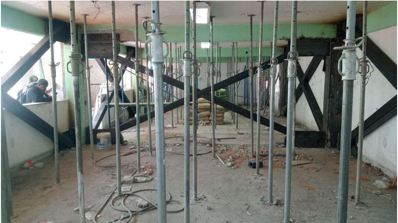
Colocación de cabezales y contraventeo
