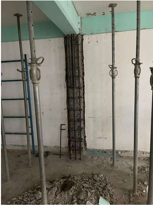
Reforzamiento metálico de columnas
