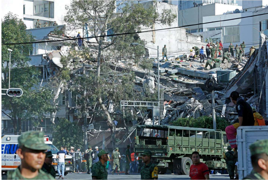
Imagen 7. – Daños del Sismo de 2017
