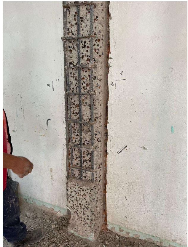
Escarificación de columnas
