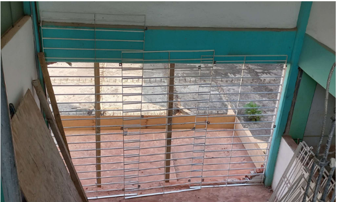
Retiro de cancelería
