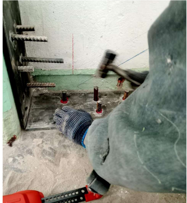
Colocación de barrenos coincidentes con las placas para colocar cabezales de contraventeos
