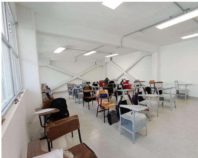
Colocación de luminarias
