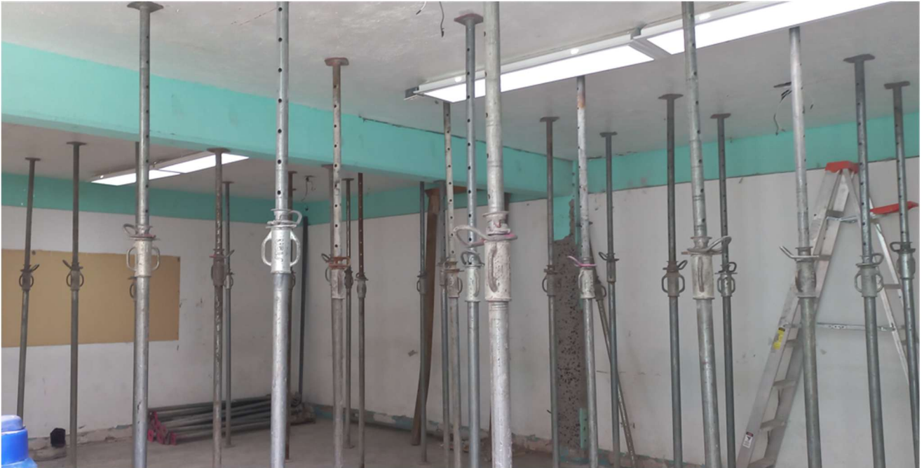
Apuntalamiento de losas
