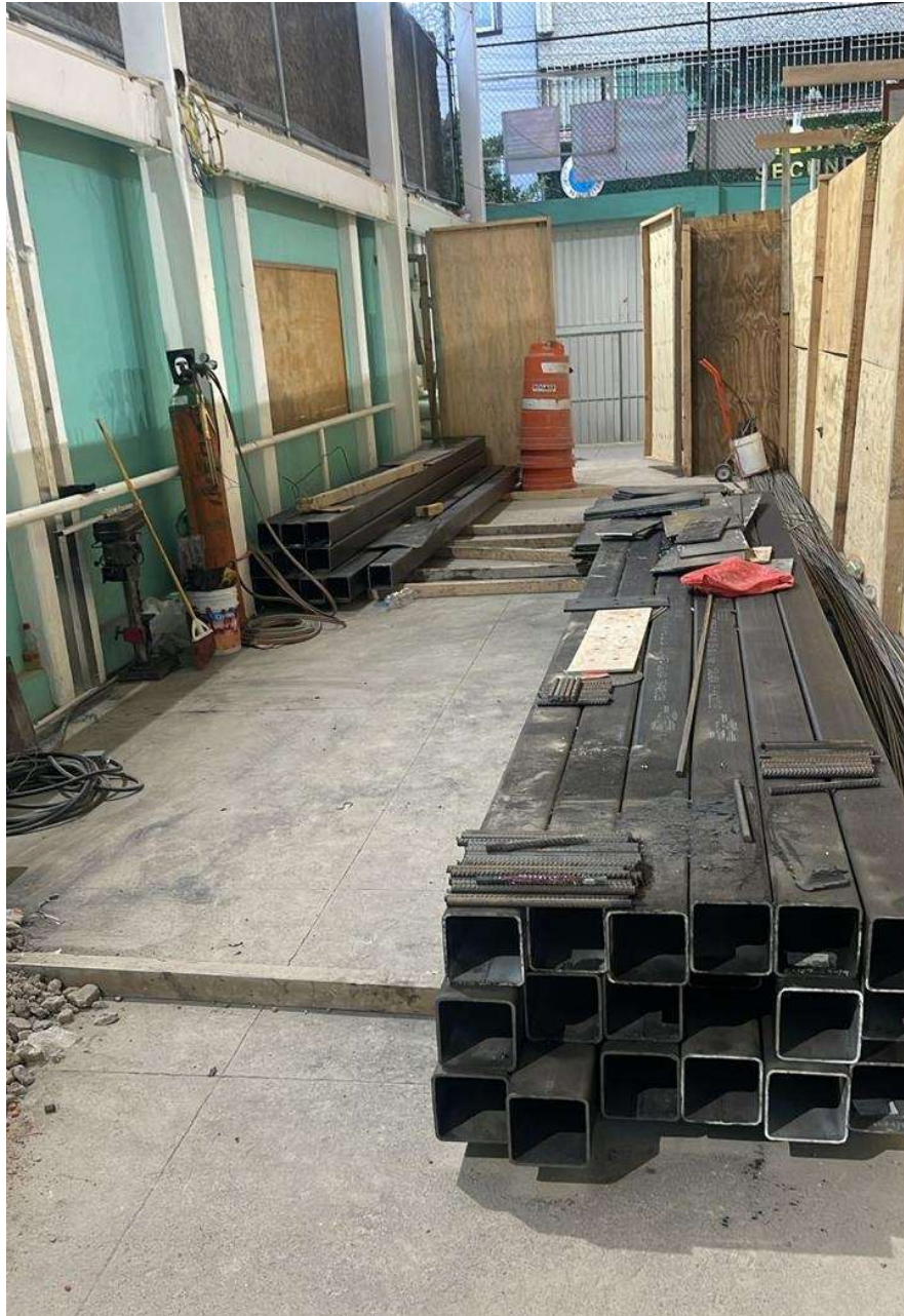
Tapial y bodega de materiales
