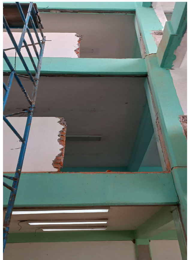
Demolición de muros para integración de contraventeos
