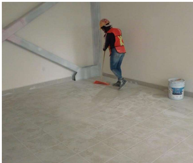
Colocación de acabados en pisos
