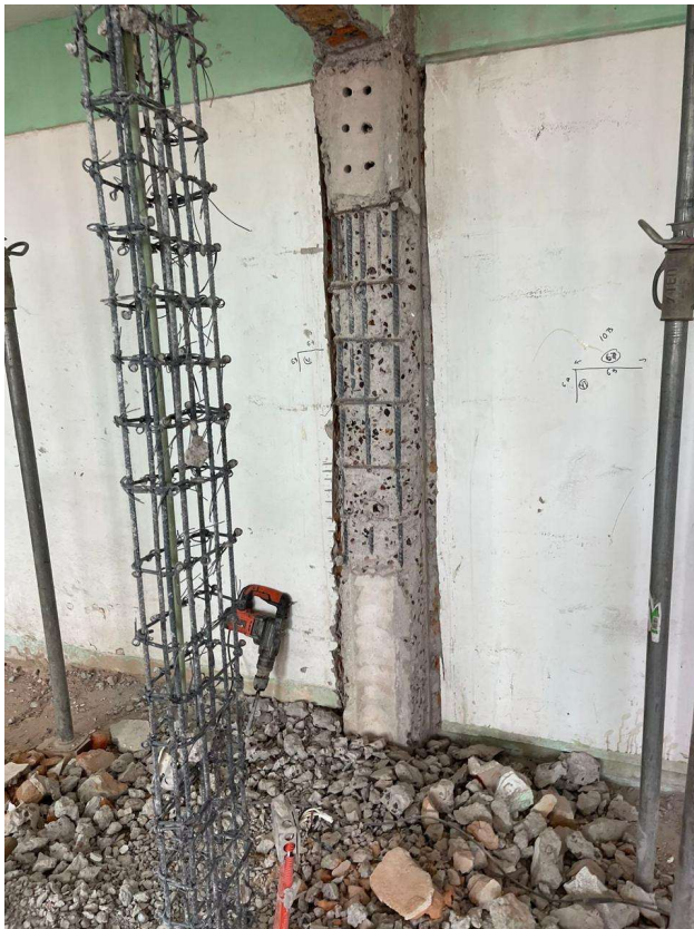
Escarificación de columnas
